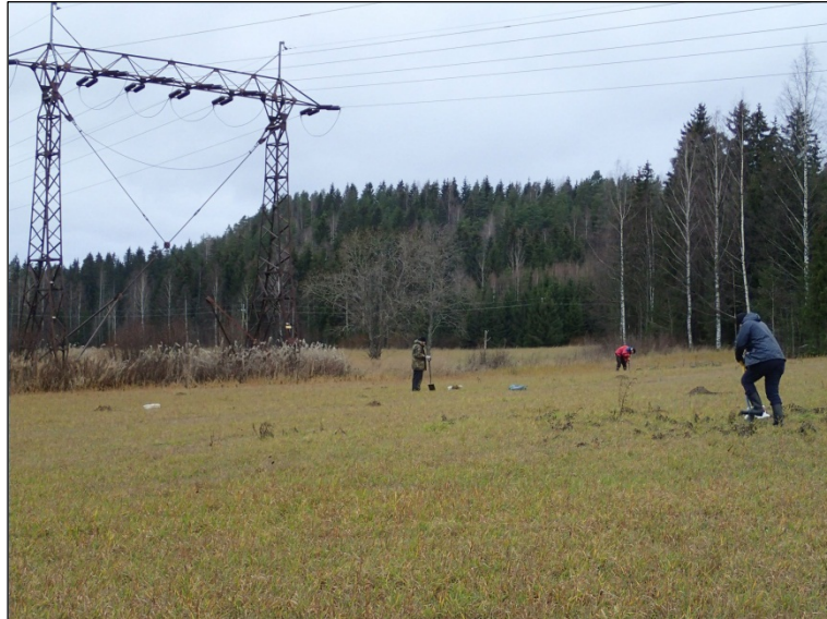
Koekuopitusta pylvään nro 75 paikkeilla
