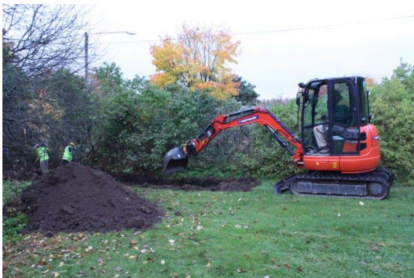
DG2962:7. Paksu puutarhamultakerros poistettiin kaivinkoneella. Idästä. Kuvaaja: Petro Pesonen.
