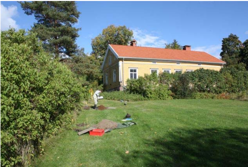
DG2962:1. Koekuoppien kaivua Pappilan puutarhaan viemäri- linjan kohdalla. Etelästä. Kuvaaja: Petro Pesonen.
