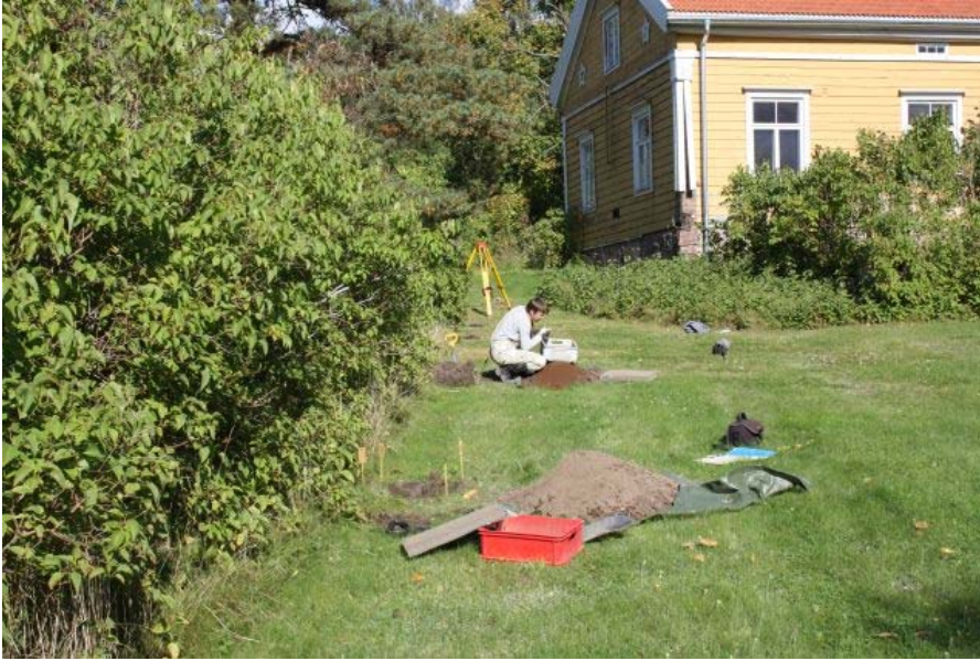
DG2962:2. Koekuoppien kaivuu- ta Pappilan puutarhaan viemäri- linjan kohdalle. Etelästä. Kuvaa- ja: Petro Pesonen.
