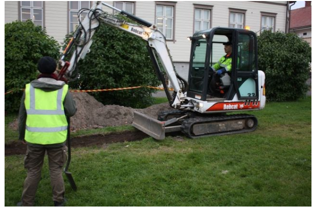
AKDG2735:56. Kaivinkonetta käytettiin purkukerrosten kaivamiseen. Koeoja 1 työn alla. Idästä. Kuva Ville Rohiola.
