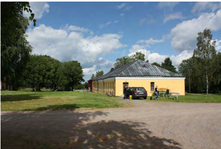
DG2711:2. Yleiskuva tutkimusalueesta, kaupunginarkiston rakennus. Suunta S-N. Kuvaaja: Petro Pesonen.
