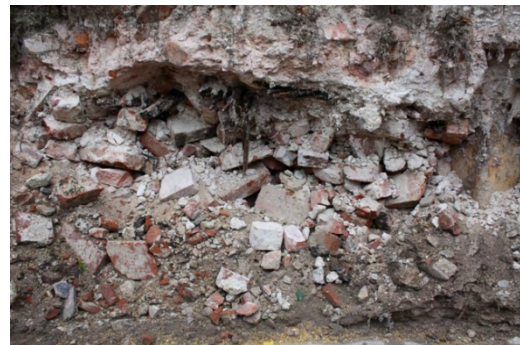
DG2711:15. Vankilan kellarin romahtanutta kattoa R115. Suunta E-W. Kuvaaja: Petro Pesonen.
