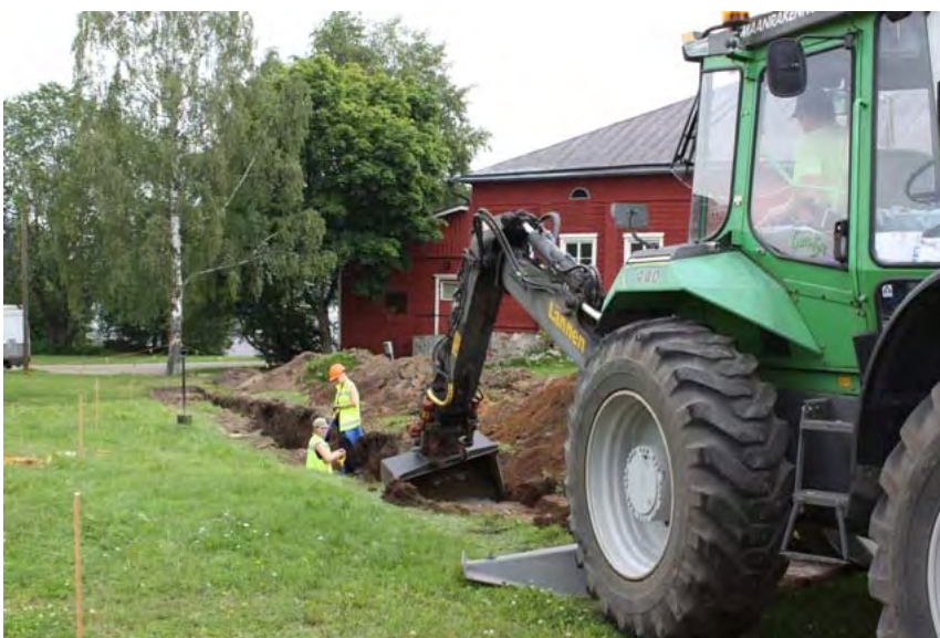
DG2711:4. Koeajaa 2 kaivetaan. Suunta SW-NE. Kuvaaja: Petro Pesonen.
