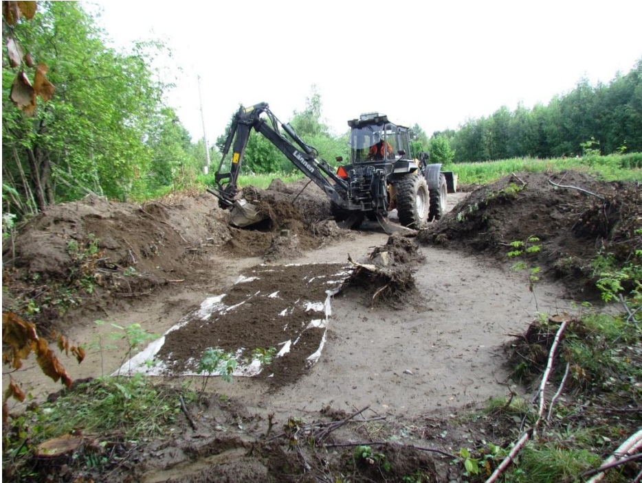
Kuva 2. Kaivausalueella B sijainnut likamaa-alue peitettiin harsolla ja suojaavalla maakerroksella. (Kuva: Kirsi Luoto 2012/ 201215_15)
