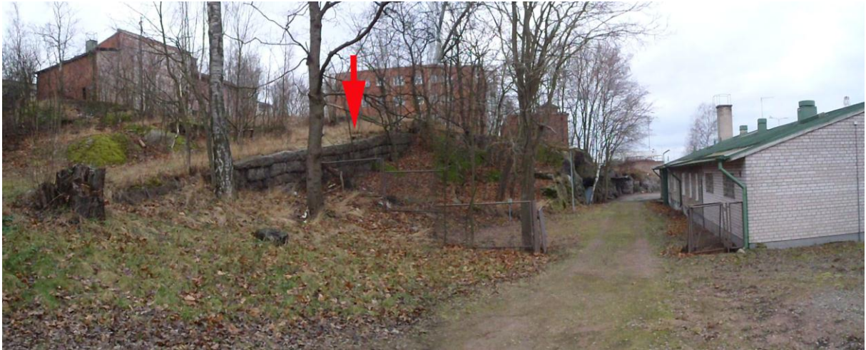
Kuva 5: Kuvassa keskellä nuolen kohdalla näkyy ns. välitontin (Ruukinkatu 15) laelle vievä ja kivimuurilla tuettu tie. Oikealla näkyy viereiselle tontille (Satamakatu 1) 1950-luvun alussa rakennettu Kotkan sataman nosturin käyttäjien versta- ja huoltorakennus, joka ei enää ole vakituksessa käytössä. NE. KyM/M. Kykyri.
