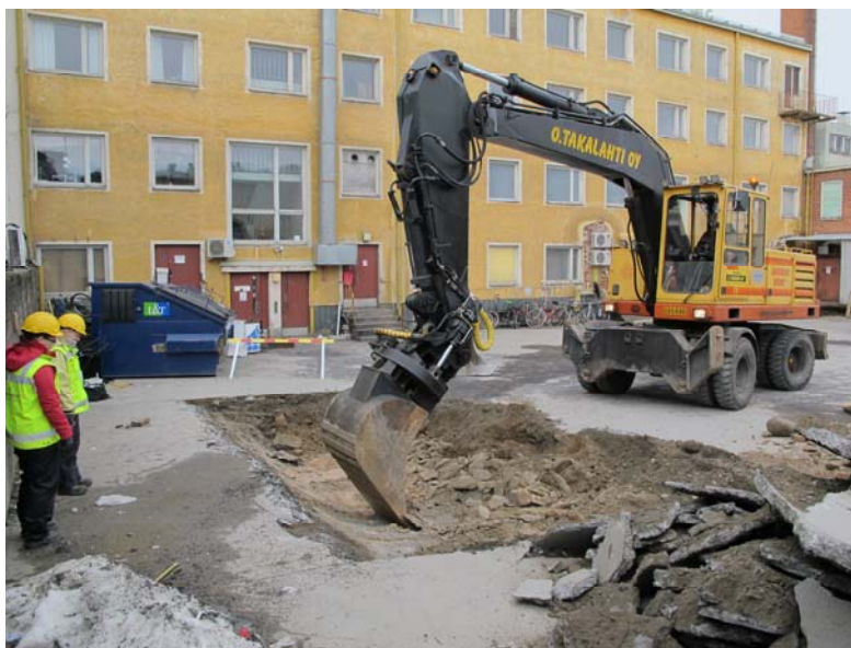
Kuva 1. Koeojaa/kaivausaluetta A avataan.
