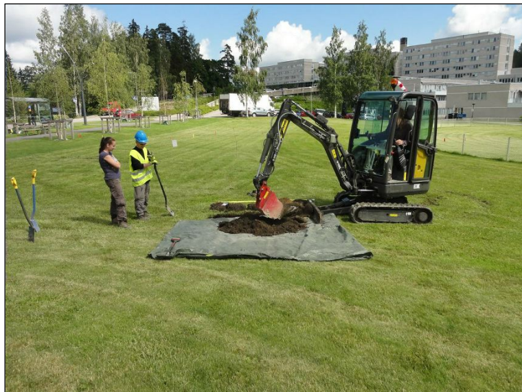
Koekuoppaa kaivetaan nurmikolle
