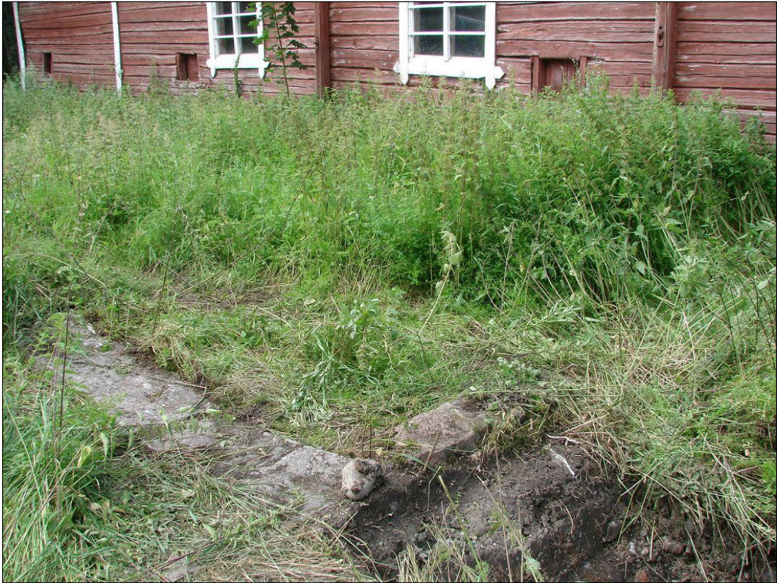
Rakennuksen kivijalka talousrakennuksen takana. Kuva: Hannu Poutiainen
