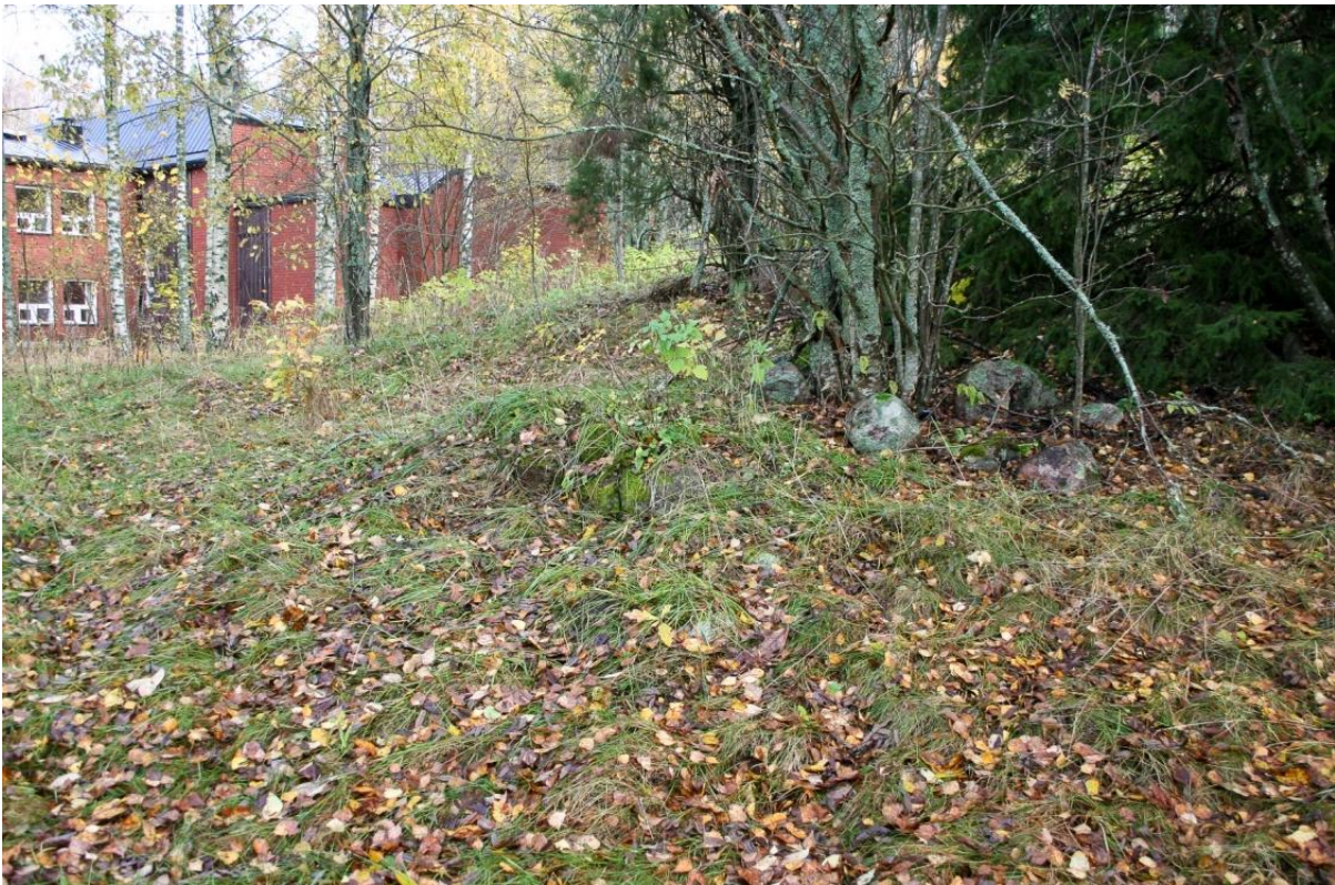
Kuva 14. Vuoden 2009 inventoinnissa löytynyt kiveys vaikuttaisi ennemminkin rakennuksen nurkalta, kuin uunilta. Kuvattu etelästä. Kuva: Satu Koivisto/MV (AKDG2854:1).
