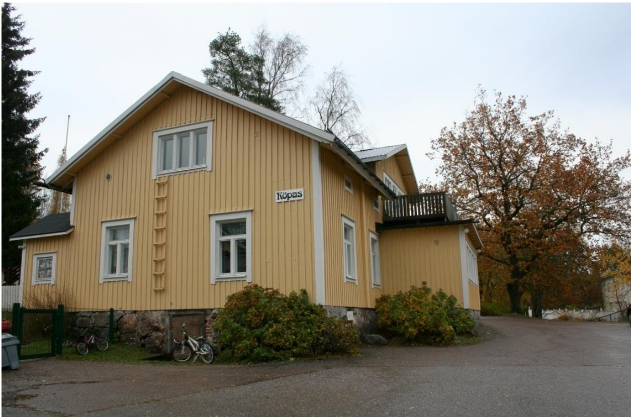
Kuva 21. Vanhoja luonnonkiviä on hyödynnetty rakennuksen kivijalassa merkinä paikalla olleista vanhemmista rakennuksista. Kuvattu lounaasta. Kuva: Satu Koivisto/MV (AKDG2889:1).
