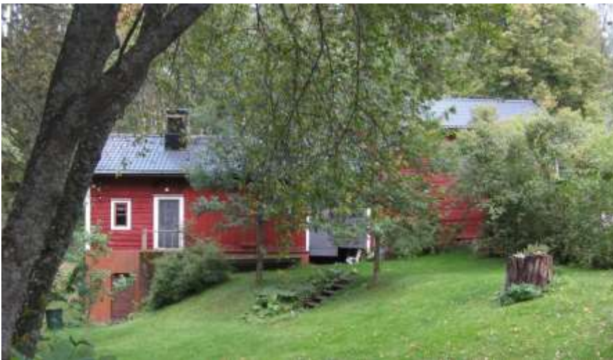
TYAdigi 39.34. Pihan länsireunan ulkorakennus etelästä. Kuva H.-M. Pellinen.
