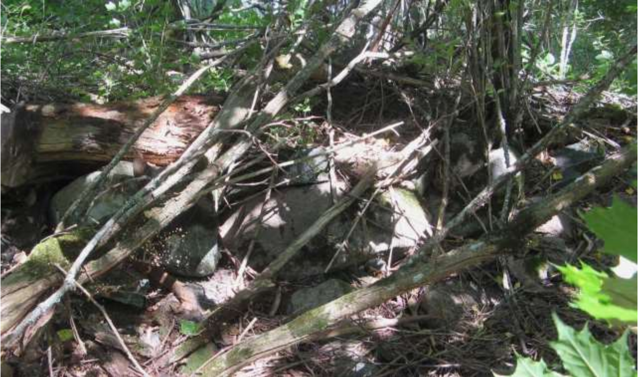
TYAdigi 39.52. Kivilatomusta pusikon keskellä, rantaan johtavan tien pohjoispuolella. Kyseessä on nähtävästi 1810-luvulla rakennetun ja vuoteen 1899 mennessä puretun pappilan päärakennuksen kivijalka, johon on myöhemmin koottu uudempien rakennusten purkujätteitä. Kuva H.-M. Pellinen.
