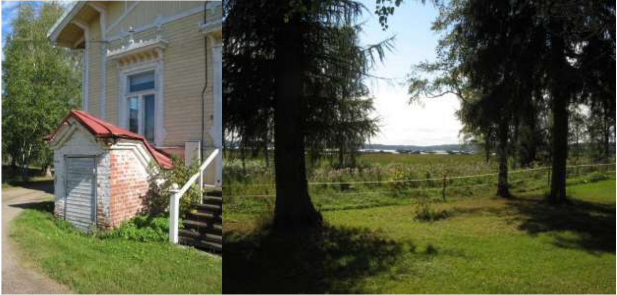
TYAdigi 39.82 ja 87. Tiilikellarin sisäänkäynti päärakennuksen länsipäädystä (vas.) ja näkymä pihapiiristä etelään, Natura-alueelle ja Kortejärvelle. Kuvat H.-M. Pellinen
