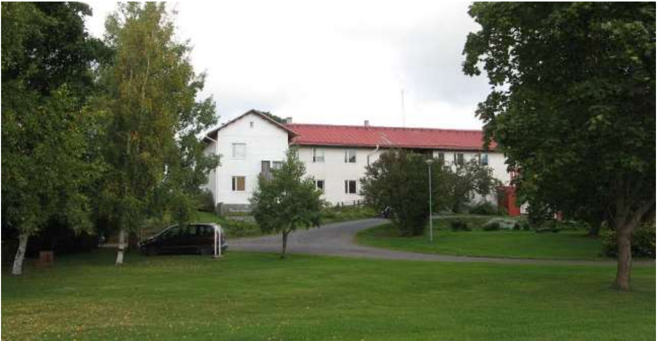
TYAdigi 39.63. Tammelan vanhan pappilan päärakennus modernisoituna ja liitettynä yhteen uudisrakennusten kanssa kesällä 2012, etelästä. Kuva H.-M. Pellinen.
