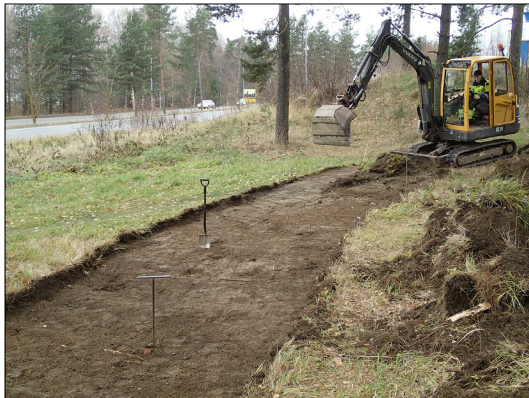
Puistokäytävän keskiosaa kaivettuna määräsyytyteen
