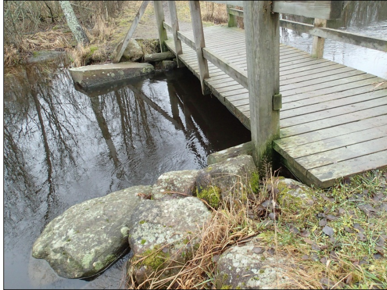
Luonnonkivien varaan rakennettu kevyenliikenteen silta Moisionjoessa Hiidentien linjauksella
