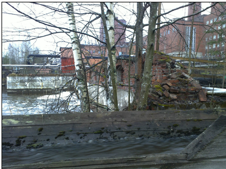
Saaren länsipäästä, vanhan voimalaitoksen pohjoisseinä jäänteet.
