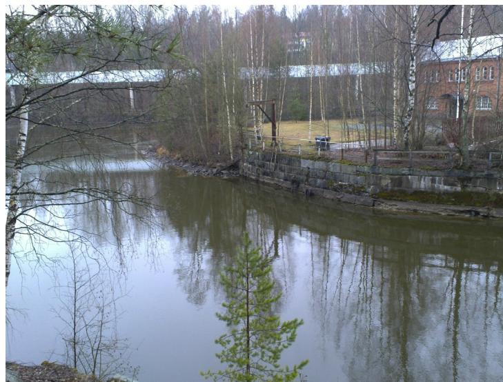
Neulapadon paikka kuvan keskellä saarella olevan vanhan nostotaljan kohdalla.
