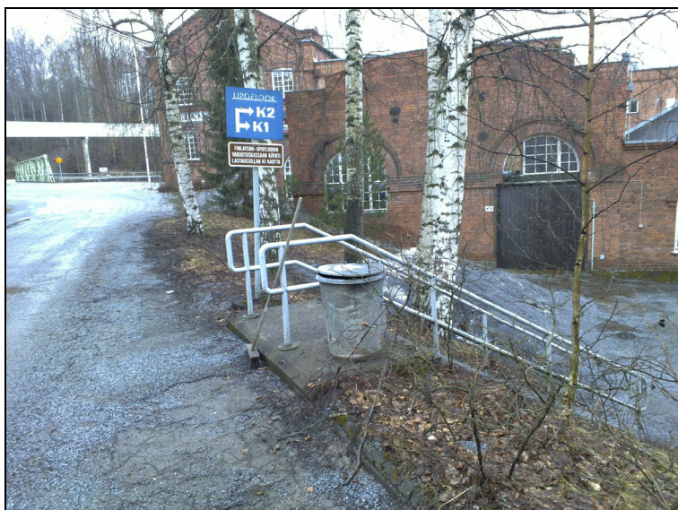
Oikealla rakennuksen ovi johon johtanut rata. Saaren keskiosassa, lounaaseen.
