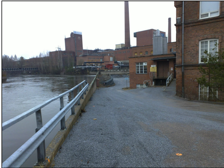
Ruiskuhuoneen paikka etualalla. Länteen sillan päästä.
