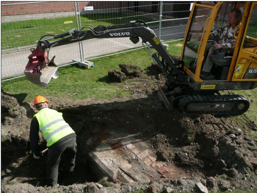
Kaivaustyötä. Mikko Helminen kuopassa ja Rostedt kaivinkoneessa.
