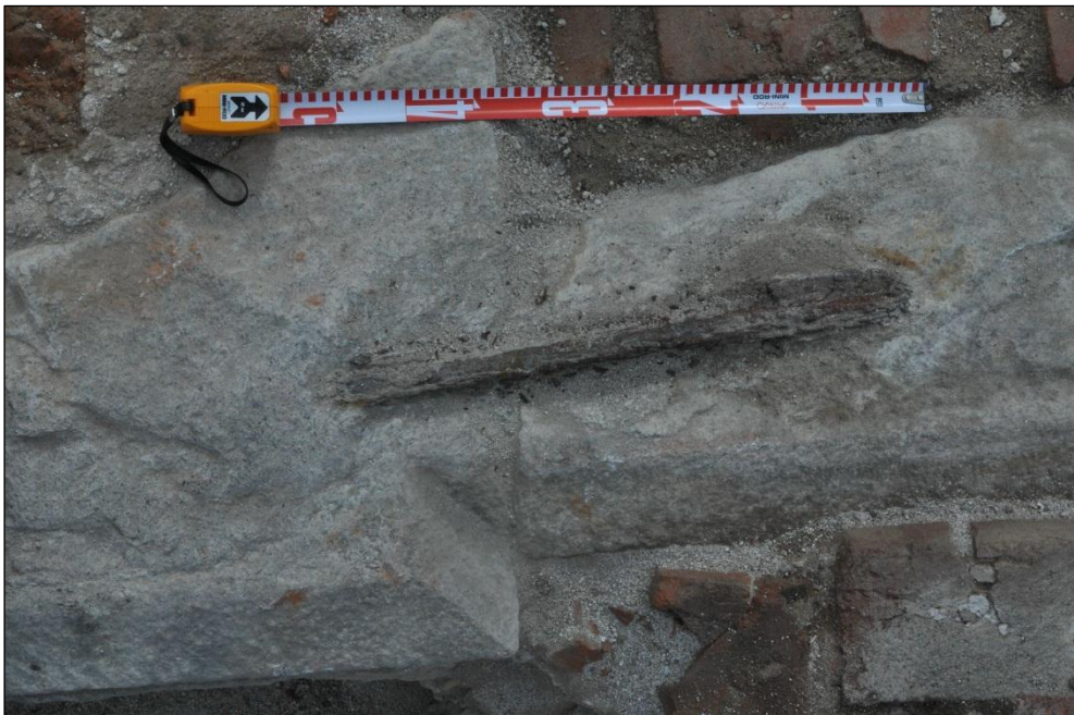
Kaivausalue 2. Yksityiskohta tutkimusalueelta paljastettujen harmaakivigraniitista muotoon lohkotettujen perustuskivien liitoskohdasta.
