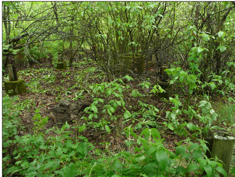
Rakennuksen betoni- ja puurakenteita tontin länsiosassa
