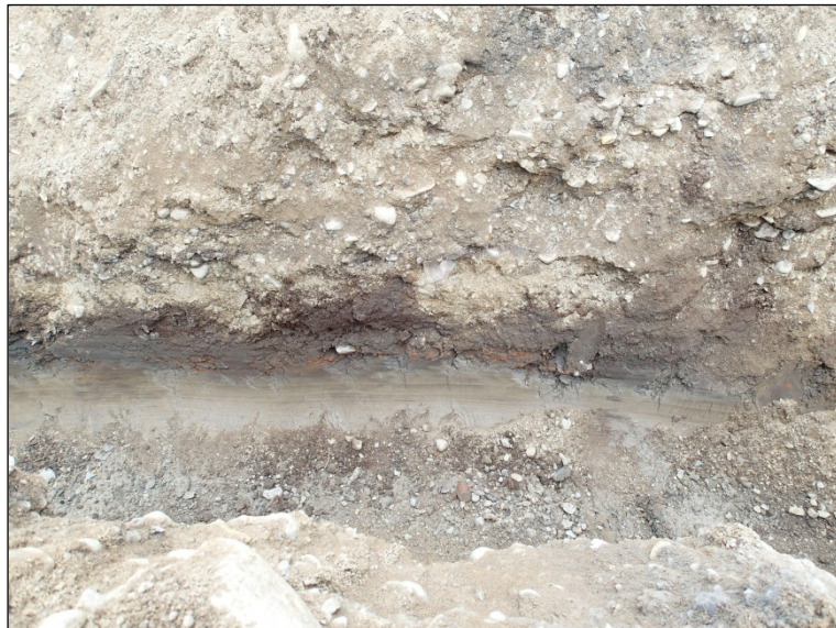
Kaapelikaivannon seinämää ojan länsipuolella pihatien kohdalla
