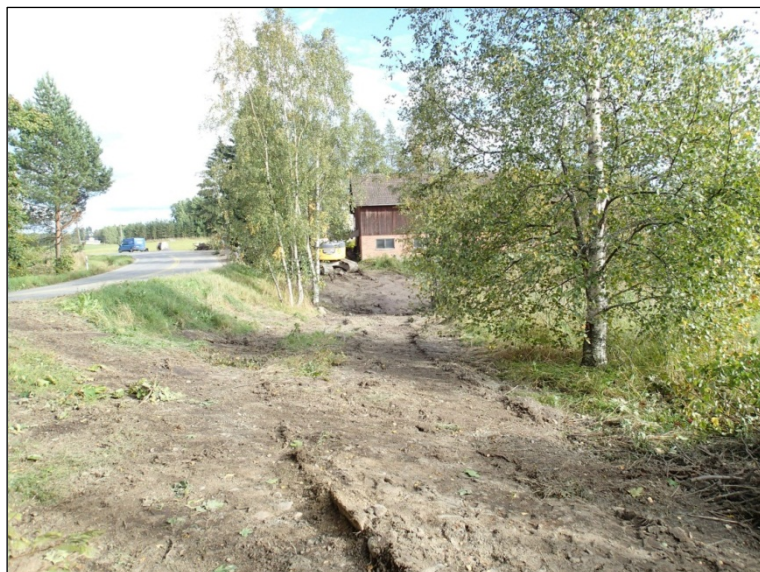
Peitettyä kaivantoa ojan kahden puolen.
