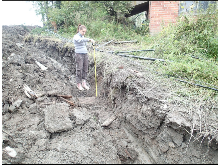
Kaapelikaivantoa ojan itäpuolella navetan nurkalla
