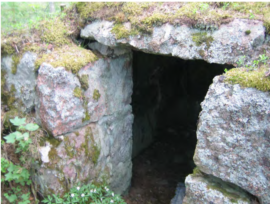
Kuva 28. Myllymäen seurantalo. Kellarin oviaukko. Kuva: T. Vasko.
