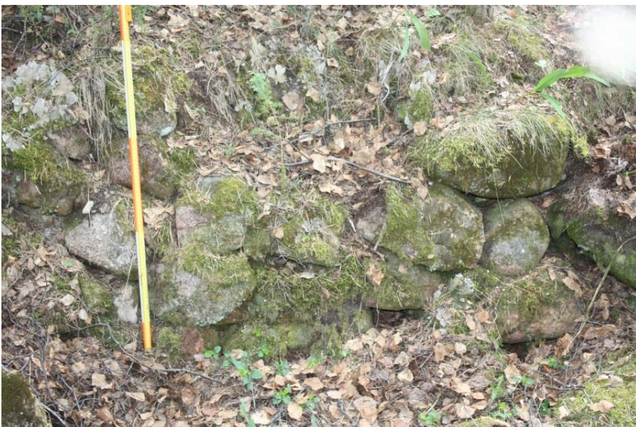
AKDG3254:6. Uunin kaakkois- seinämän kiveystä. Luoteesta. Kuvaaja: Petro Pesonen.
