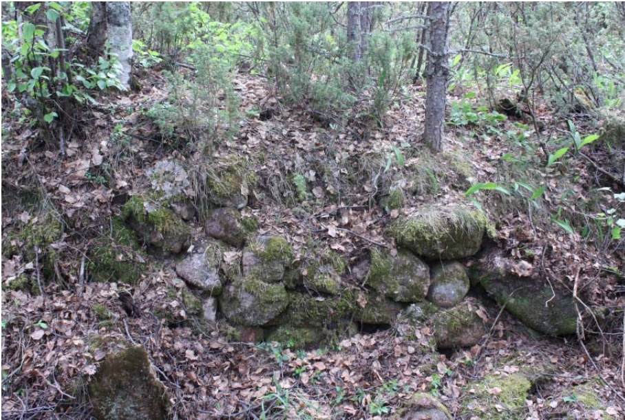
AKDG3254:5. Uunin kaakkois- seinämän kiveystä. Luoteesta. Kuvaaja: Petro Pesonen.
