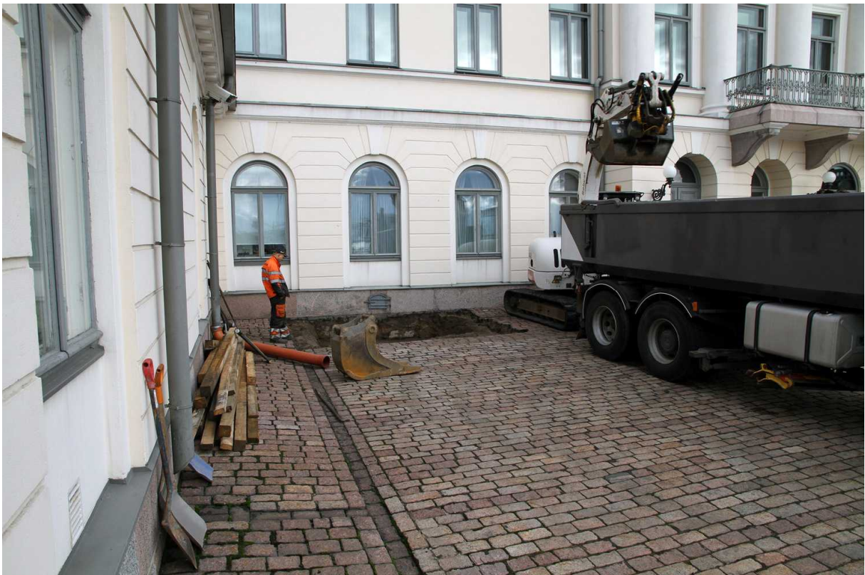
Kuva 84. Etupiha. Dokumentointikohta 10. Toinen koekuoppa perustusten kunnan tutkimiseksi tehtiin syyskuussa vuonna 2010 linnan etupihan luoteisnurkkaan. Kuvaussuunta NNE. 20.9.2010.
