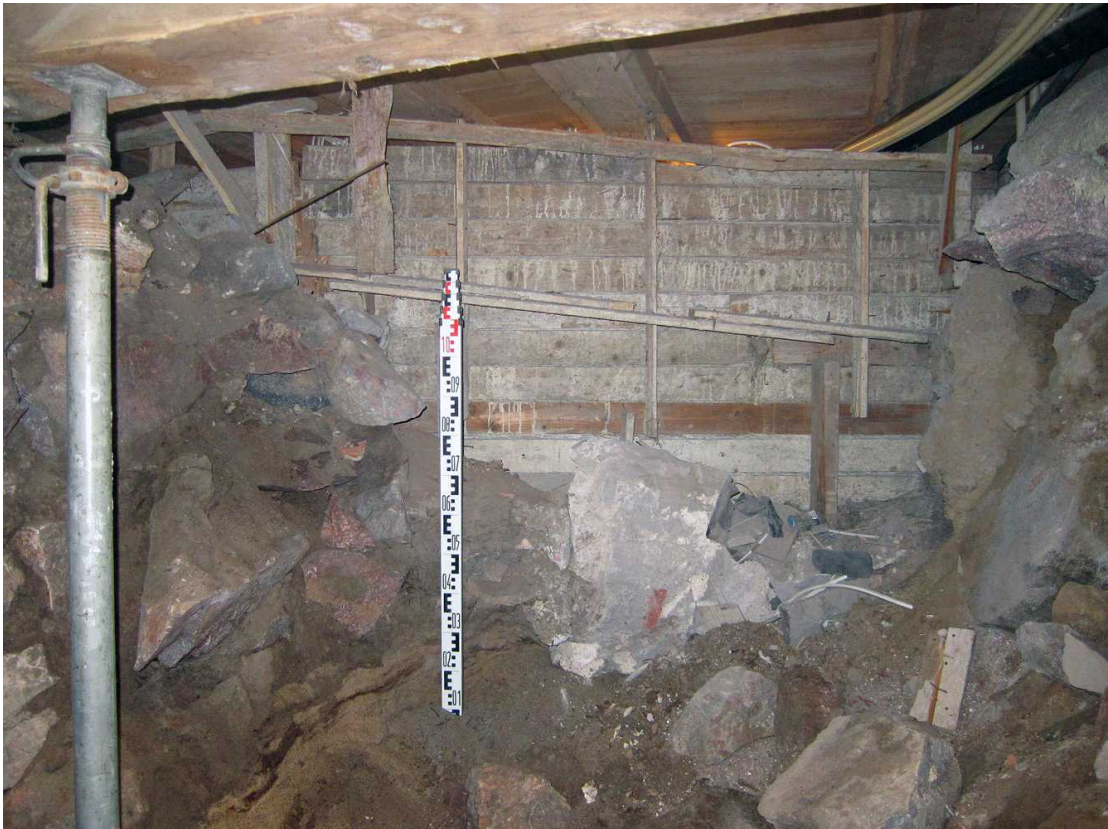
Kuva 154. Kellari 0007, tila A. Lähikuva laudoitetusta betoniseinästä. Vasemmalla on tilojen A ja B välinen poikittainen kiviperustus. Kuvaussuunta W. 19.8.2011.
