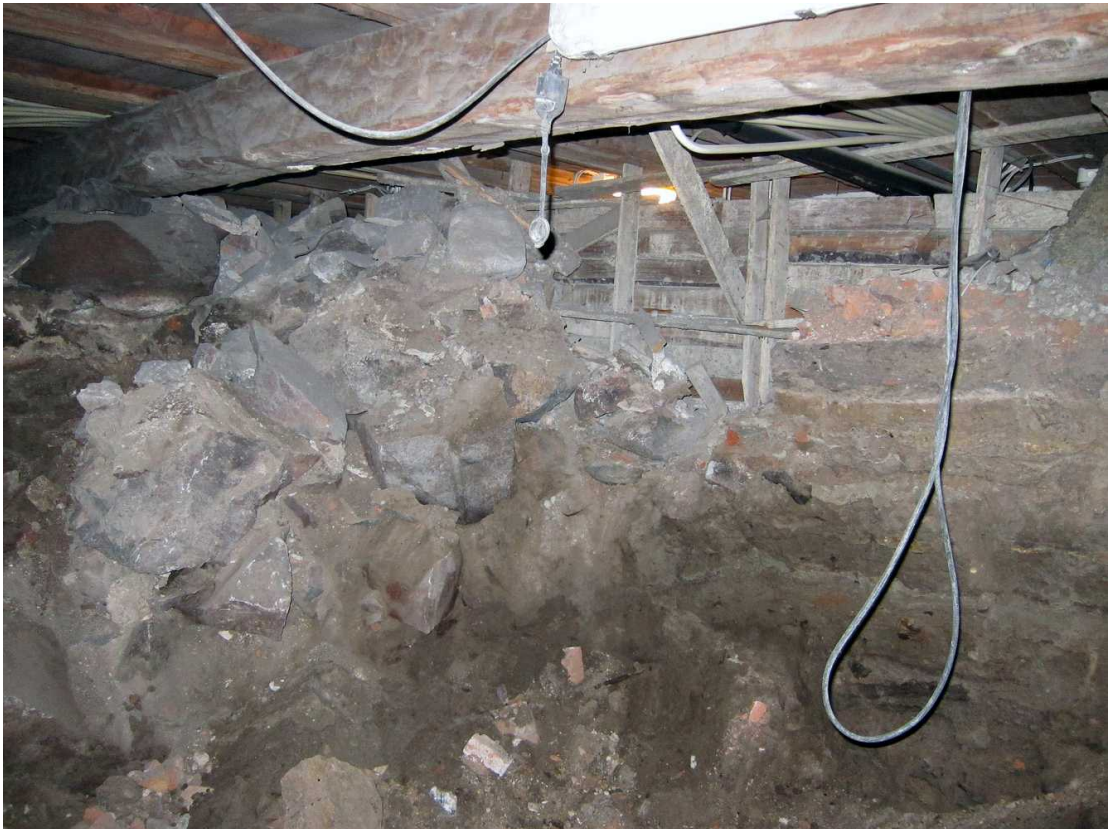
Kuva 186. Kellari 0007, tila C. Tilojen B ja C välisen kiviperustan jäännökset läntisen matalan siiven pitkittäisen lattiavasan kohdalla. Kuvaussuunta SW. 19.8.2011.
