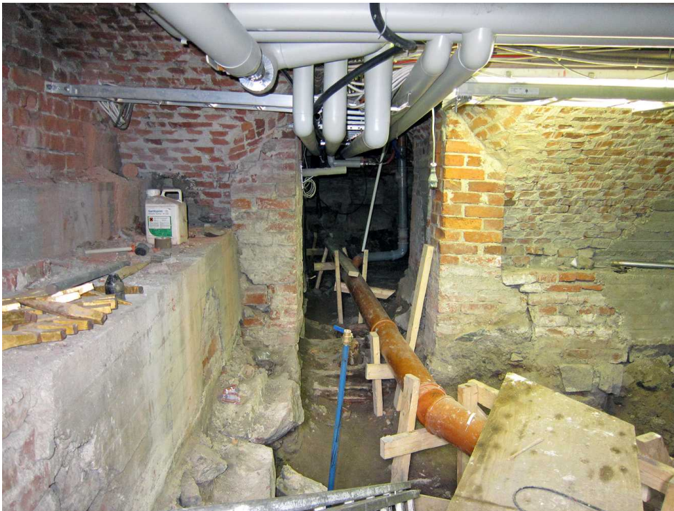
Kuva 16. Kellari 0033. Edellinen käytävä ja kellaritilan 0034 länsiosa. Vasemmalla ja oikealla näkyy kellarin 0034 tiilikorokkeet, jotka on megapaalujen kohdalla betonoitu korokkeen muotoon. Kuvaussuunta N. 18.8.2011.
