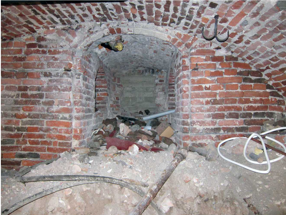
Kuva 3. Kellari 0033. Kellaritilan itäosa ja ylempänä sijainnut pieni itäinen tila työmaan alussa. Itäosan putken ympäriltä on heitetty maita ja irtotavaraa tilan tähän kohtaan. Kuvaussuunta E. 28.6.2011.
