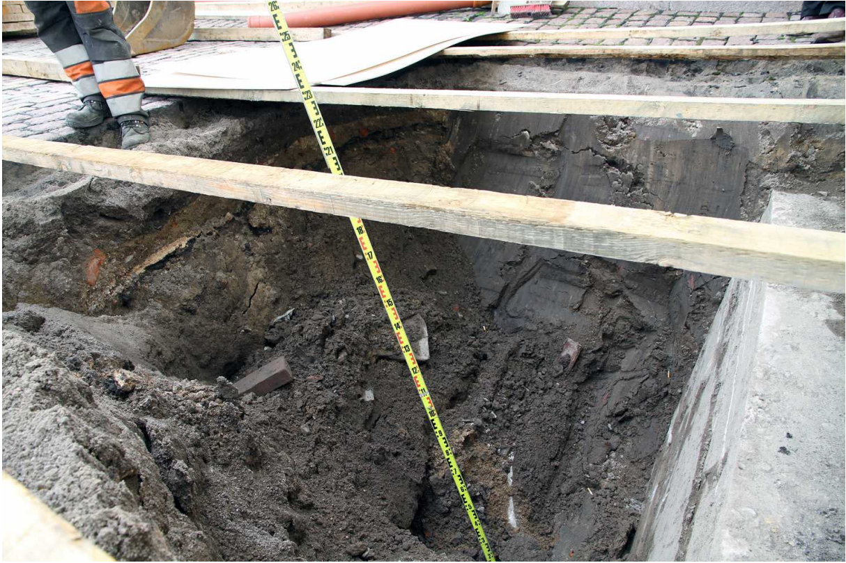
Kuva 87. Etupiha. Koekuopassa oli oikealla näkyvän betoniperustuksen takia enimmäkseen vain uudempia täyttömaita. Kuvaussuunta SWW. 20.9.2010.
