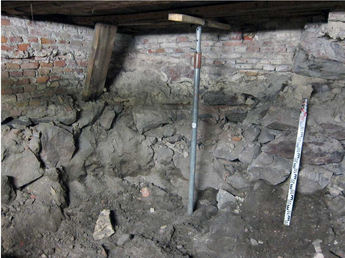
Kuva 207. Kellari 0007, tila C. Tilan C kaakkoisnurkka. Oikealla on tilojen C ja D välinen kunnossa oleva kiviperustus, jonka yläosa muodostui tiilestä. Kuvaussuunta SE. 1.9.2011.
