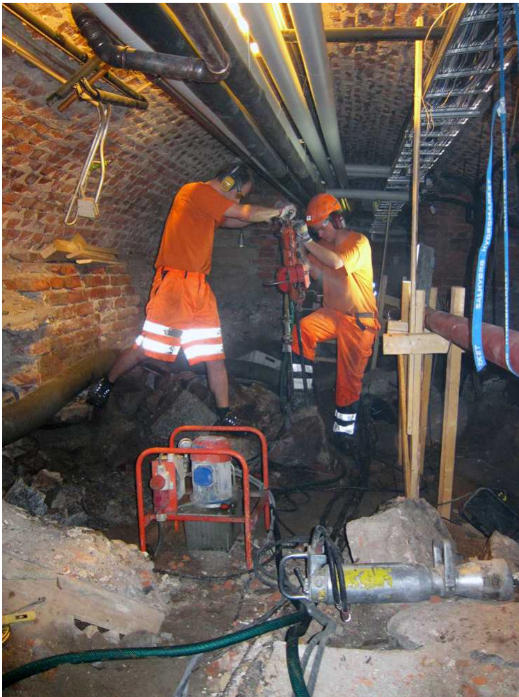
Kuva 44. Kellari 0033. Kellaritiloista poistettavia kiviä porataan pienemmiksi niiden siirtämisen mahdollistamiseksi kellaritiloista. Kivet ovat peräisin megapaalujen kohdilta kiviperustasta. Kuvaussuunta W. 11.7.2011.
