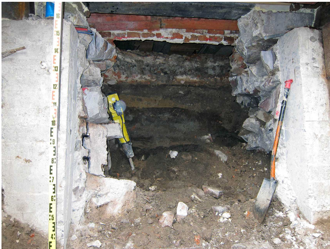
Kuva 128. Kellari 0007, tila A. Betoniperustuksen ja alkuperäisen kiviperustuksen takaa tuli esiin dokumentointikohta 12. Ylimpänä oli etupihan korkeudella linnan rakennusjätteitä ja niiden alla vanhoja kulttuurikerroksia. Kuvaussuunta W. 8.8.2011.
