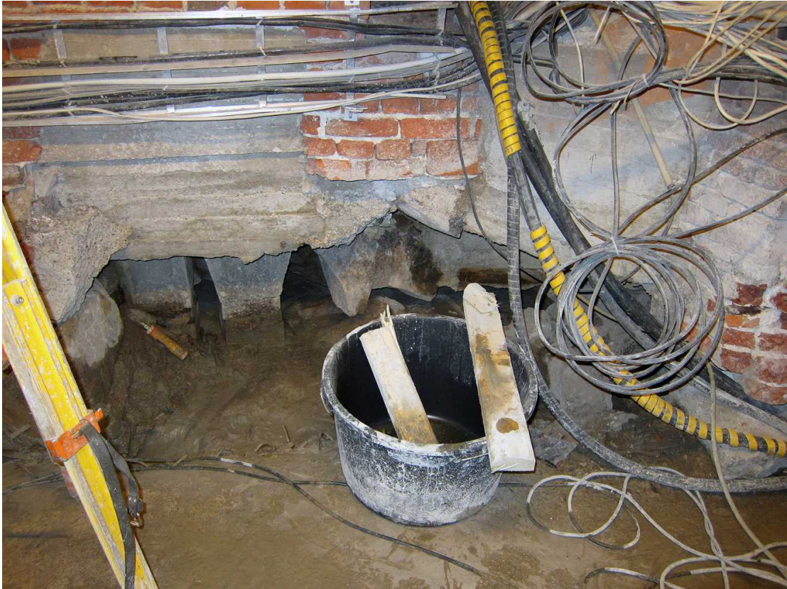
Kuva 248. Kellari 0002. Lähikuva kellaritilan koilliskulman seinän alapuolisista megapaaluista. Kuvaussuunta N. 5.7.2012.
