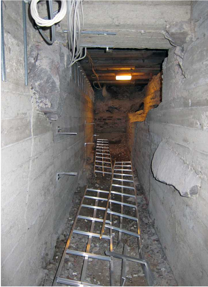
Kuva 230. Kellari 0007, läntinen putkitunneli. Putkitunnelin eteläpää tilojen C-D kohdalla. Seinillä näkyy tilojen välisen kiviperustuksen kiviä. Kuvaussuunta S. 1.9.2011.
