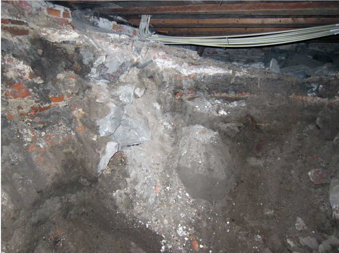
Kuva 185. Kellari 0007, tila C. Tilojen B ja C välisen kiviperustan jäännökset läntisen matalan siiven itäseinän luona. Taustalla on tila C. Kuvaussuunta SEE. 19.8.2011.
