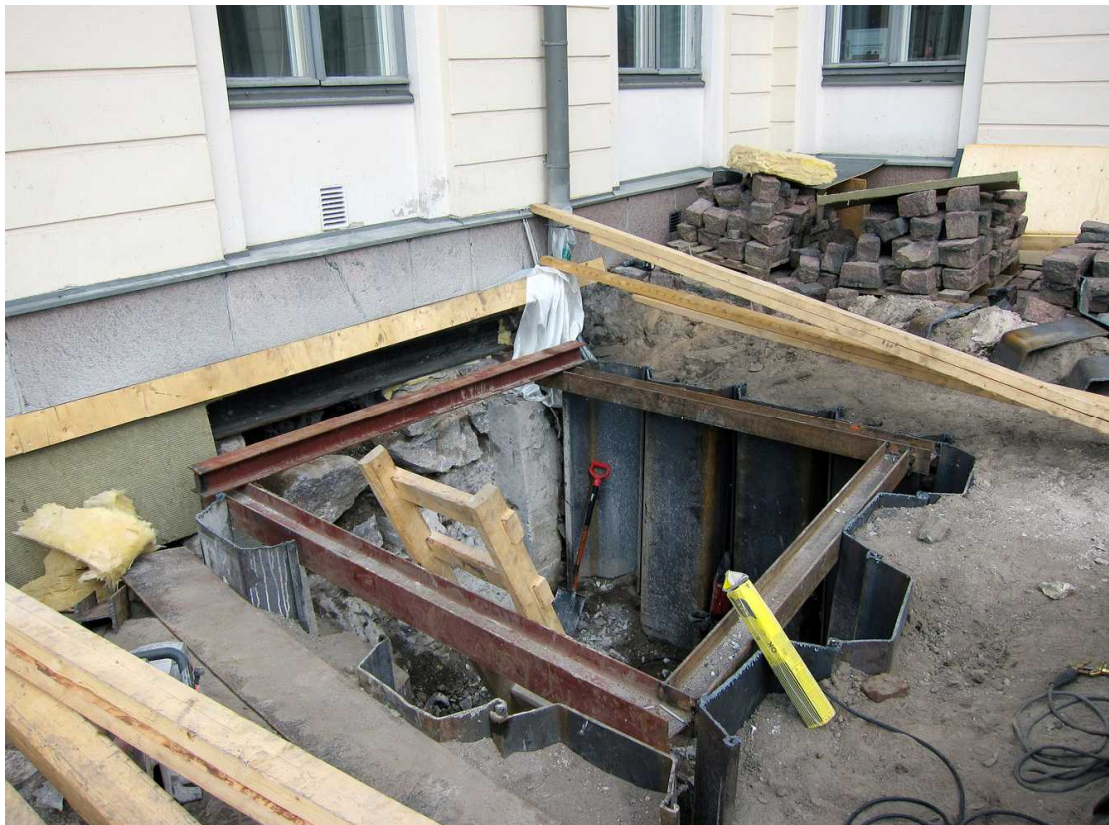
Kuva 122. Etupiha. Kuopan seinät ovat pontitettu ja länsisiiven perustukseen on aloitettu teke aukkoa. Kuvaussuunta NW. 27.7.2011.
