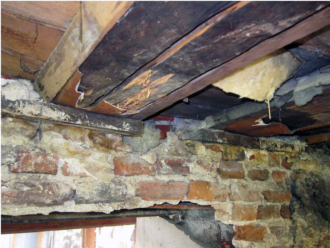
Kuva 134. Kellari 0007, tila A. Aukon yläpuolelle jäänyt tiiliseinä, poikittaiset lattiavasat ja alapohjan laudat. Kuvaussuunta SE. 18.8.2011.
