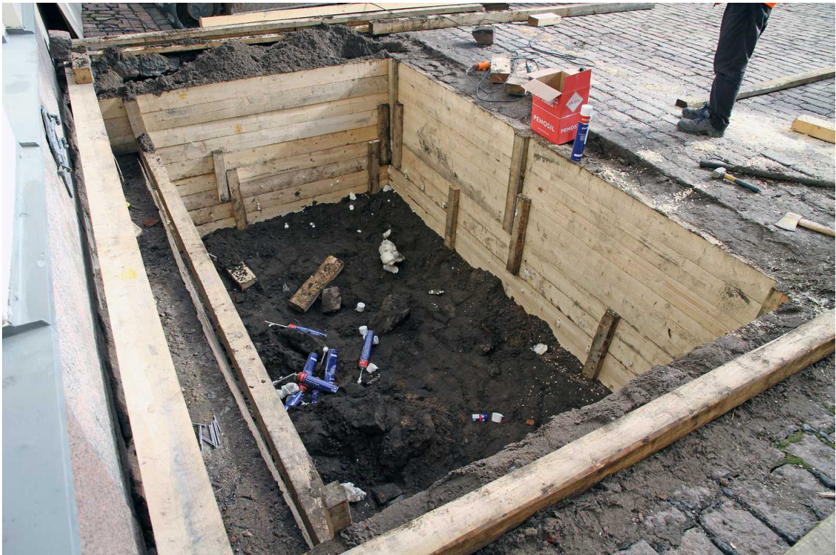
Kuva 88. Etupiha. Koekuoppaan rakennettiin puiset seinät. Kuvaussuunta SE 22.9.2010.
