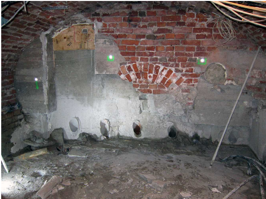
Kuva 264. Kellari 0008. Kellaritilan länsiseinä, jonka kohdalle tulee hissi. Seinän alaosassa näkyy megapaalutuksen valuja ja uutta valua, jossa olevien putkien kautta on vahvistettu perustaa. Kuvaussuunta W. 15.8.2012.
