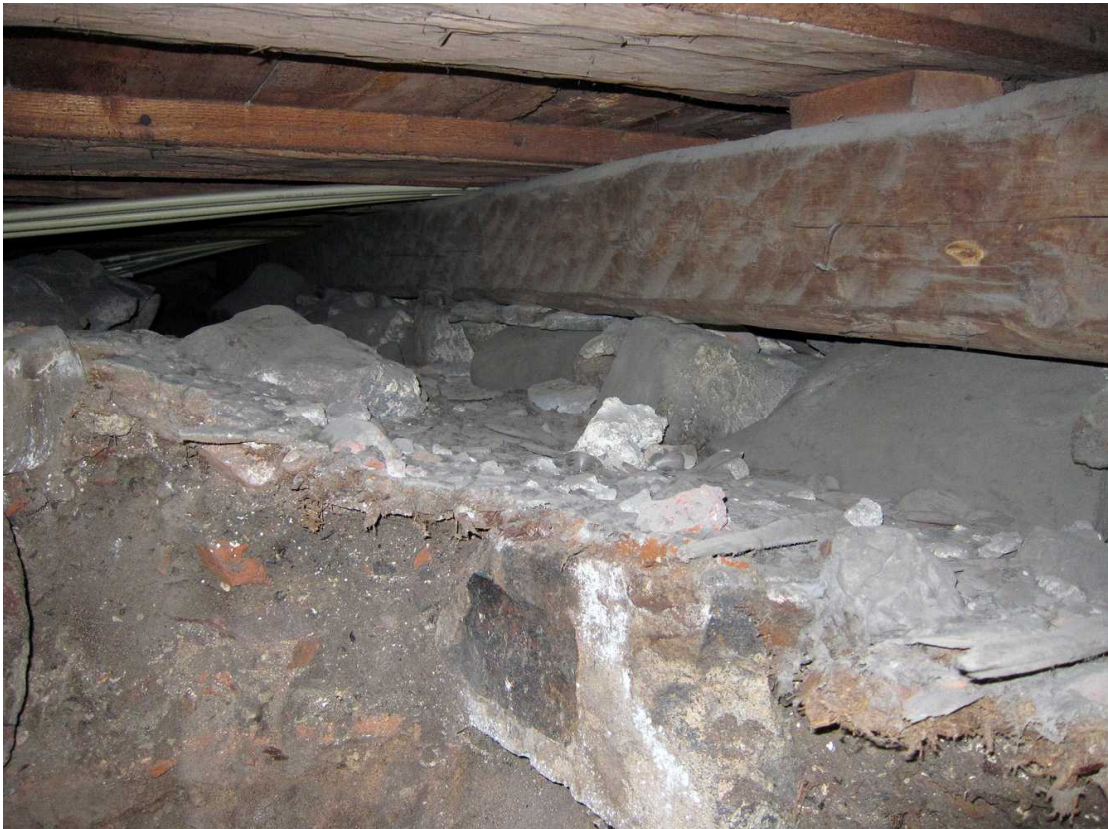
Kuva 166. Kellari 0007, tila B. Edellisen maaleikkauksen pinnan ja lattian välinen tila tilan B itäpuoliskon länsiosassa. Kuvaussuunta SW. 17.8.2011.
