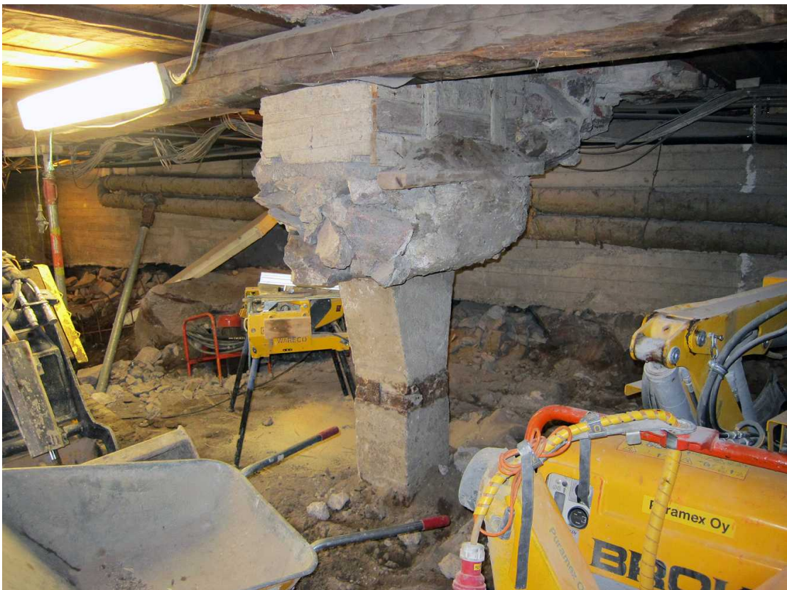
Kuva 267. Kellari 0007. Yksinäinen megapalu kannattelemassa yläpuolista seinään kellaritilan pohjoispäässä. Kuvaussuunta SW. 5.7.2012.
