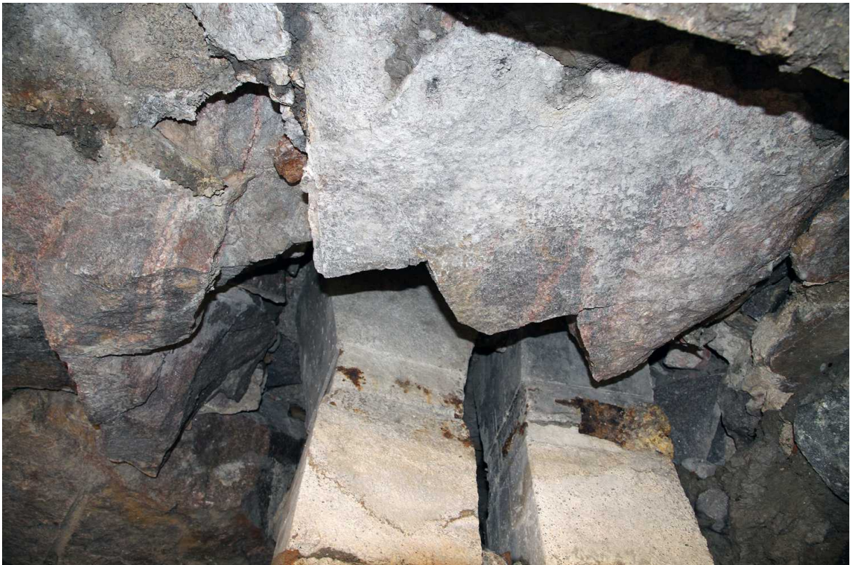
Kuva 94. Etupiha. Lähikuva megapaalujen yläosista ja linnan kiviperustuksesta. Kuvaussuunta N. 4.10.2010.
