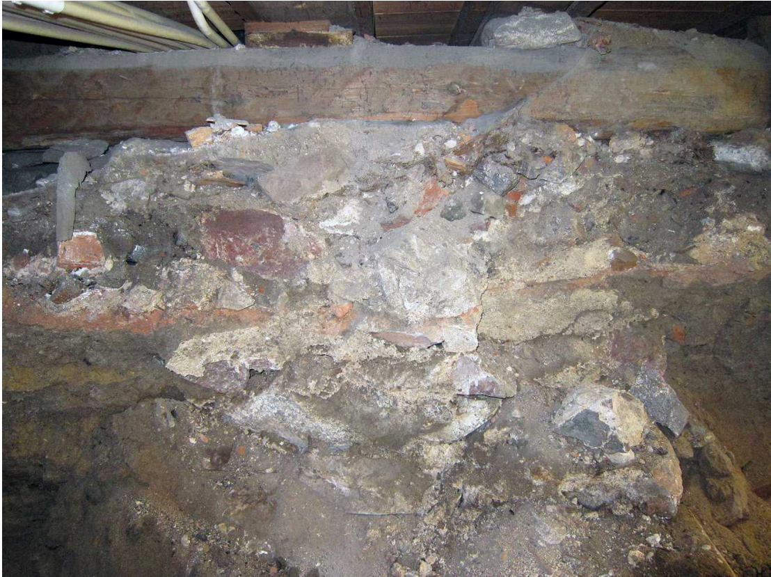
Kuva 163. Kellari 0007, tila B. Lähikuva tilojen A ja B välisestä poikittaisesta kiviperustuksesta pitkästä lattiavasasta kohdalla. Kuvaussuunta W. 17.8.2011.
