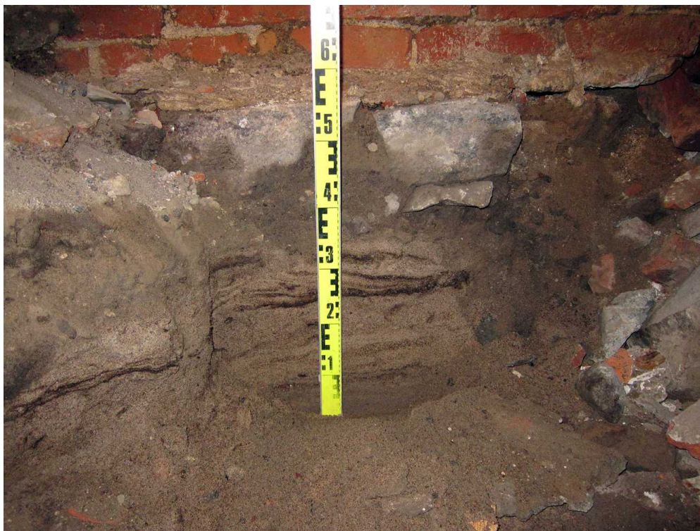
Kuva 36. Kellari 0032. Edellisen kohdan alaosa. Pikkukivien kerros näkyy tiilikorokkeen perustuskivien alla. Kuvaussuunta SSW. 28.6.2011.
