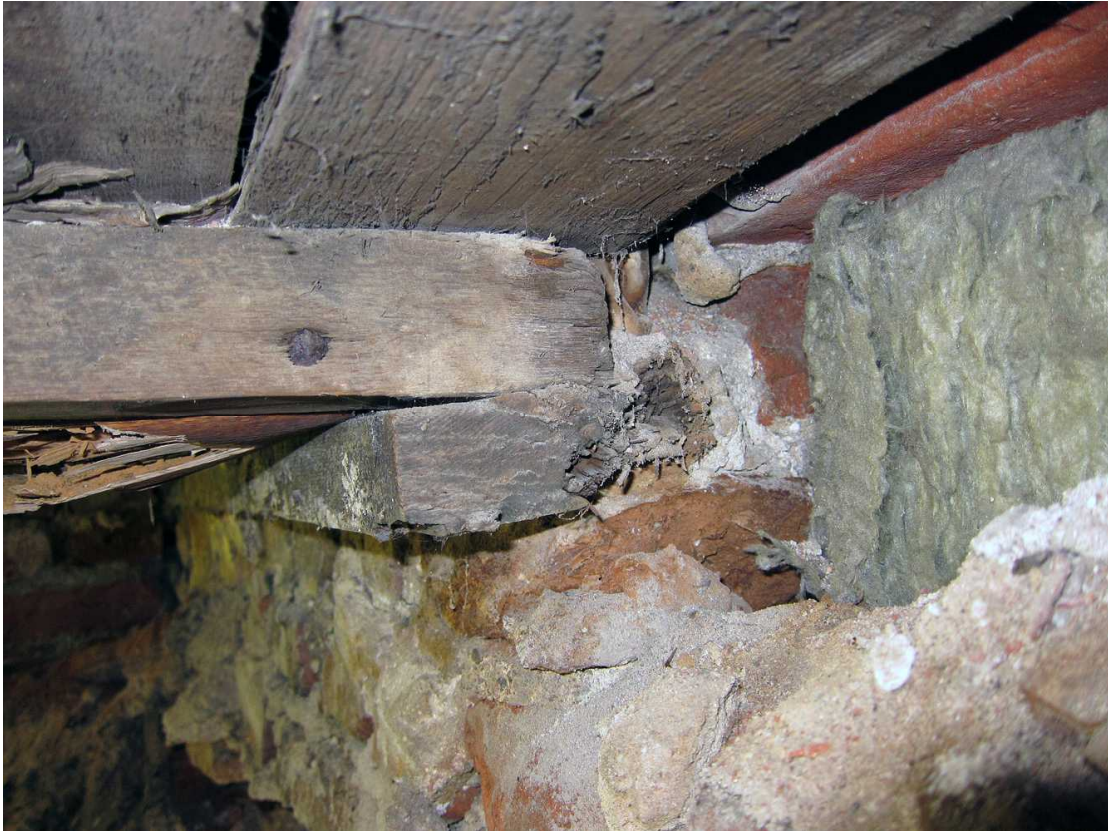
Kuva 135. Kellari 0007, tila A. Yksityiskohta eteläseinän tiilirakenteista ja lattian alapohjasta. Kuvaussuunta NNE. 18.8.2011.
