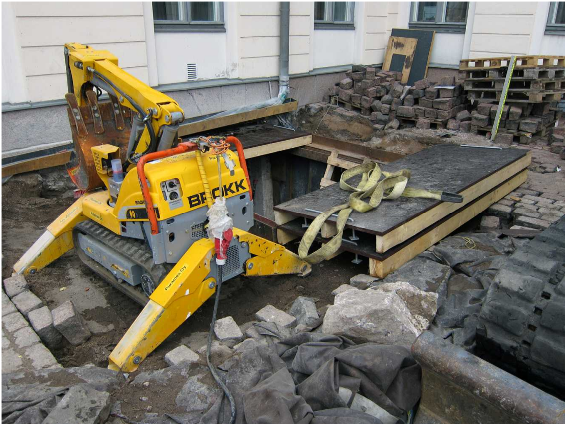
Kuva 126. Kellari 0007. Kuoppa länsisiiven perustukseen tehdyn aukon valmistuttua. Kuvaussuunta NW. 8.8.2011.
