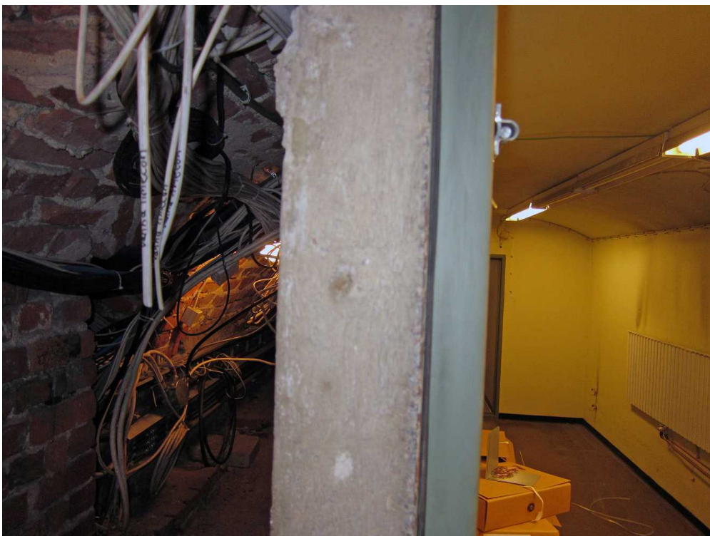
Kuva 62. Kellari 0002. Seinien välinen tila ja kellaritila. Kuvaussuunta W. 28.6.2011.
