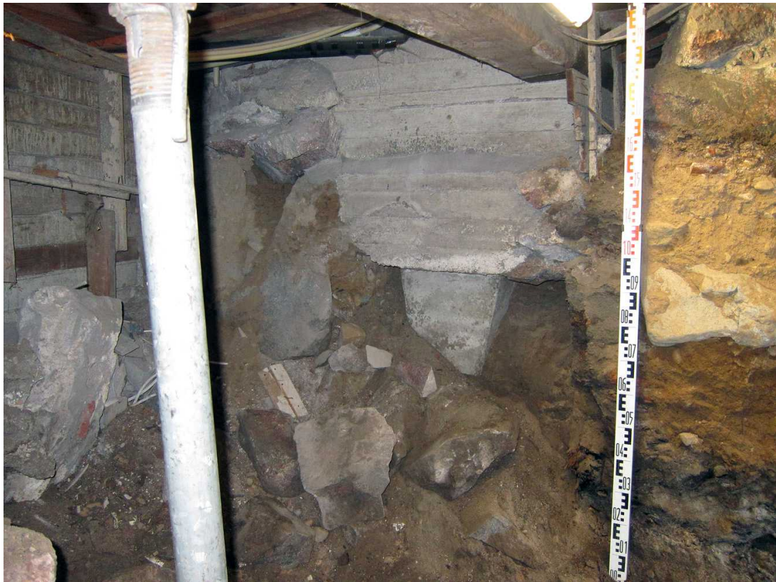
Kuva 157. Kellari 0007, tila A. Laajennuksen pohjoisseinämä. Läntisen putkitunnelin itäseinän ja sisäseinän kiviperustan välissä oli megapaalu ja sen pohjoispuolella ylhäällä laastia ja kiviä ja alempana kiviä ja hiekkaa. Kuvaussuunta NW. 19.8.2011.
