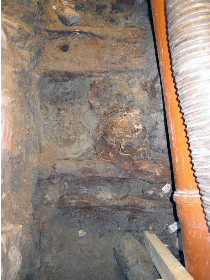
Kuva 15. Kellari 0033. Puuarina kuvattuna ylhäältä. Poikittaisia parruja ja pystypaaluja on esillä. Kuvaussuunta N. 30.6.2011.
