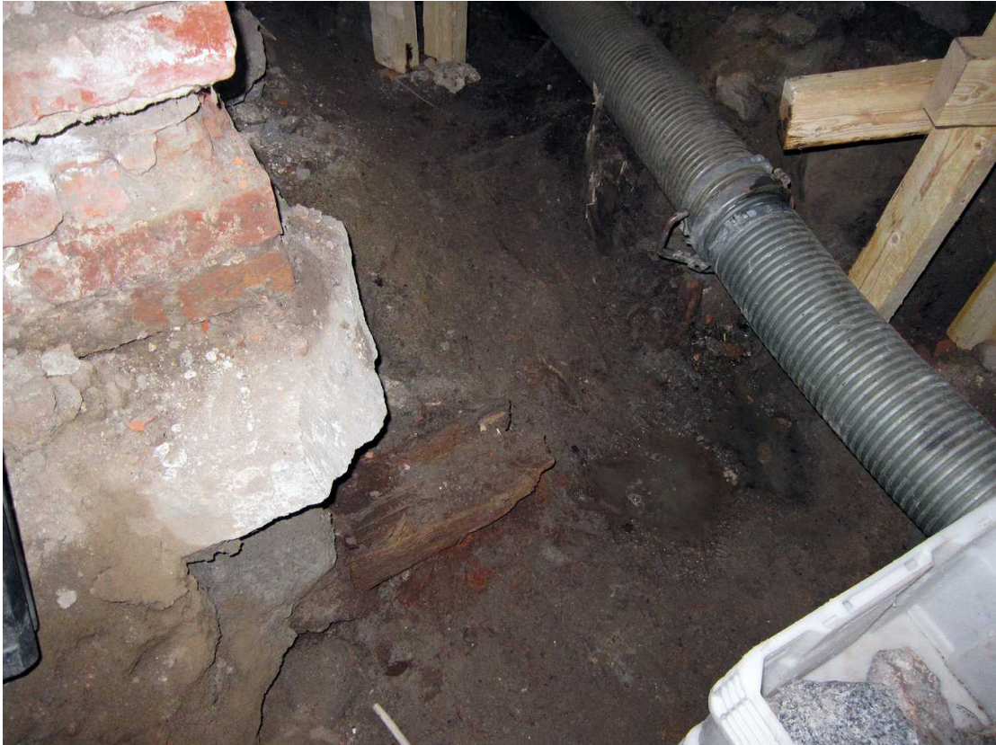
Kuva 31. Kellari 0032. Kellaritilojen 0034 ja 0032 välisen oviaukon, dokumentointikohta 4, kohta. Kellaritilojen välisen seinän alla näkyy puuarinaa. Kuvaussuunta NWW. 30.6.2011.
