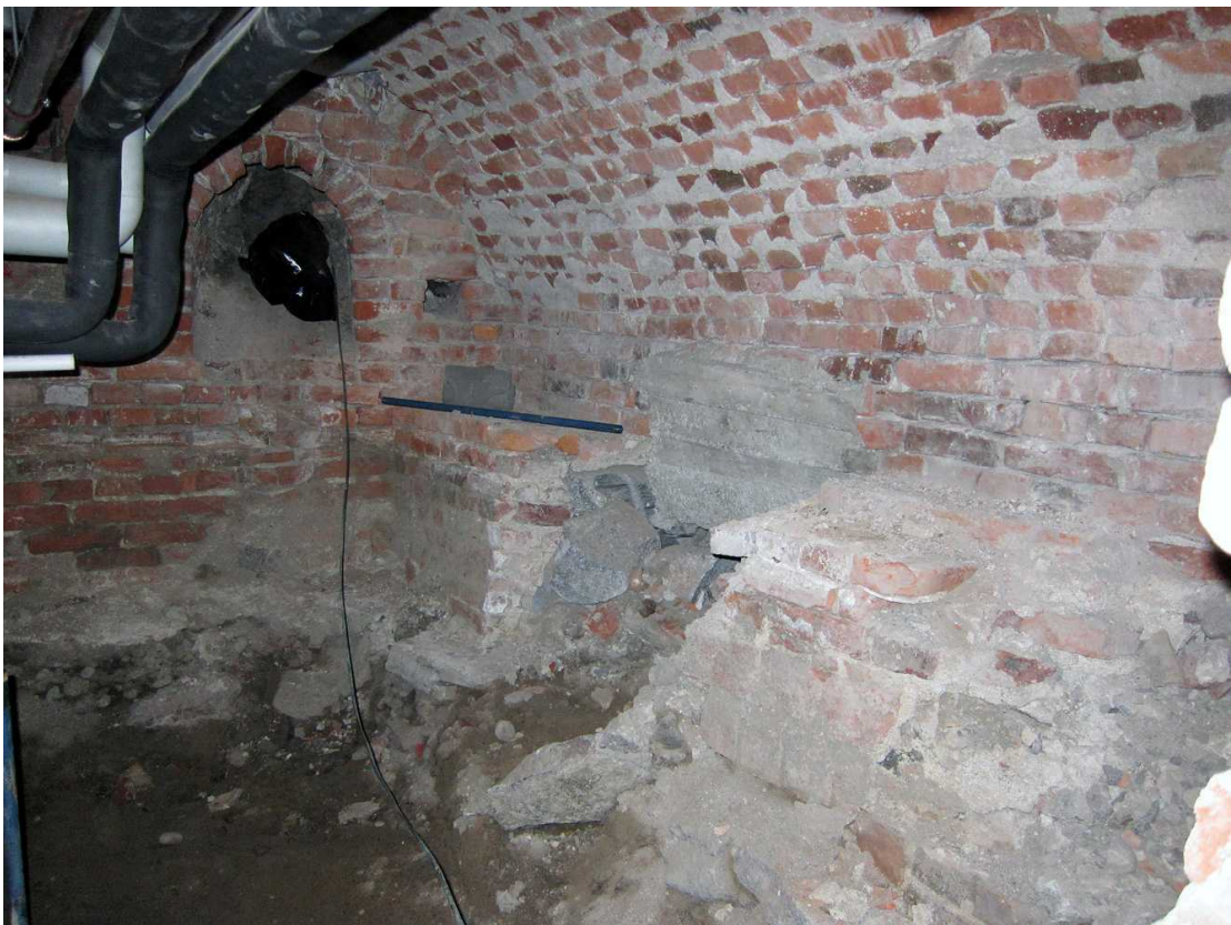
Kuva 58. Kellari 0031. Kellaritilan eteläosa tyhjentämisen jälkeen. Tiilikorokkeen sisällä näkyy seinän perustuskiviä. Täälläkään mega-paalun kohtaa ei ole valettu korokkeen muotoon. Kuvaussuunta SE. 18.8.2011.
