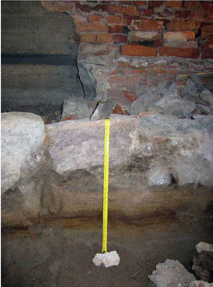
Kuva 37. Kellari 0032. Pohjoisseinän alaosa kellaritilan keskiosassa. Tiilikorokkeen alta ulkonee isoja perustuskiviä. Rikotun tiilikorokkeen sisällä näkyy perustuskiviä mega-paalun yläosan betoniosan vieressä. Kuvaussuunta N. 4.7.2011.
