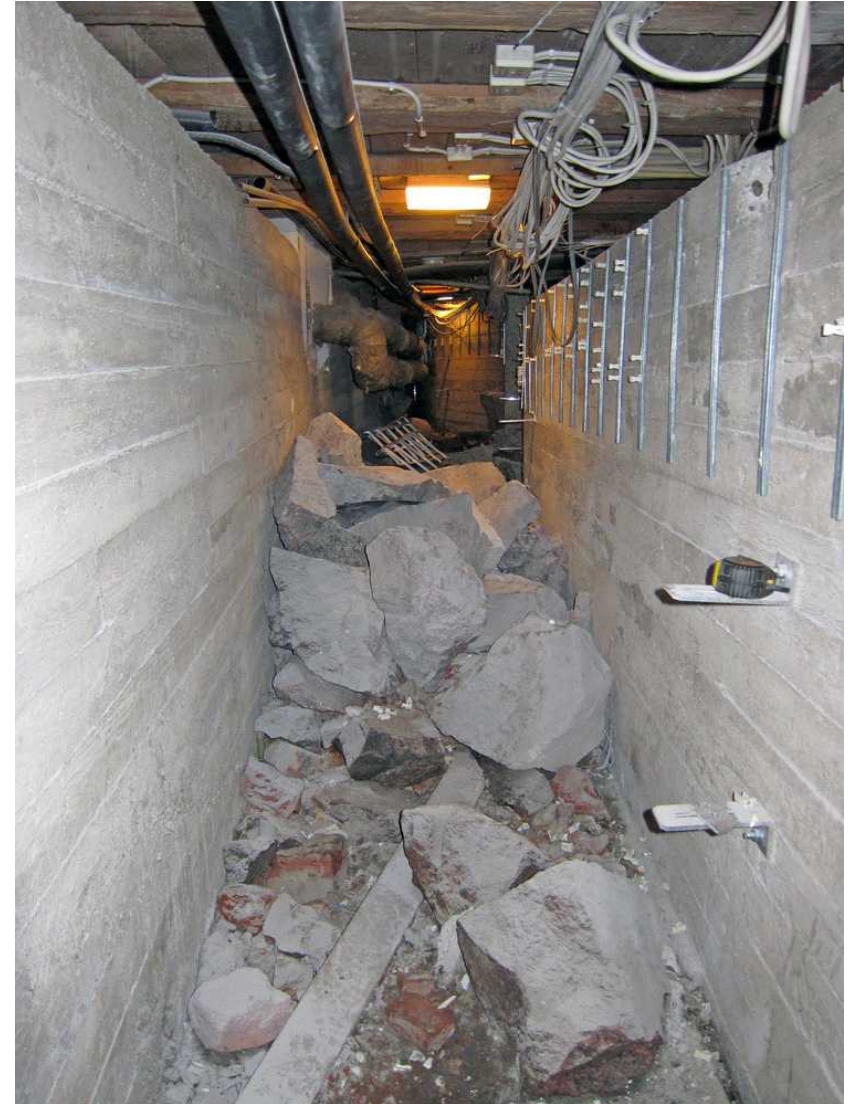
Kuva 229. Kellari 0007, läntinen putkitunneli. Putkitunnelin keskiosa tilojen B-C kohdilla. Kuvaussuunta N. 1.9.2011.
