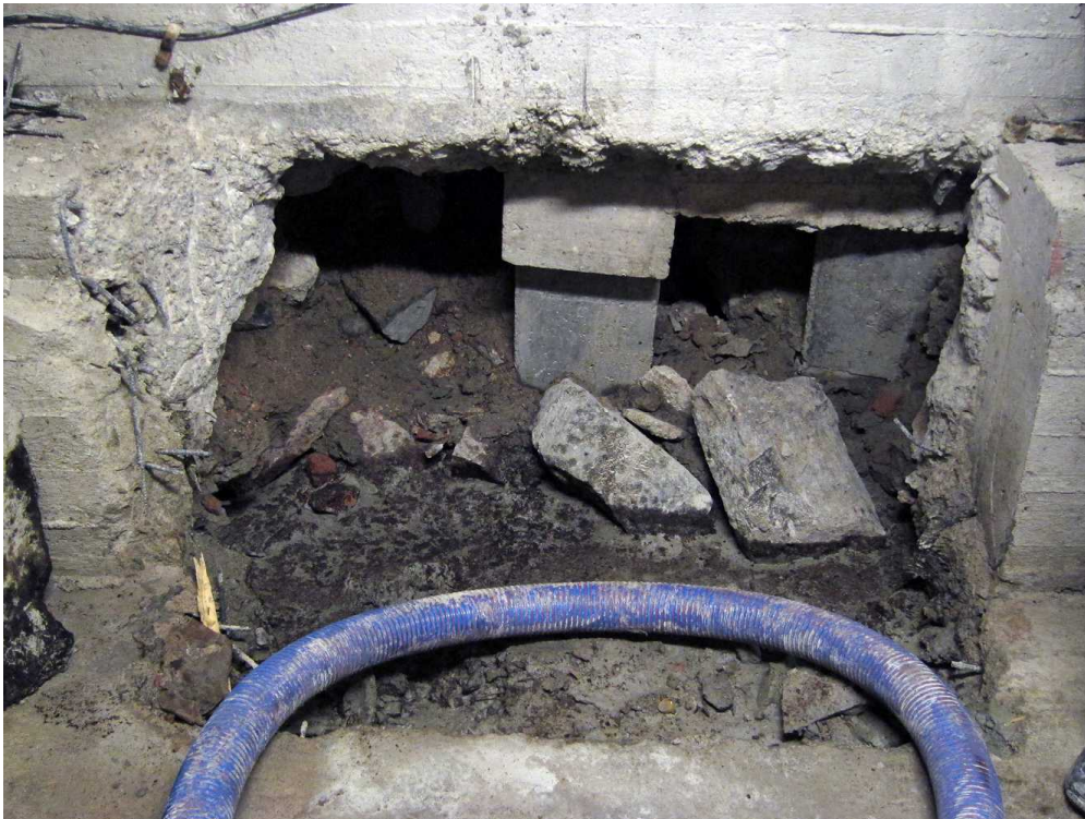
Kuva 78. Kellari 0002. Kellaritilan betoniperustus on avattu ja sen takaa seinän alta on tullut esiin megapaaluja. Kuvaussuunta N. 21.9.2011.
