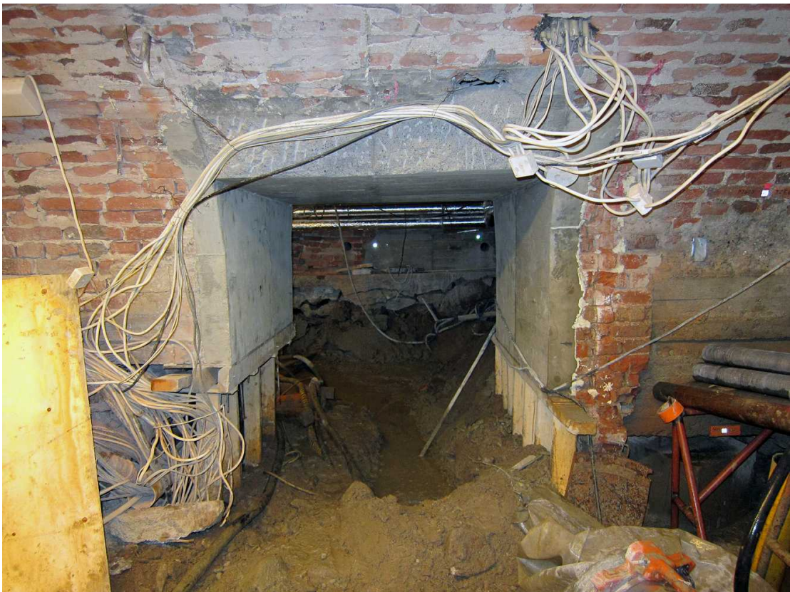
Kuva 257. Kellari 0008. Uusi aukko kellaritilasta 0006 kellaritilaan 0008. Vasemmalla alhaalla näkyy vanha putkitunneliaukko. Kuvaussuunta N. 30.7.2012.
