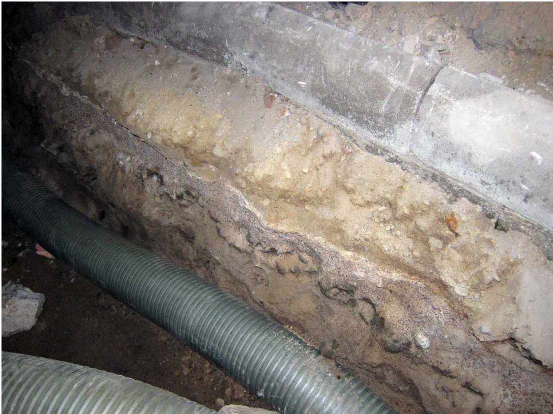
Kuva 32. Kellari 0032. Tilan poikki menevän kaapelin alapuoliset kerrostumat. Profiilin puolivälissä on pienten kivien kerros, jota oli kaikkialla kellareissa 0031-0032 ja 0034 ja niiden seinien kiviperustojen alla. Kuvaussuunta NW. 28.6.2011.
