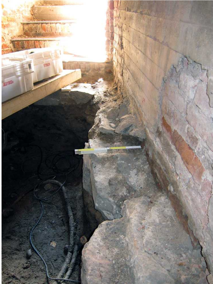
Kuva 19. Kellari 0034. Kellaritilan länsiseinän tiili- ja betonikorokkeesta ulkoneva kiviperustus. Kuvaussuunta S. 7.7.2011.
