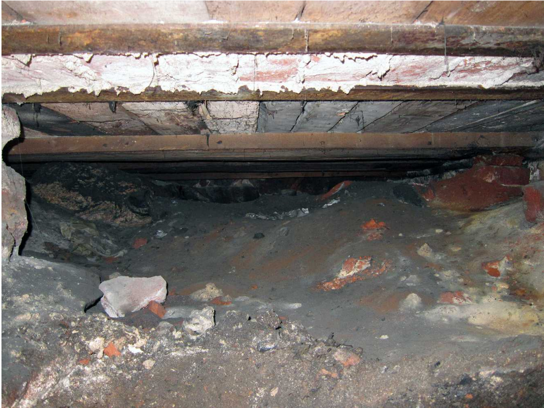
Kuva 145. Kellari 0007, tila A. Lattian alapuolinen tyhjä tila sisäseinän kiviperustuksen ja läntisen matalan siiven itäseinän välillä. Tilan takaosassa on heitetty kiviperustuksen perustuskuopan ja läntisen tunnelin kaivamisen maita. Kuvaussuunta N. 16.8.2011.
