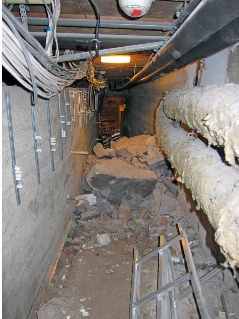
Kuva 228. Kellari 0007, läntinen putkitunneli. Putkitunnelin keski- ja eteläpää tilojen B-D kohdilla. Käytävässä kivet ovat todennäköisesti läntisestä kivimuurista, jonka läpi on vedetty kuvan putket. Kuvaussuunta S. 1.9.2011.
