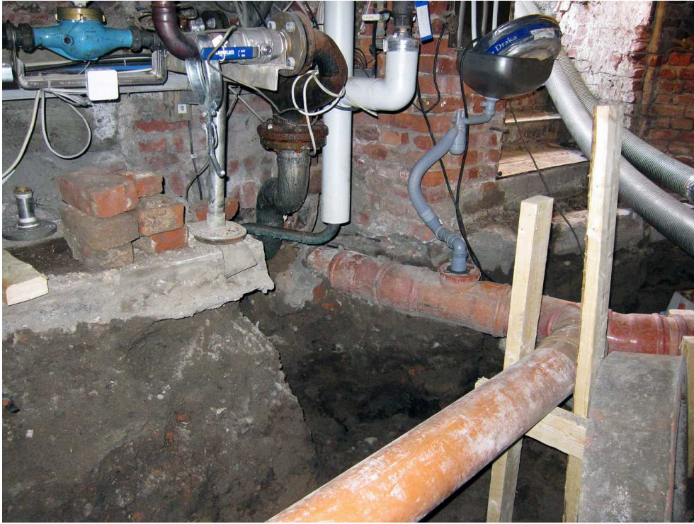
Kuva 25. Kellari 0034. Kellaritilan lounaisosa etupihalle johtavien portaiden itäpuolella. Muoviputket menevät eteläseinän sisään. Kuvaussuunta SW. 30.6..2011.
