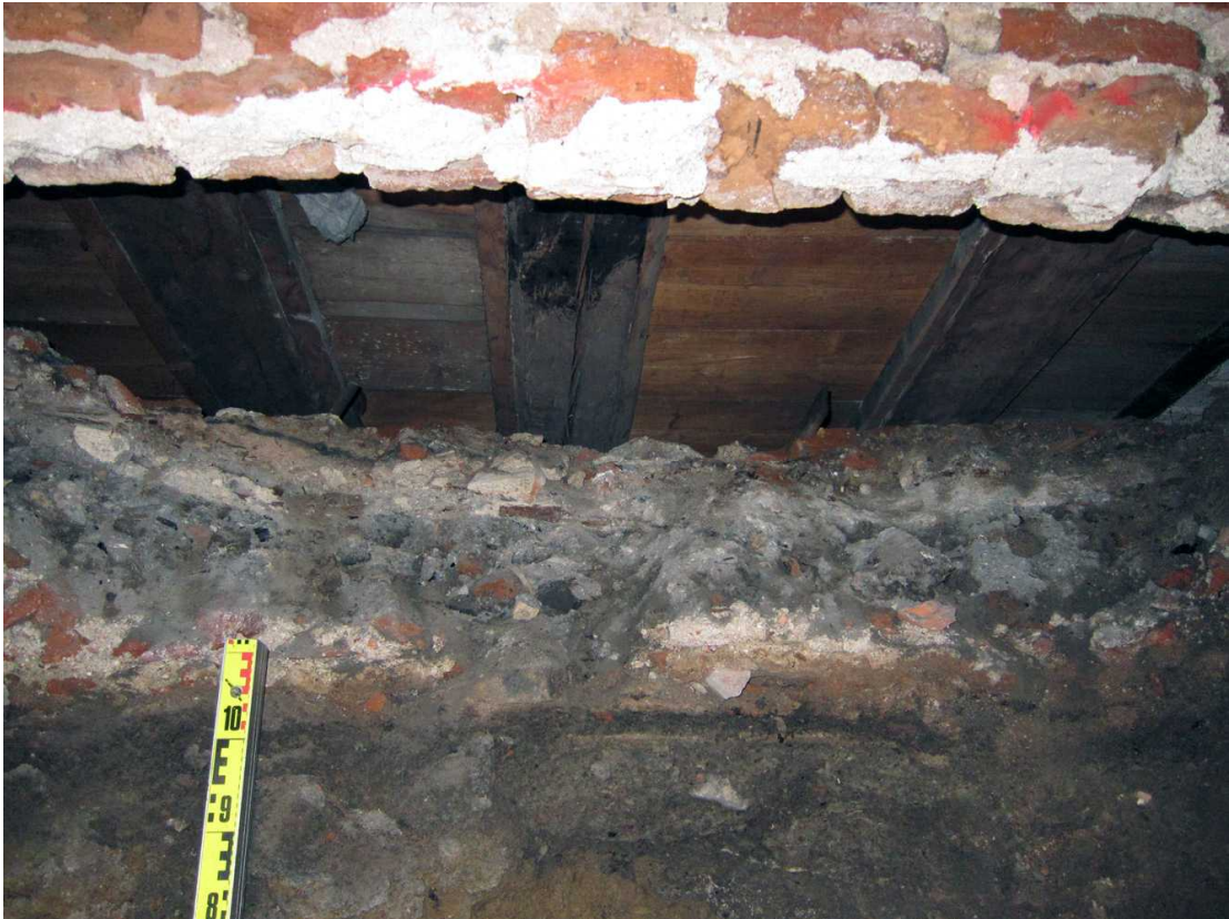
Kuva 130. Kellari 0007, tila A. Profiilin yläosan laasti- ja tiilimurskakerrokset, kapea tyhjä tila ja puulattian alapinta (=katto). Kuvaussuunta W. 8.8.2011.
