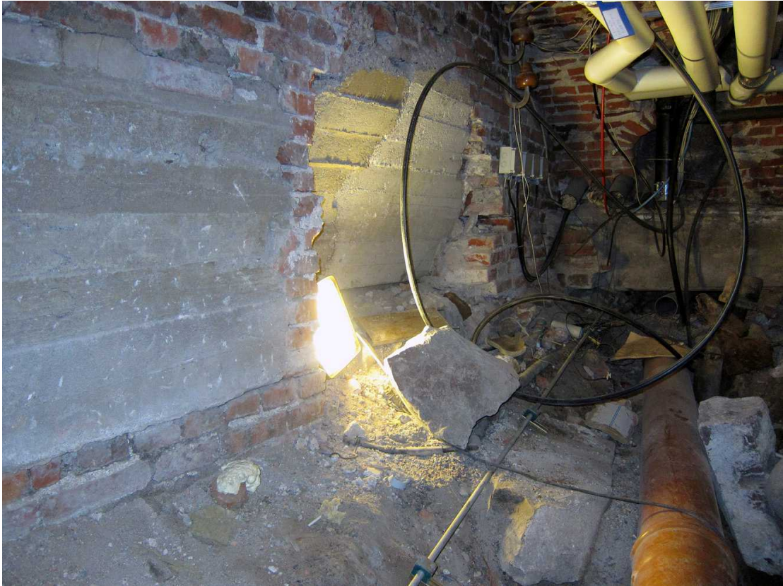
Kuva 1. Kellari 0033. Kellaritilan länsiosaa työmaan alussa. Eri kellaritilojen seinissä näkyvät betoniosat ovat enimmäkseen vuonna 1960 tehtyjen megapaalujen yläpuolisia betonivaluja. Kuvaussuunta NNW. 28.6.2011.
