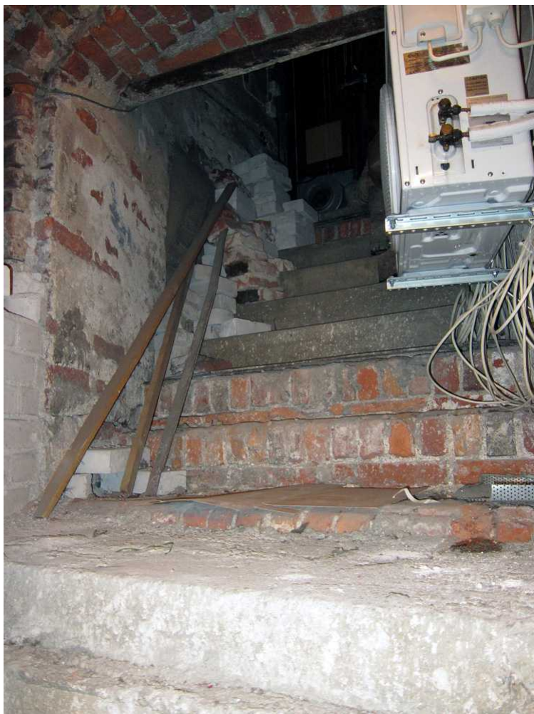
Kuva 60. Kellari 0002. Etupihalta kellaritiloihin 0002 ja 0006 johtavat portaat kuvattuna kellarista käsin. Kuvaussuunta SSE. 28.6.2011.
