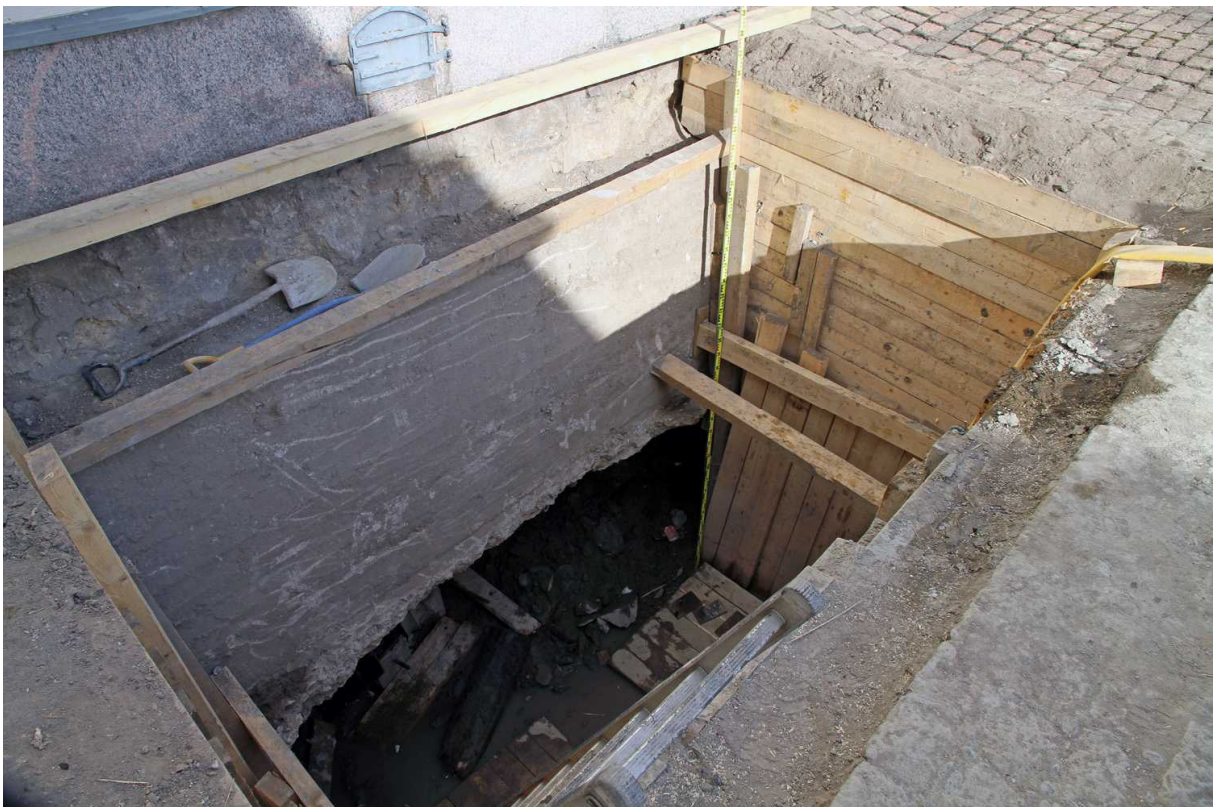
Kuva 90. Etupiha. Koekuoppa on syvennetty betoniperustuksen alapuolelle. Kuvaussuunta NE. 4.10.2010.
