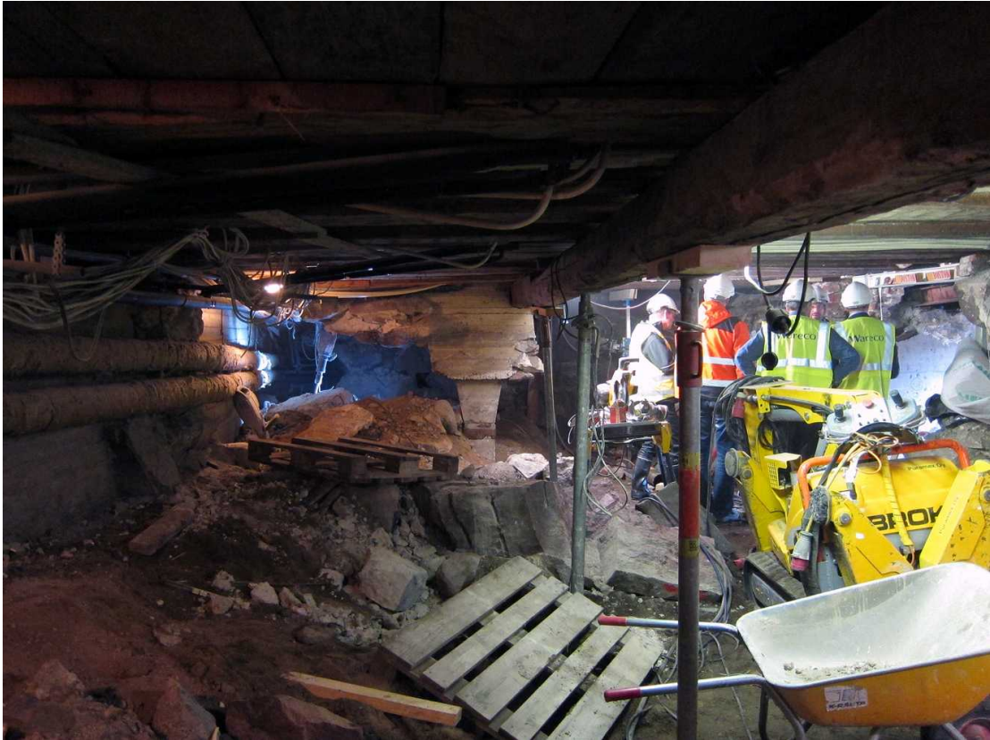
Kuva 215. Kellari 0007, tila C. Työmaakokous kellarissa. Läntisen putkitunnelin itäseinä on purettu. Kuvaussuunta S. 26.8.2011.
