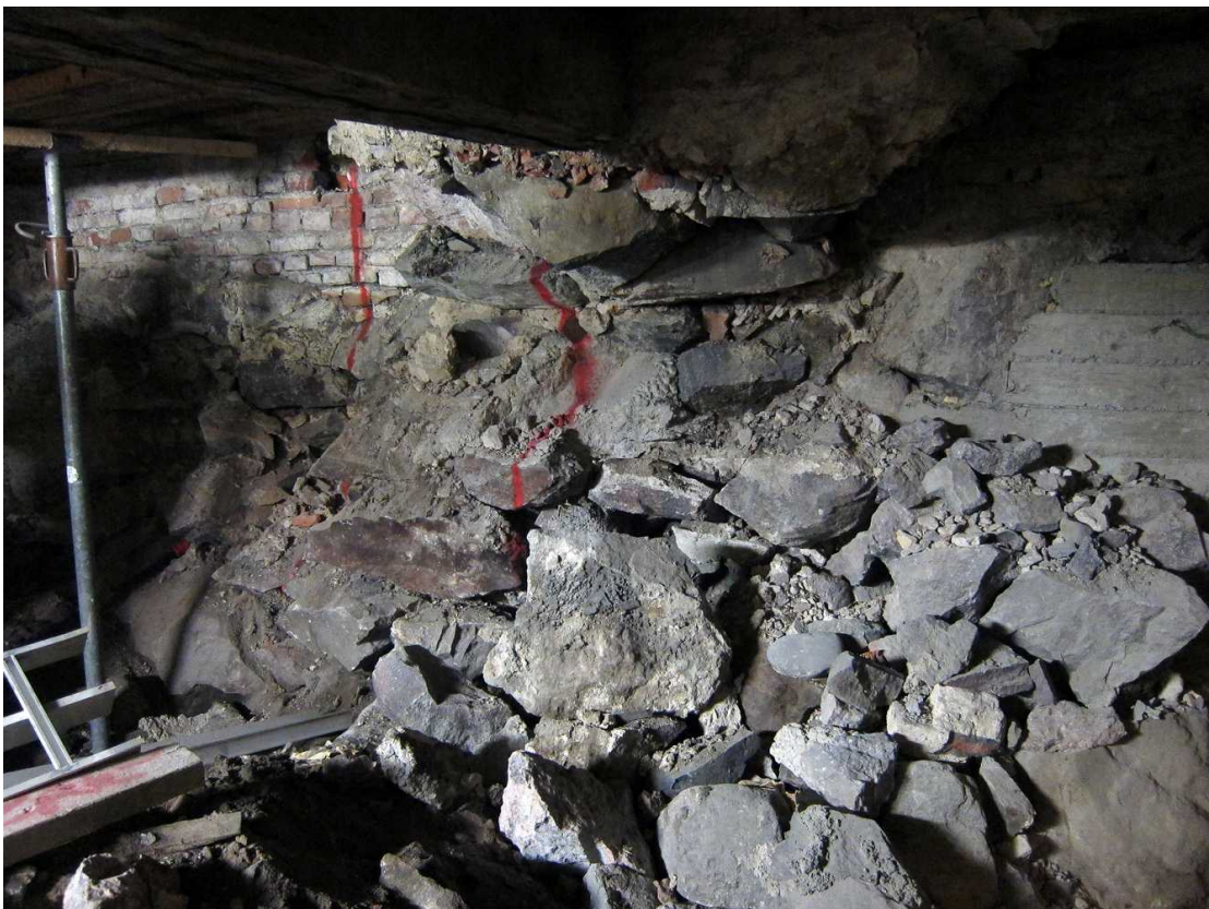
Kuva 214. Kellari 0007, tila C. Tilojen C ja D välinen kivi-tiiliseinä, uuninperustus ja mega-paalujen yläpuolinen betoniseinä. Kuvaussuunta SE. 21.9.2011.
