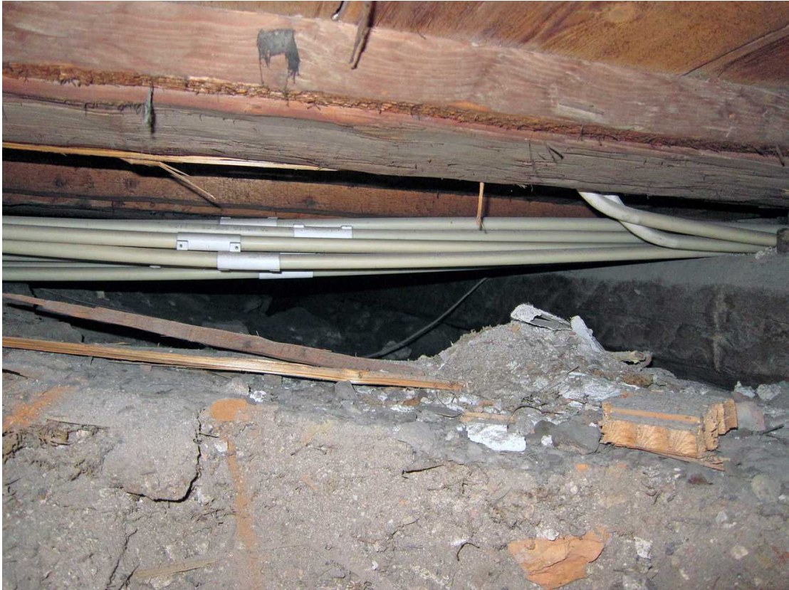
Kuva 143. Kellari 0007, tila A. Lattian ja alapuolisten maiden välissä oli matala tyhjä tila. Tilan B puolella oikealla näkyy läntisen matalan siiven keskellä pitkittäin sijainnut iso lattiavasa. Kuvaussuunta S. 16.8.2011.
