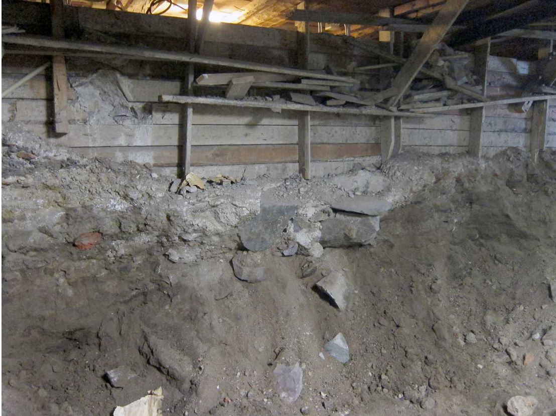
Kuva 211. Kellari 0007, tila C. Läntisen putkitunnelin itäseinä. Sen pinnalla on vielä betonilaidoitus, jonka edessä on putkitunnelin kaivannon täyttömaita. Kuvaussuunta NW. 30.8.2011.
