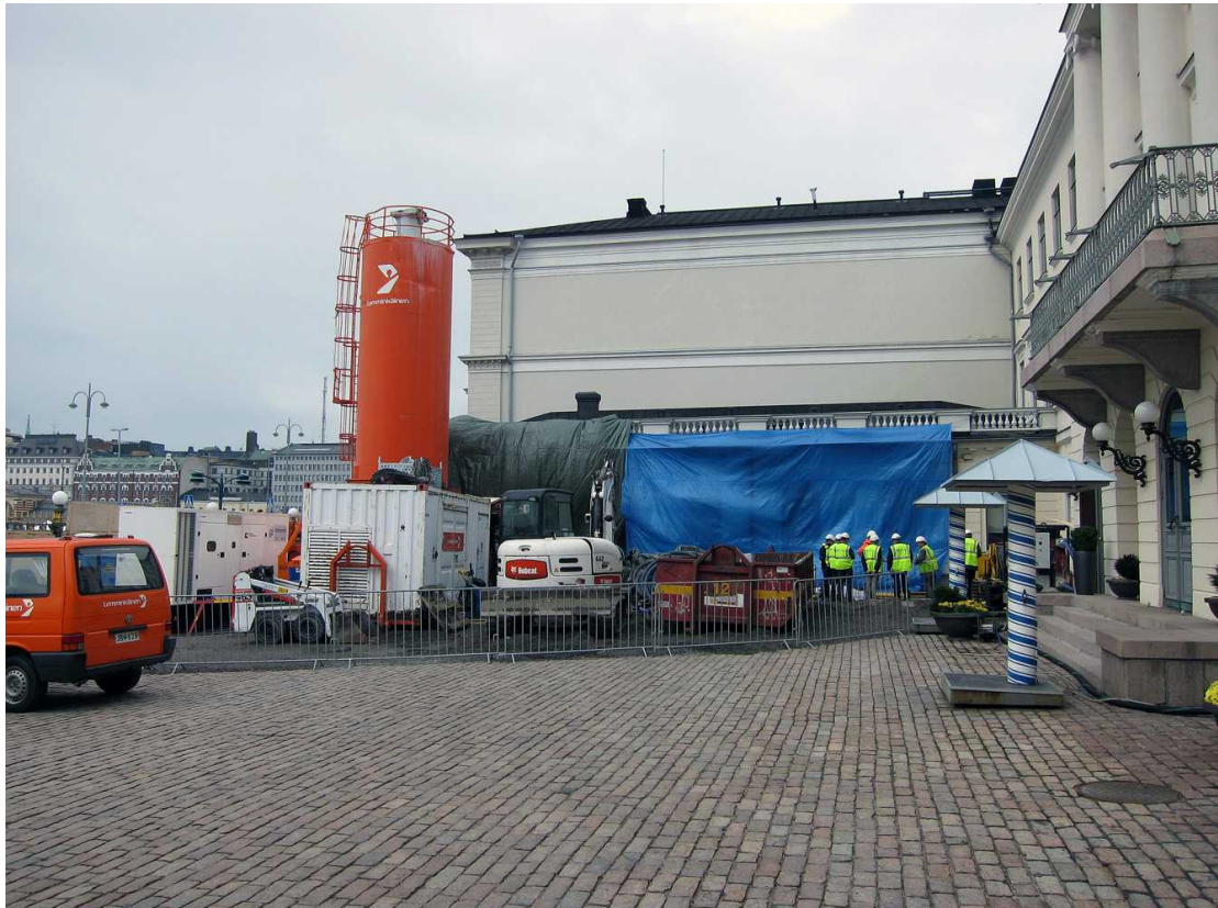
Kuva 233. Etupiha. Työmaa-alue. Kuvaussuunta W. 21.9..2011.
