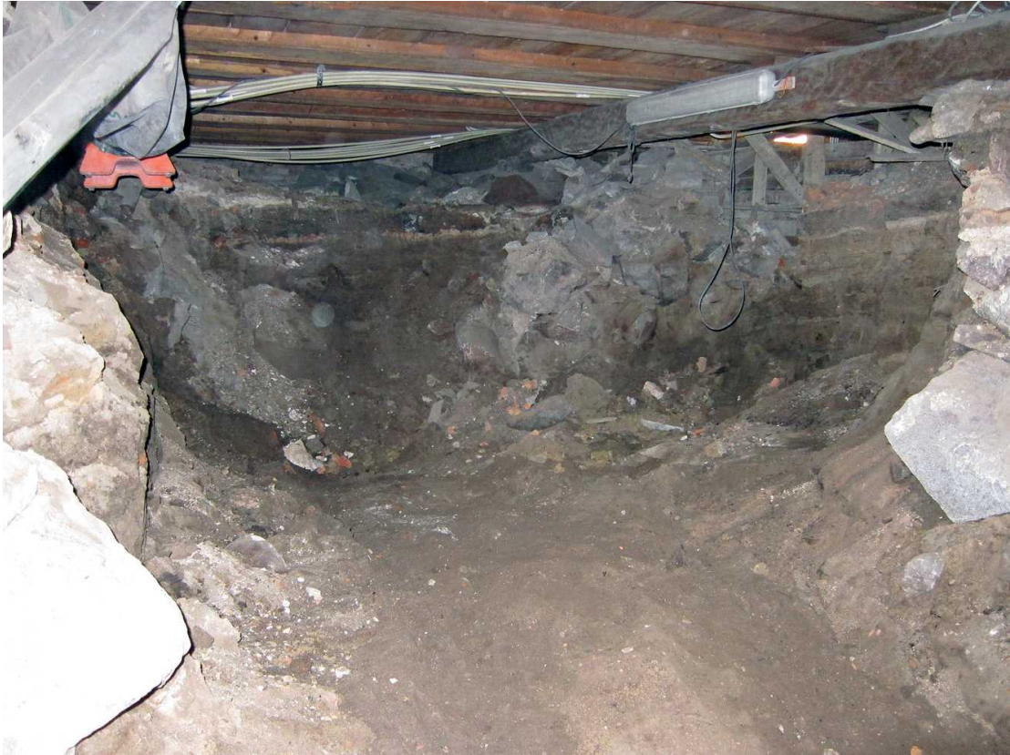
Kuva 183. Kellari 0007, tila C. Edellinen tilanne. Etualalla on tilojen A ja B välistä poikittaista kiviperustaa, keskellä tila B ja sen takana tilojen B ja C välinen osittain purettu poikittainen kiviperustus. Aivan takana lattian alla näkyy tilojen C ja D välinen poikittainen kiviperustus. Kuvaussuunta SW. 19.8.2011.
