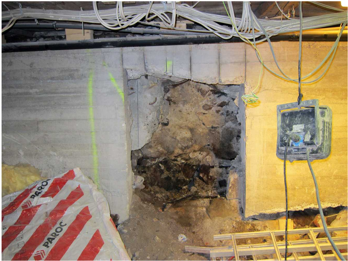
Kuva 270. Kellari 0007. Läntisen putkitunnelin länsiseinään on tehty aukko. Betoniseinän takana on megapaalut. Taustalla on Korkeimman oikeuden enimmäkseen muurattua kiviperustusta. Kuvaussuunta w. 30.7.2012.
