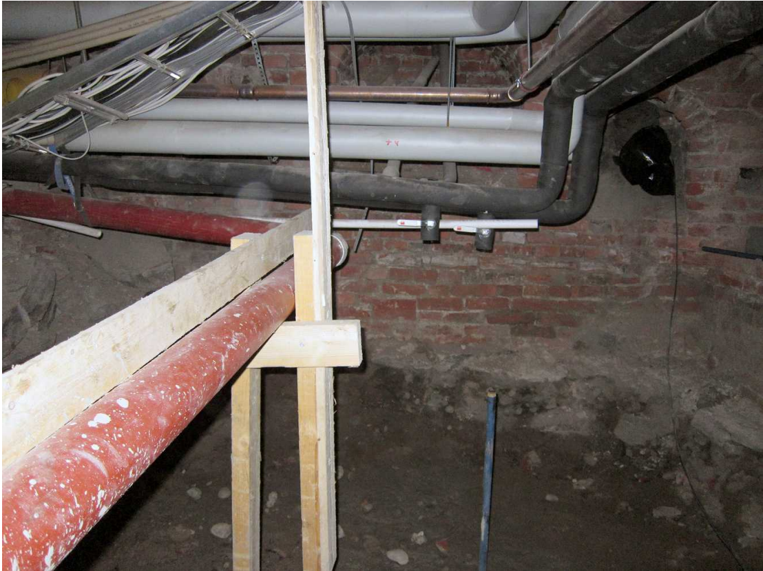
Kuva 57. Kellari 0031. Kellaritila tyhjentämisen jälkeen ja perustusten vahvistamiskokeen aikana. Kuvaussuunta E. 18.8.2011.
