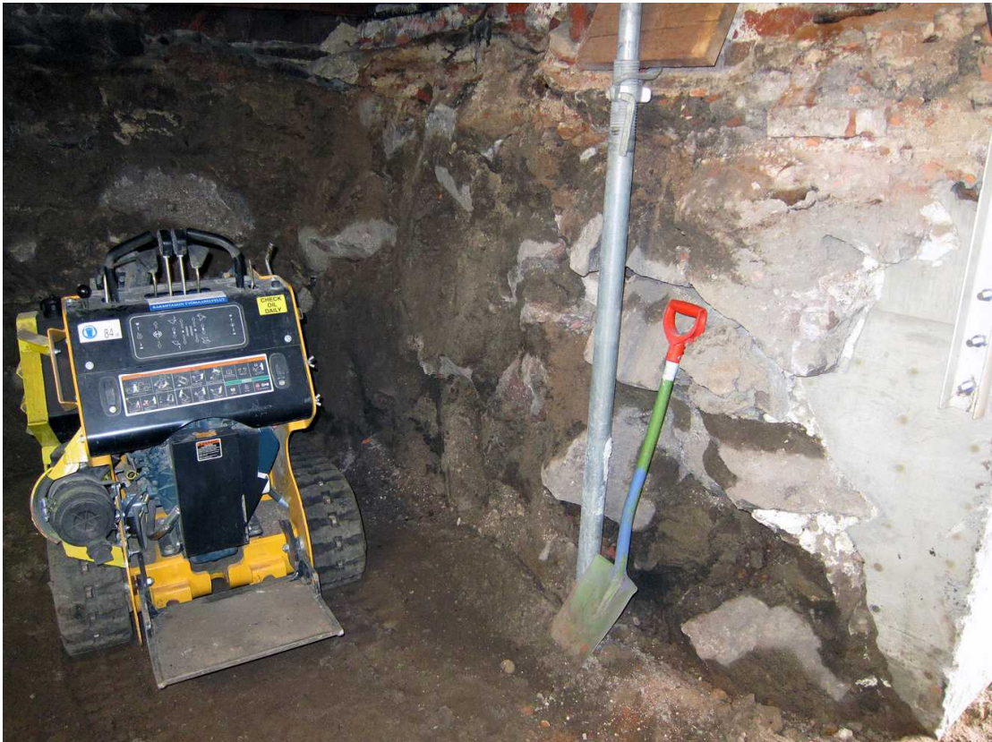
Kuva 220. Kellari 0007, tila A. Tilan A itäseinä. Kuvaussuunta NNE. 1.9.2011.
