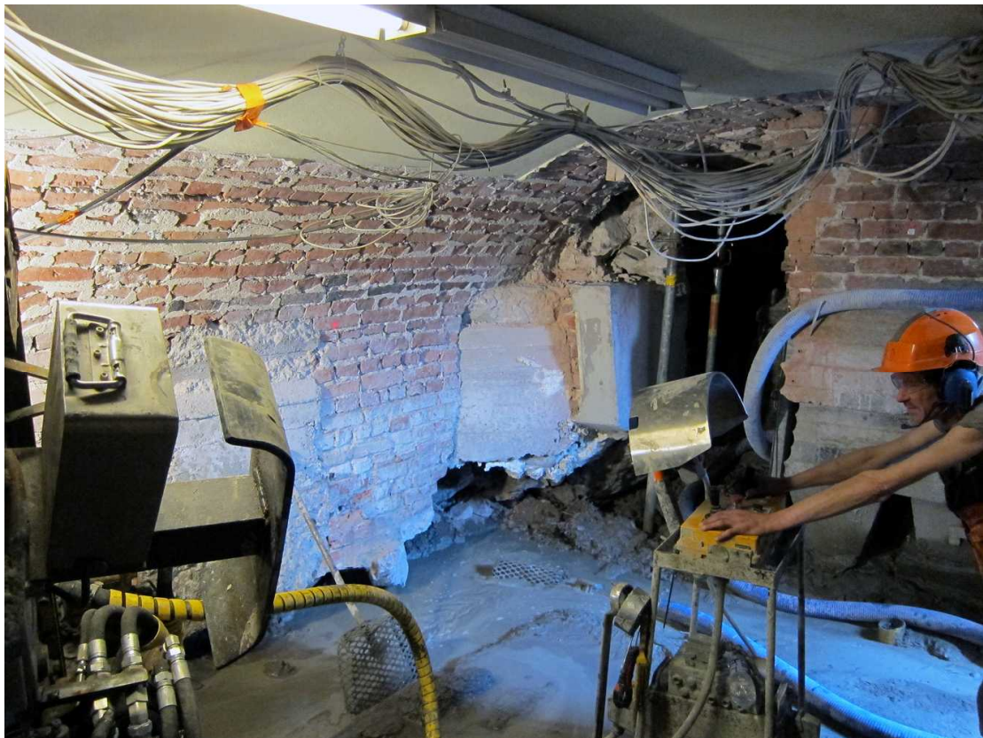
Kuva 247. Kellari 0002. Kellaritilan koillisosa, jossa on poistettu myös betonikorokkeet. Kellaritilan itäseinään on tehty aukko 1. kerroksen eteisaulan alapuoliseen tilan pääsemiseksi. Kuvaussuunta NE. 5.7.2012.
