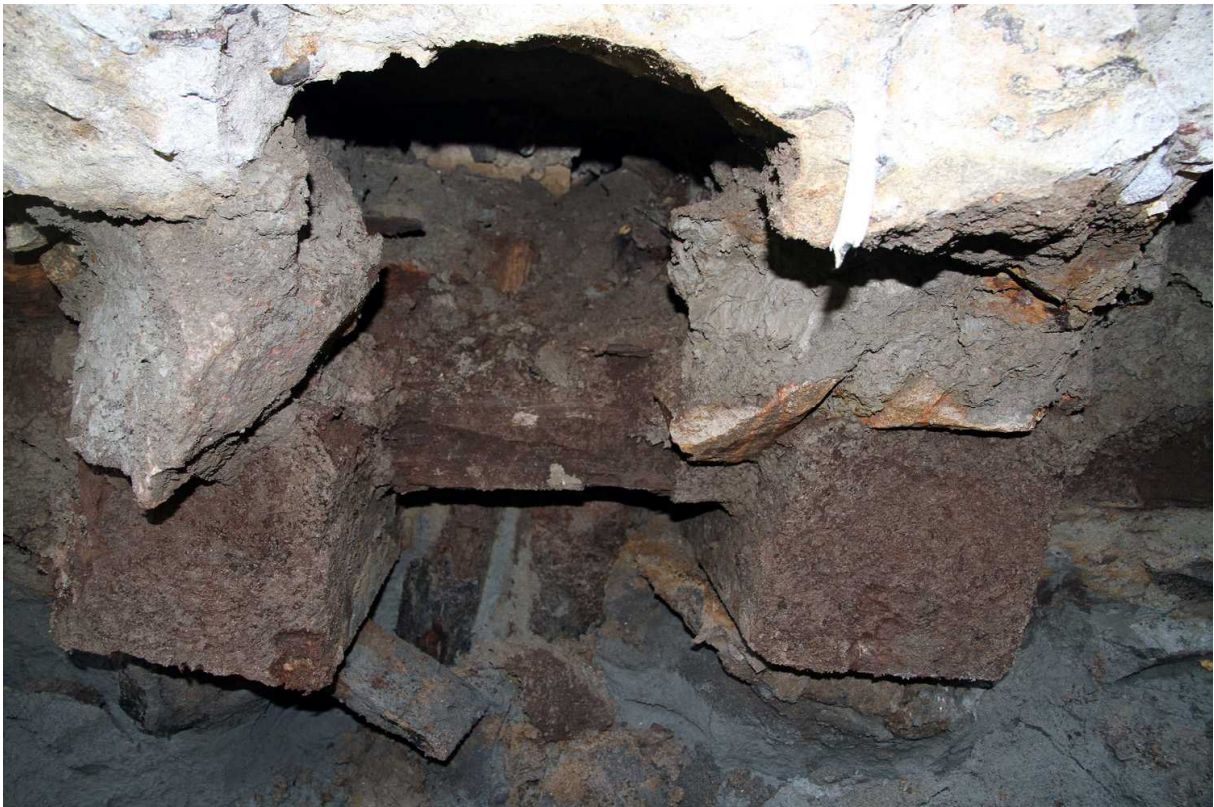
Kuva 82. Etupiha. Lähikuva puarinasta. Taaempänä näkyy pystypaaluja. Kuvaussuunta N. 13.8.2010.
