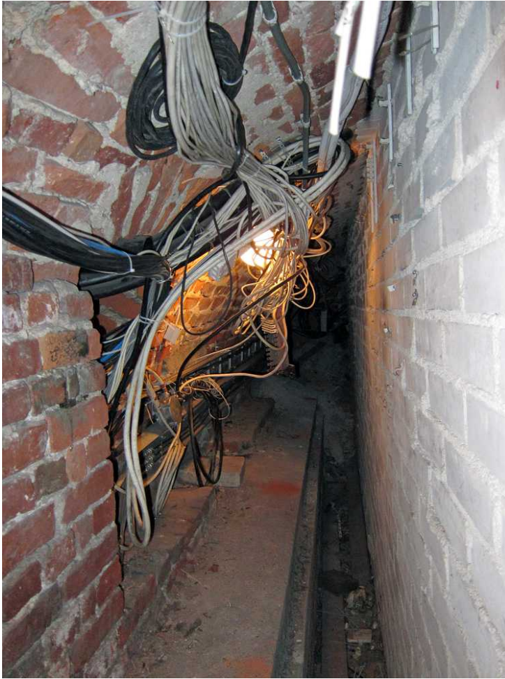
Kuva 61. Kellari 0002. Kellarin vanhan ja uuden seinän välinen tila. Vanhan seinän äärellä näkyy perustuksen uudehko betonivahvistus. Kuvaussuunta W. 28.6.2011.
