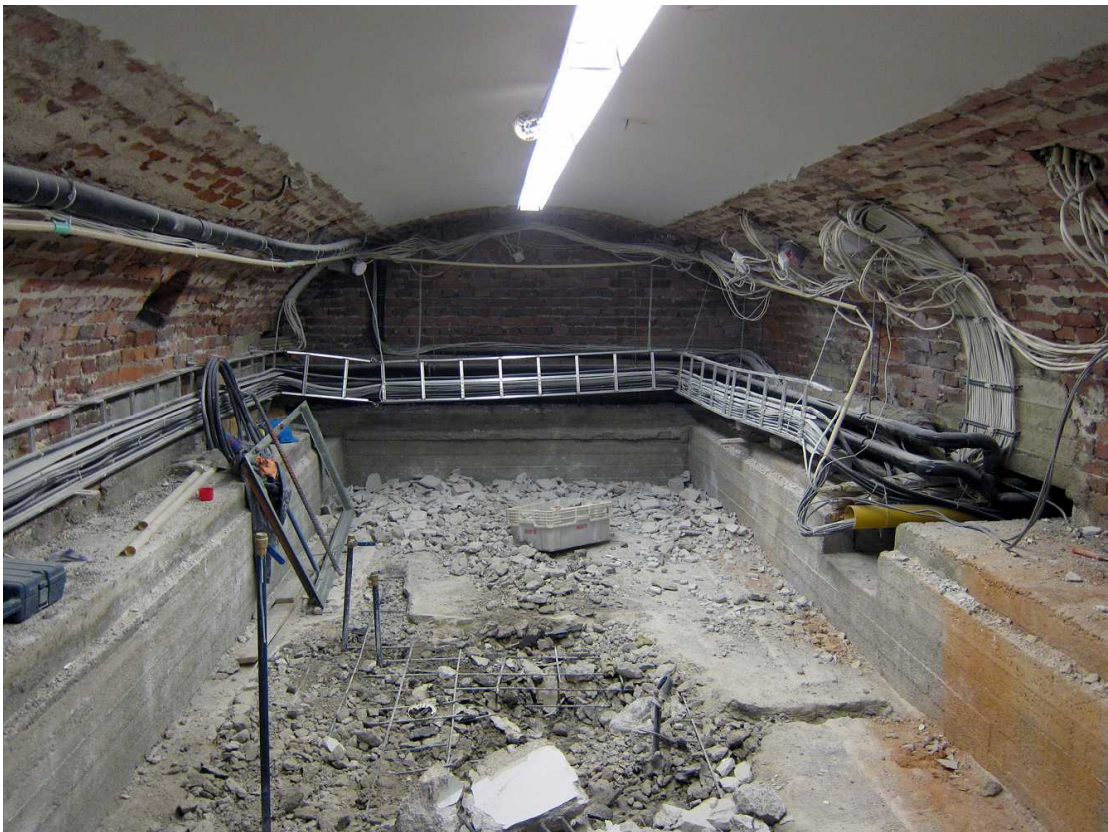
Kuva 74. Kellari 0006. Kaikki uudet seinät on purettu. Kuvaussuunta W. 1.8.2011.
