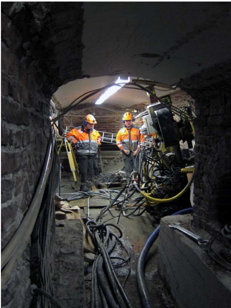
Kuva 76. Kellari 0006. Perustusten vahvistamiskokeiden töitä tehdään. Kuvaussuunta W. 21.9..2011.
