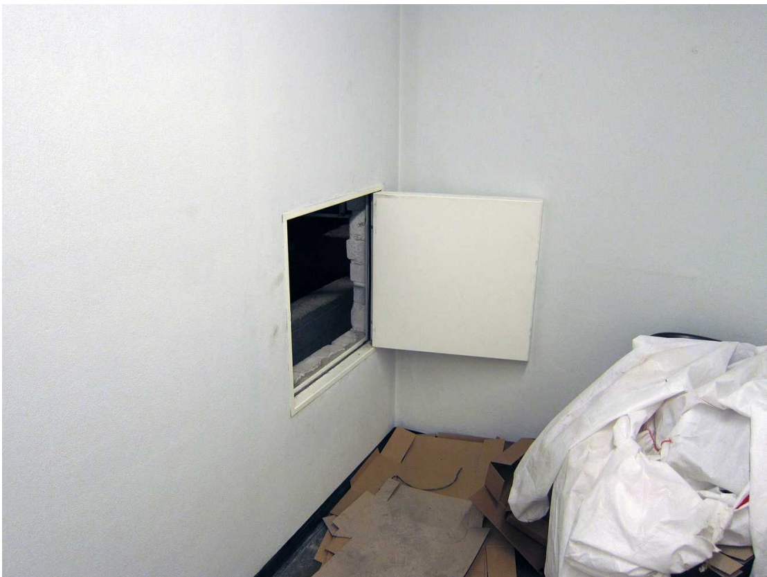
Kuva 70. Kellari 0006. Kellaritilan lounaisnurkassa oli luukku läntisen matalan siiven kellarin 0007 putkitunneliin. Kuvaussuunta SW. 28.6.2011.
