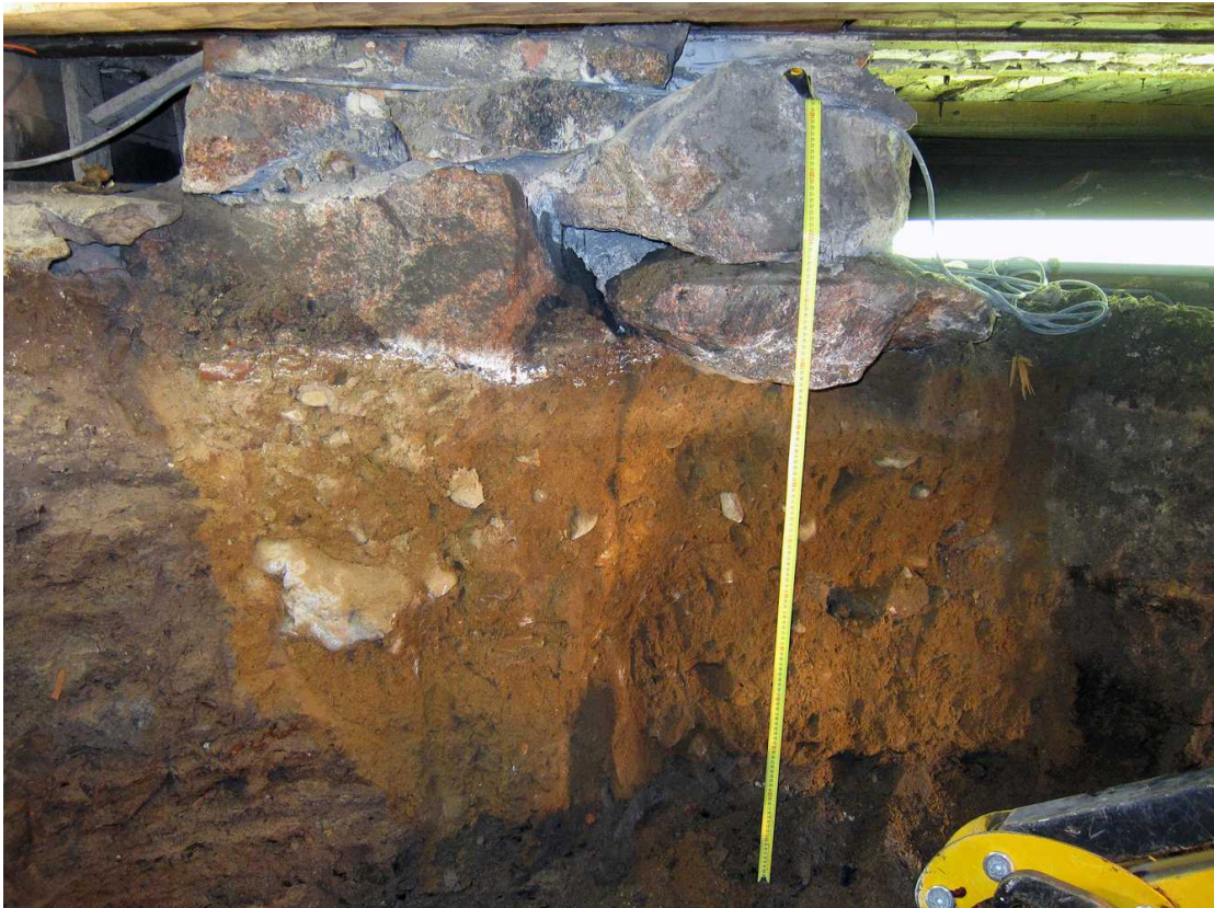
Kuva 146. Kellari 0007, tila A. Sisäseinän kiviperustus ( dokumentointikohta 14 ) varhaisessa tyhjennysvaiheessa. Sen alapuolinen sorakerros erottuu selvästi. Sorakerroksen alle menee vasemmalta vanhoja kerroksia. Kuvaussuunta N. 16.8.2011.
