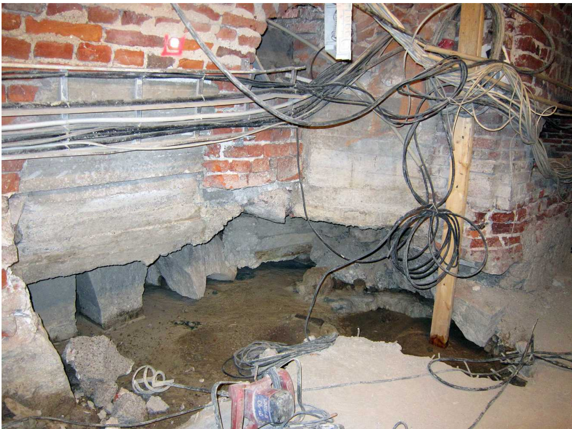
Kuva 251. Kellari 0002. Kellaritilan lounaisnurkan megapaalut seinän alla elokuun puolessavälin. Kuvaussuunta SW. 15.8.2012.
