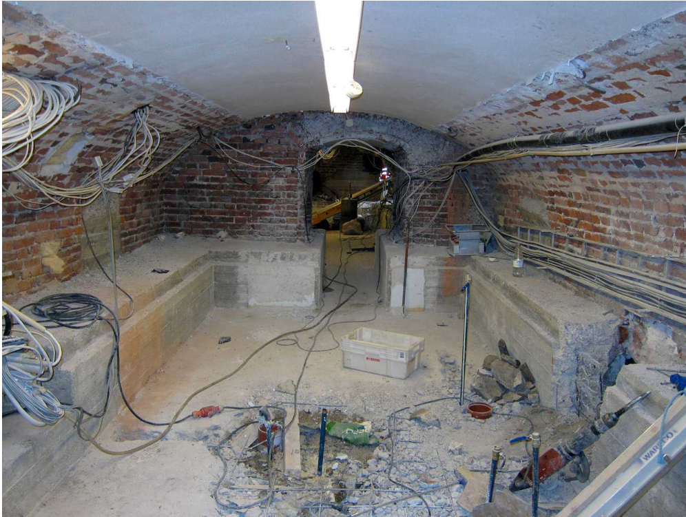
Kuva 75. Kellari 0006. Kellaritila seinien purkamisen jälkeen ja perustusten vahvistamiskokeiden aikana. Kuvaussuunta E. 18.8.2011.
