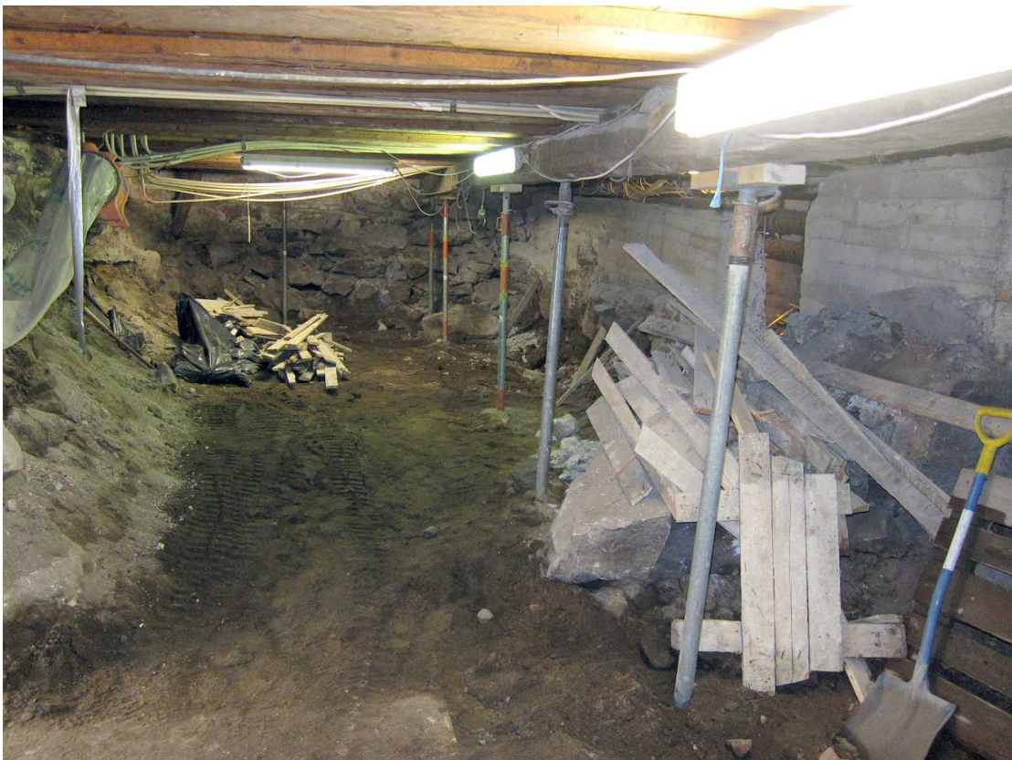
Kuva 202. Kellari 0007, tila C. Tilat A-C tyhjennettynä läntiseen putkitunneliin ja eteläpään tilan D poikittaiseen kivierustukseen saakka. Itäseinän alaosan edessä on maamassoja. Kuvaussuunta SSW. 1.9.2011.
