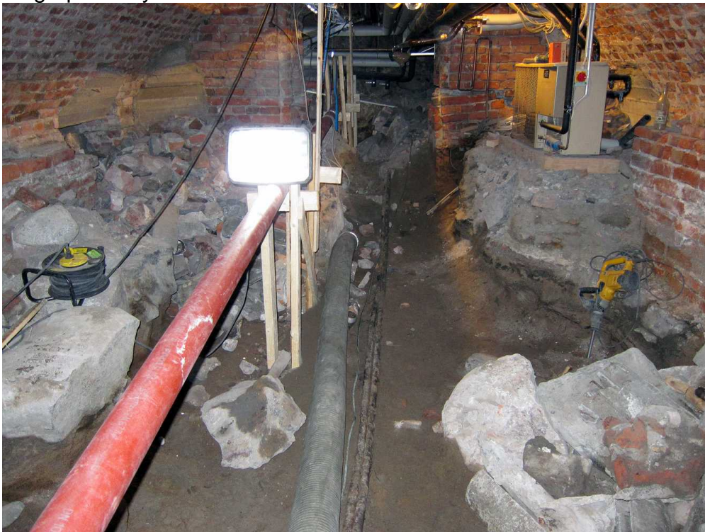
Kuva 38. Kellari 0032. Kellaritila tyhjentämisen edistyttyä. Kuvaussuunta E. 30.6.2011.
