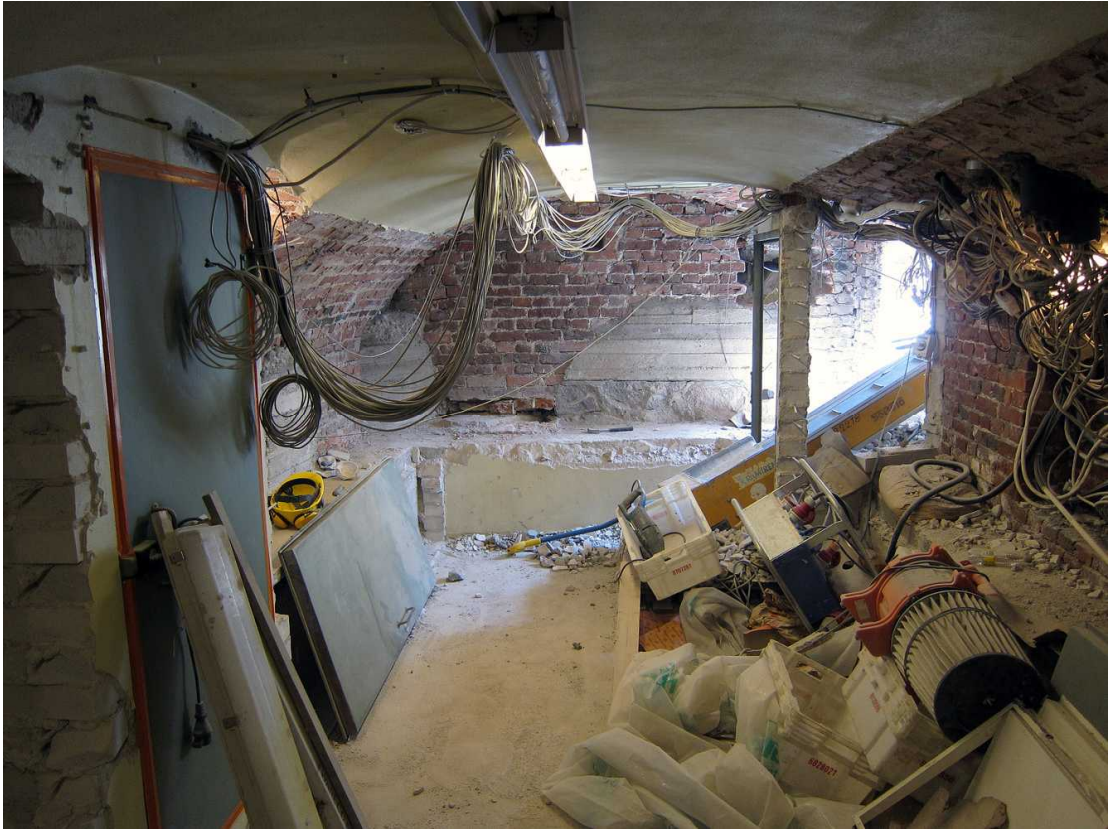
Kuva 65. Kellari 0002. Kellaritilan itäpää ja etupihalle johtava portaikko. Vasemmalla on työnajaksi suljettu ovi ja portaat 1. kerrokseen. Kuvaussuunta E. 1.8.2011.
