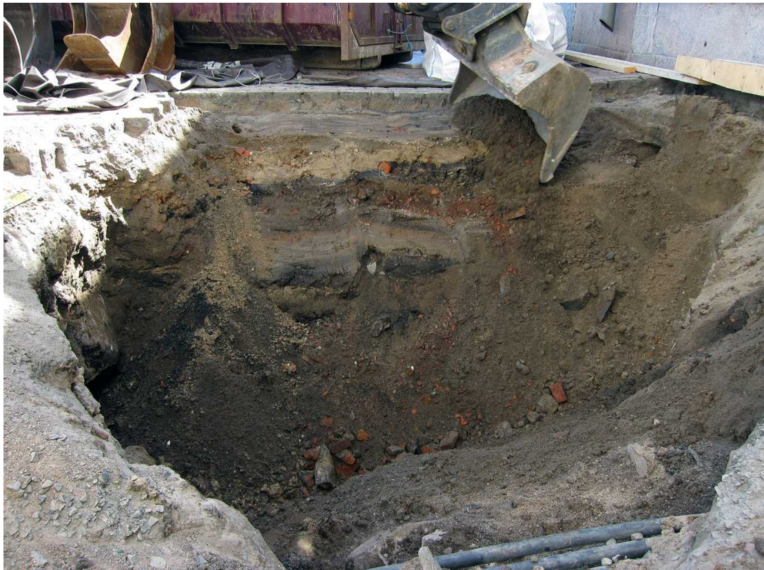
Kuva 121. Etupiha. Kuopan seiniä viistetään. Kuvaussuunta S. 14.7.2011.
