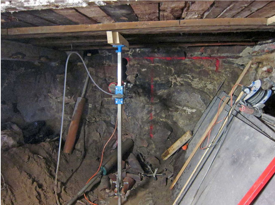
Kuva 219. Kellari 0007, tila A. Tilan A pohjoisseinä, jonka läpi on alettu poraamaan reikiä aukon tekemiseksi päärungon kellaritilaan 0006. Kuvaussuunta N. 21.9.2011.
