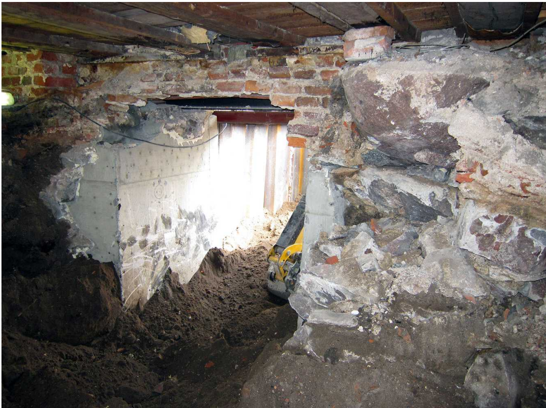
Kuva 132. Kellari 0007, tila A. Aukko uusine betoniseinineen. Kuvaussuunta NE. 17.8.2011.
