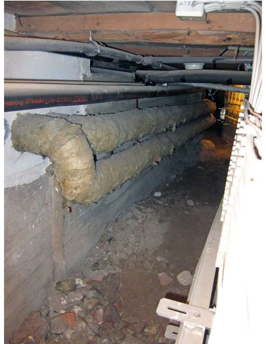
Kuva 227. Kellari 0007, läntinen putkitunneli. Putkitunnelin keskiosa tilan B kohdalla. Kuvaussuunta NW. 30.8.2011.
