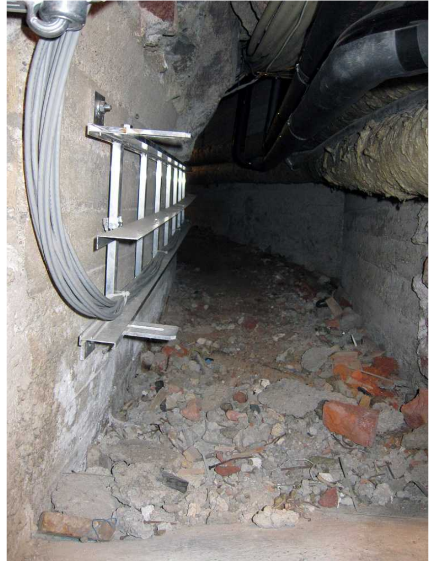
Kuva 72. Kellari 0006. Putkitunneli edellisestä kohdasta matalaan läntiseen siipeen. Kuvaussuunta S. 28.6.2011.
