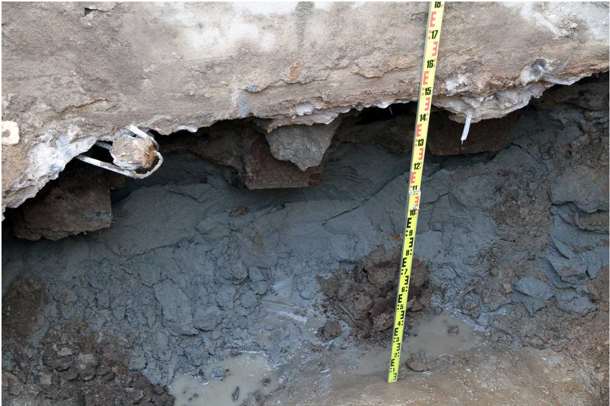
Kuva 81. Etupiha. Betoniperustuksen takana ja alkuperäisen kiviperustuksen alla näkyi koskemattoman saven päällä puarina. Kuvaussuunta NNE. 13.8.2010.
