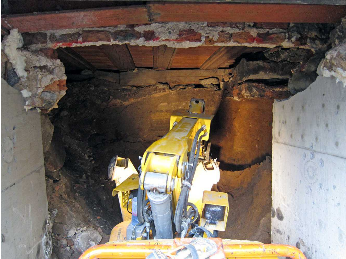
Kuva 131. Kellari 0007, tila A. Tilan itäpuolisko, tyhjennettiin aluksi koneellisesti läntisen matalan siiven keskellä olleeseen pitkittäiseen lattiavasaan saakka. Kuvaussuunta W. 16.8.2011.
