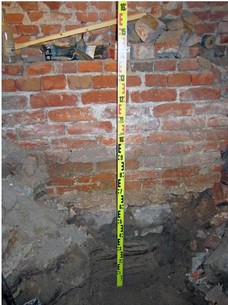
Kuva 35. Kellari 0032. Eteläseinän alaosa tiilikorokkeen kohdalla kellaritilan keskiosassa, dokumentointikohdassa 6. Kuvaussuunta SSW. 28.6.2011.
