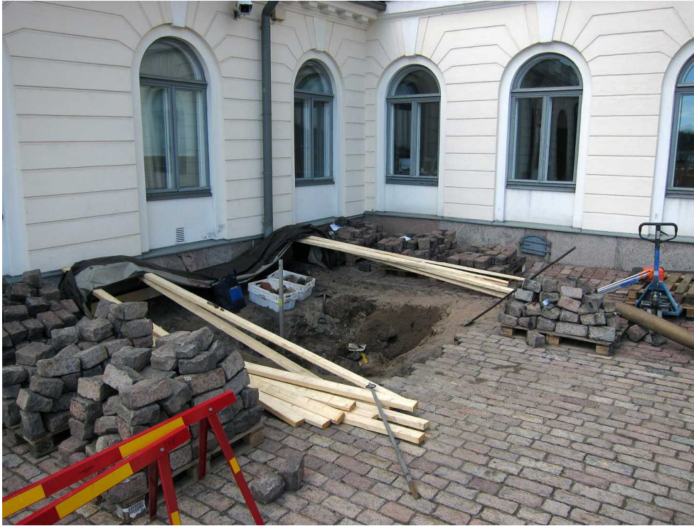
Kuva 95. Etupiha. Läntisen matalan siiven kellarin tyhjentämistä ja rakentamista varten vuonna 2011 pihan luoteisnurkkaan alettiin kaivaa kuoppaa työaukon tekemiseksi siiven itäperustukseen. Kuvaussuunta W. 13.7.2011.
