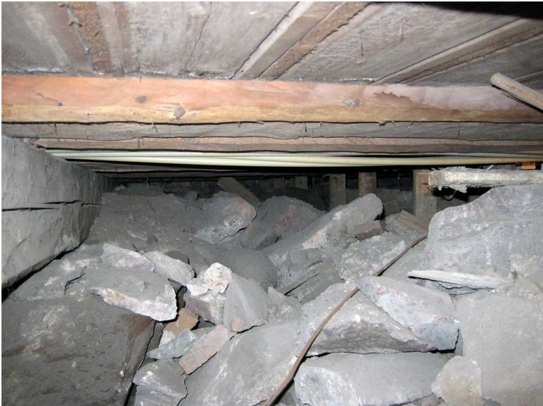
Kuva 190. Kellari 0007, tila C. Maakerrosten ja lattian välinen tyhjä tila tilassa C länsipuoliskon puolella pitkittäisen lattiavasauksen ja läntisen putkitunnelin välissä. Kuvaussuunta S. 26.8.2011.
