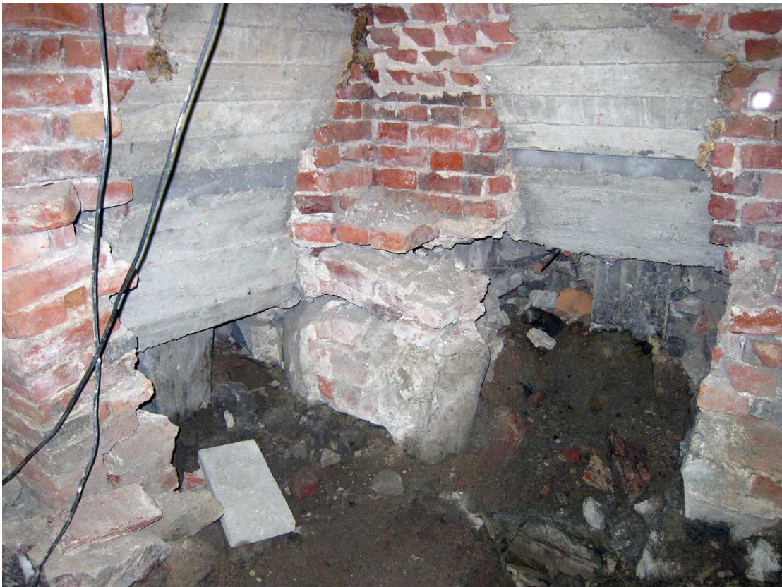
Kuva 241. Kellari 0031. Kellaritilan luoteisnurkan megapaalut. Kuvan vasemmassa reunassa on oviaukko tilaan 0032. Kuvaussuunta NW. 15.8.2012.
