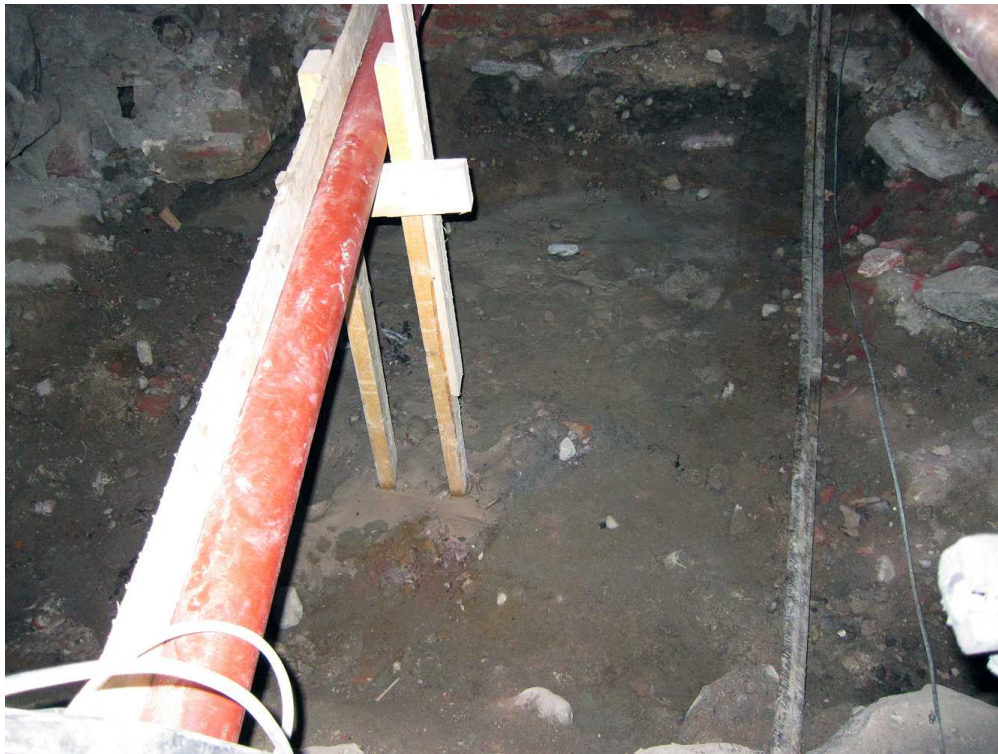
Kuva 59. Kellari 0031. Kellarin lattia tyhjentämisen loppuvaiheessa. Kuvaussuunta E. 14.7.2011.
