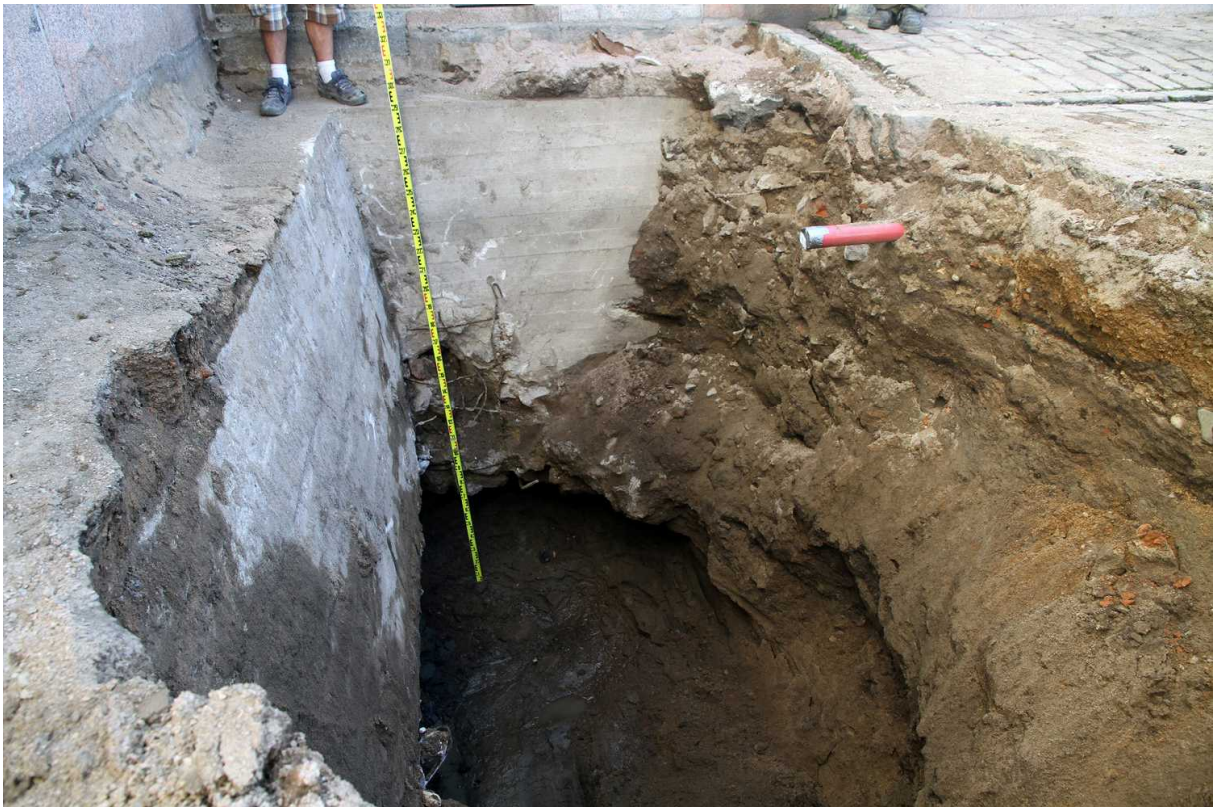
Kuva 80. Etupiha. Koekuopassa näkyi linnan vuoden 1960 mega –paalutuksen aikaisia perustusten betonirakenteita ja niiden takia uudempia täyttöhiekkoja muilla sivuilla. Kuvaussuunta E. 13.8.2010.
