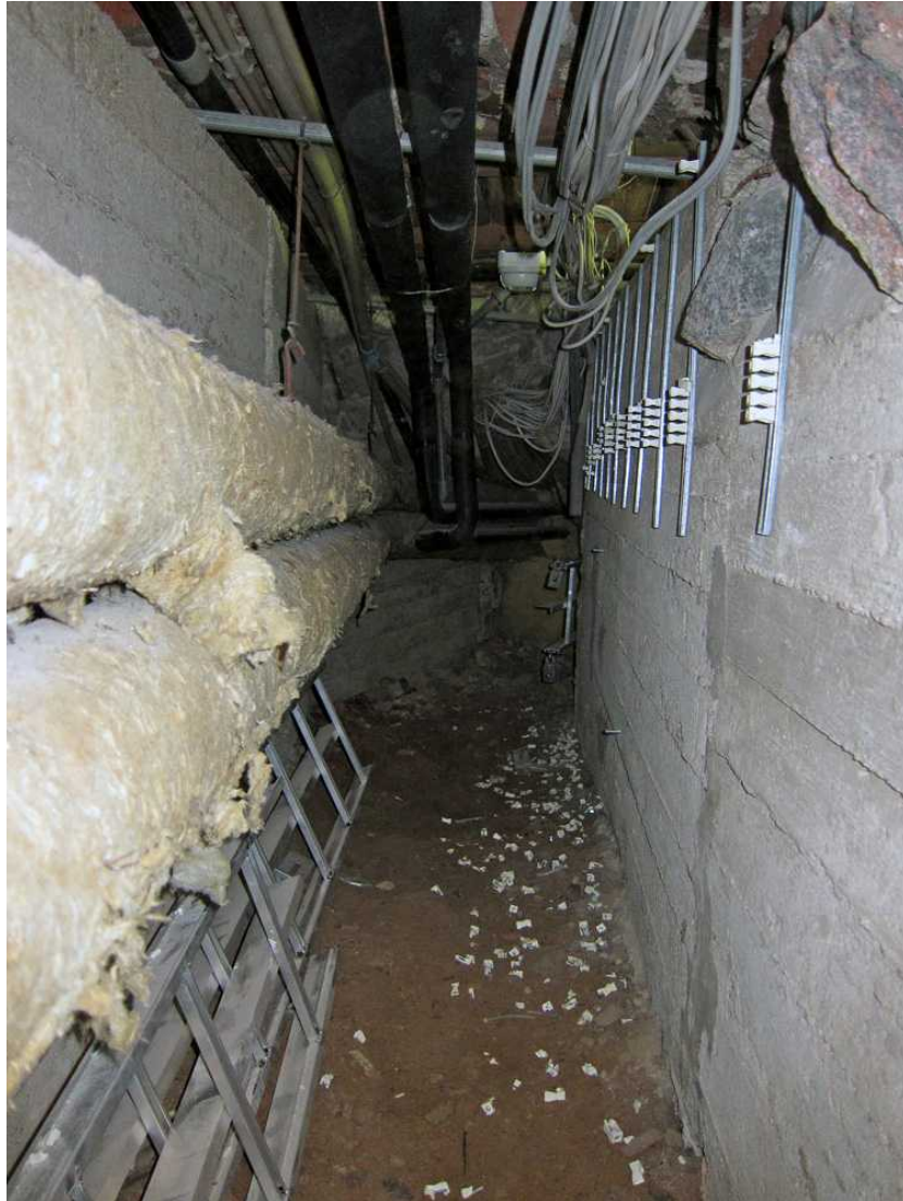
Kuva 224. Kellari 0007, läntinen putkitunneli. Putkitunnelin pohjoispää tilan A kohdalla. Kuvaussuunta N. 1.9..2011.
