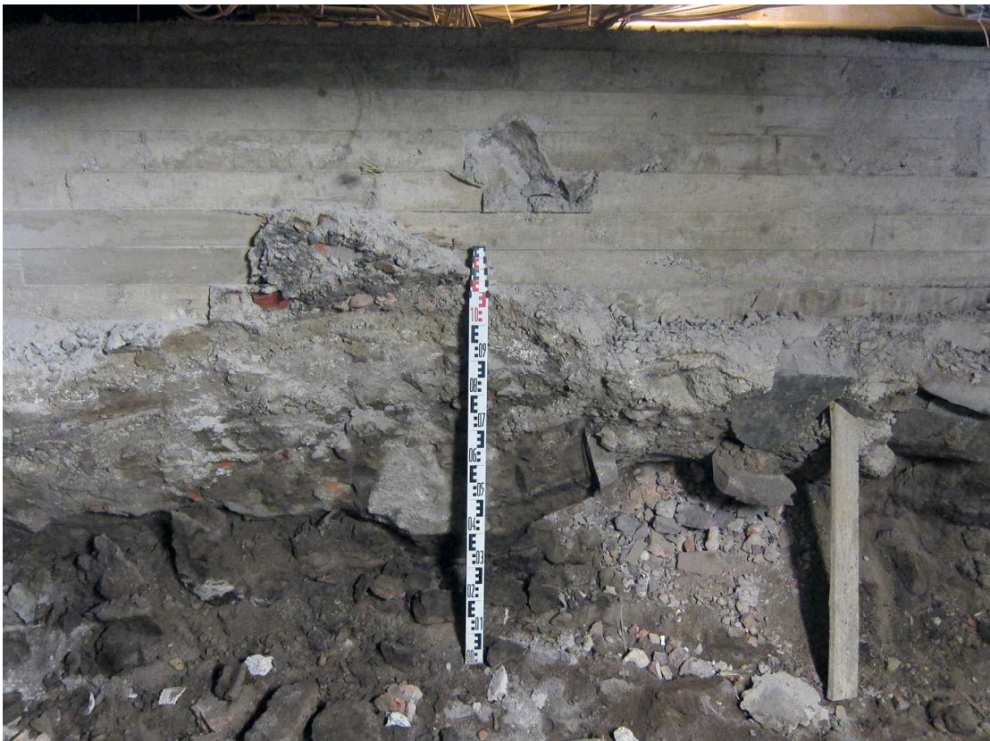
Kuva 212. Kellari 0007, tila C. Läntisen putkitunnelin itäseinä, josta on poistettu betonilaidoitus. Kuvaussuunta W. 1.9.2011.
