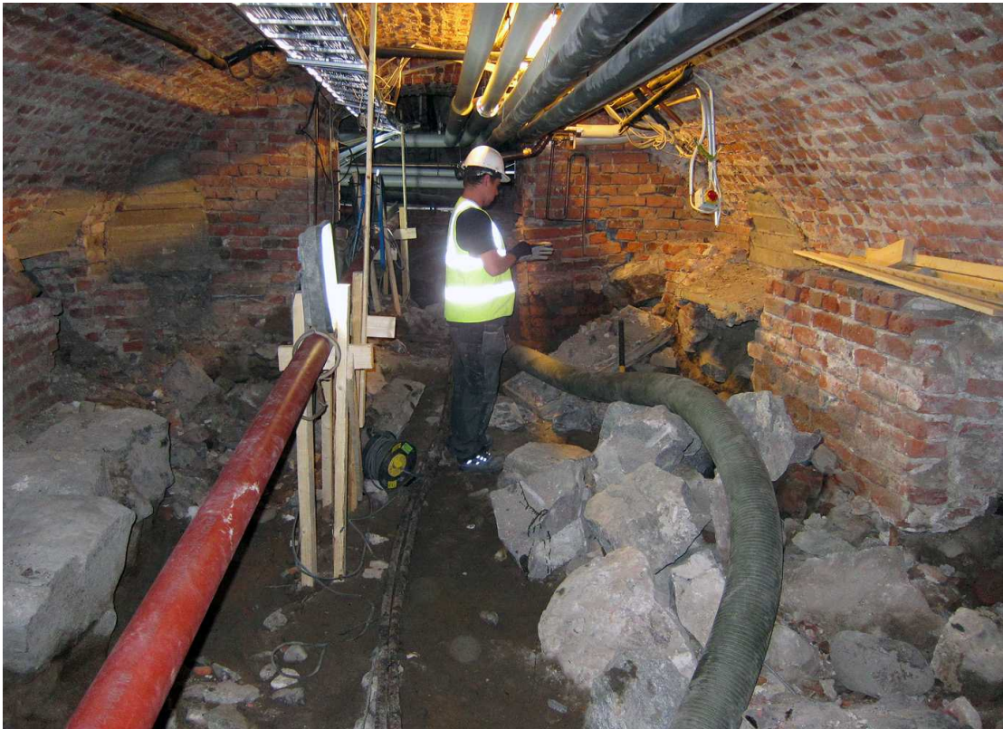
Kuva 40. Kellari 0032. Edellinen tila tyhjentämisen edistyttyä lisää. Tässä tilassa tiilikorokkeisiin tehtyjä mega-palureikien kohtia ei ole betonoitu korokkeen muotoon vaan korokkeen kohdat ovat tyhjiä. Kuvaussuunta E. 7.7.2011.
