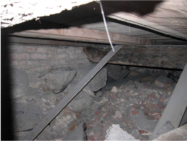
Kuva 221. Kellari 0007, tila D. Tilan D pohjoisosa. Kuvaussuunta NE. 21.9.2011.
