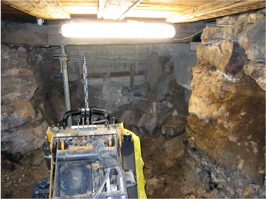
Kuva 147. Kellari 0007, tila A. Edellinen kaivaustila on kaivettu siiven länsiseinän äärellä kulkevaan putkitunnelin itäiseen laudoitettuun betoniseinään saakka. Oikealla on sisäseinän kiviperustus ja sorakerros, jonka alta on tullut aiemmasta vanhasta harmaasta kerroksesta eroava kerros. Kuvaussuunta W. 19.8.2011.
