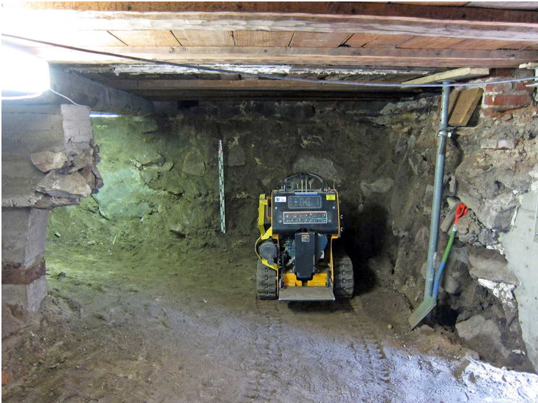
Kuva 216. Kellari 0007, tila A. Tilan A pohjoispuolisko on tyhjennetty. Vasemmalla olevan mega-paalun ja kauhakuormaajan välistä on poistettu muurattu kivirakenne. Kuvaussuunta N. 1.9.2011.
