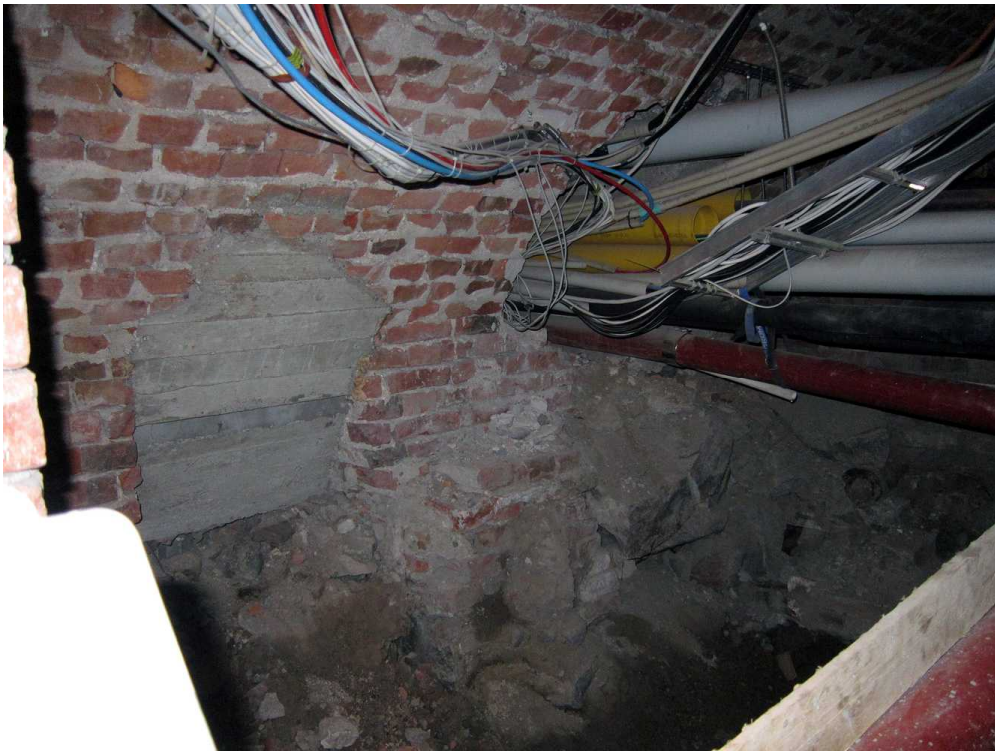
Kuva 56. Kellari 0031. Kellaritilan luoteisnurkka. Kaikki putket ja johdot kerääntyivät menemään pohjoisseinän läpi ahtaasta aukosta. Kuvaussuunta NE. 7.7.2011.
