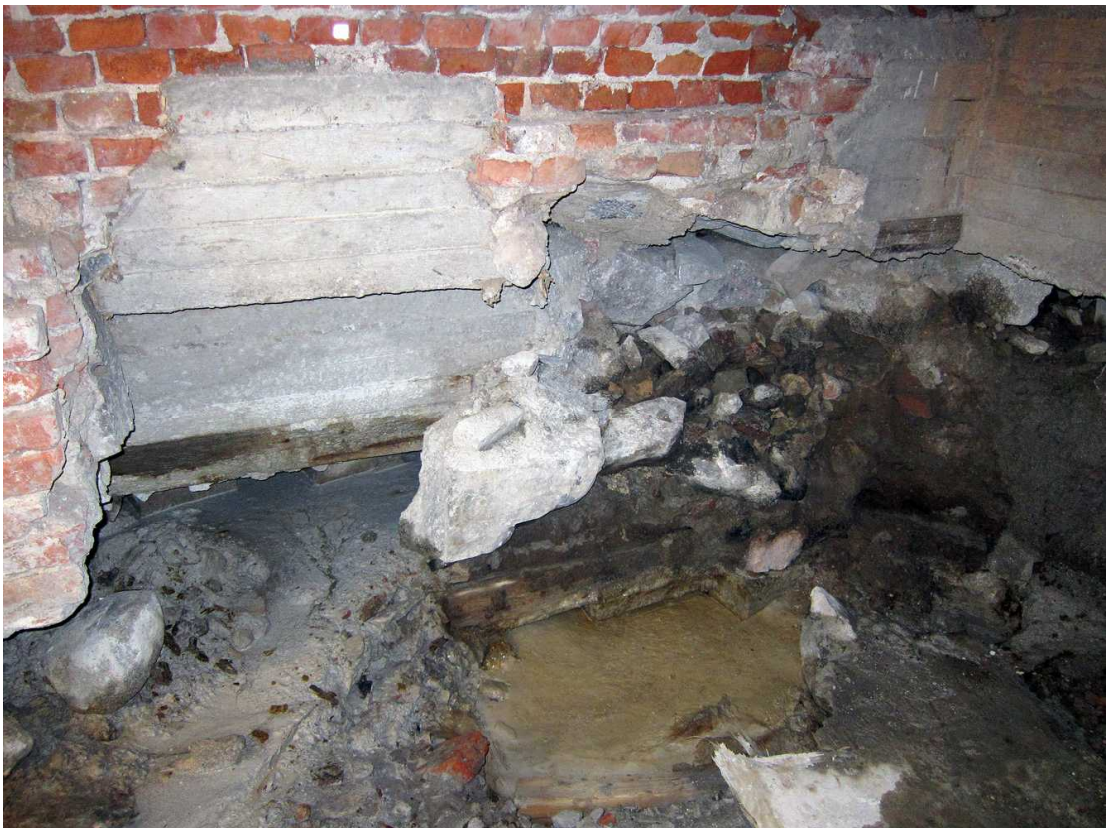
Kuva 239. Kellari 0032. Kellaritilan lounaisnurkassa näkyi tiilikorokkeen ja megapaalun länsipuolella tiiliseinän alla kiviperustaa ja sen alla puarina. Kuvaussuunta SSW. 15.8.2012.
