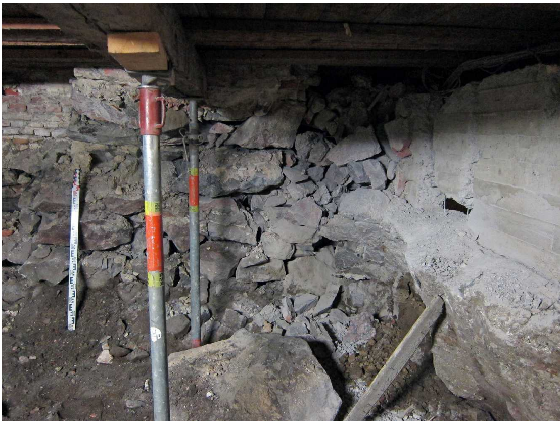
Kuva 210. Kellari 0007, tila C. Edellinen kivirakenne läntisen putkitunnelin vieressä. Kuvaussuunta S. 1.9.2011.
