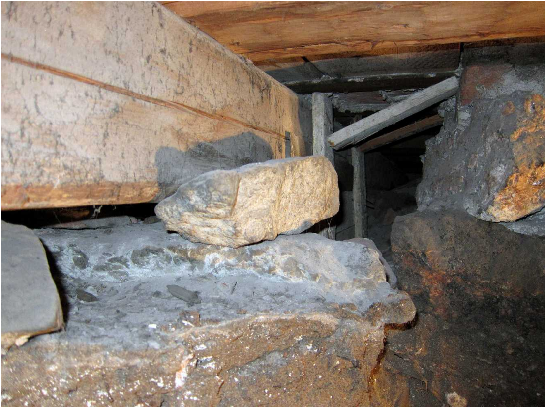
Kuva 144. Kellari 0007, tila A. Sisäseinän kiviperustan ja megapaalun pohjoispuolella sijainneen kivi-laastirakenteen ja pitkittäisen lattiavasan välinen tila. Kuvaussuunta N. 16.8.2011.
