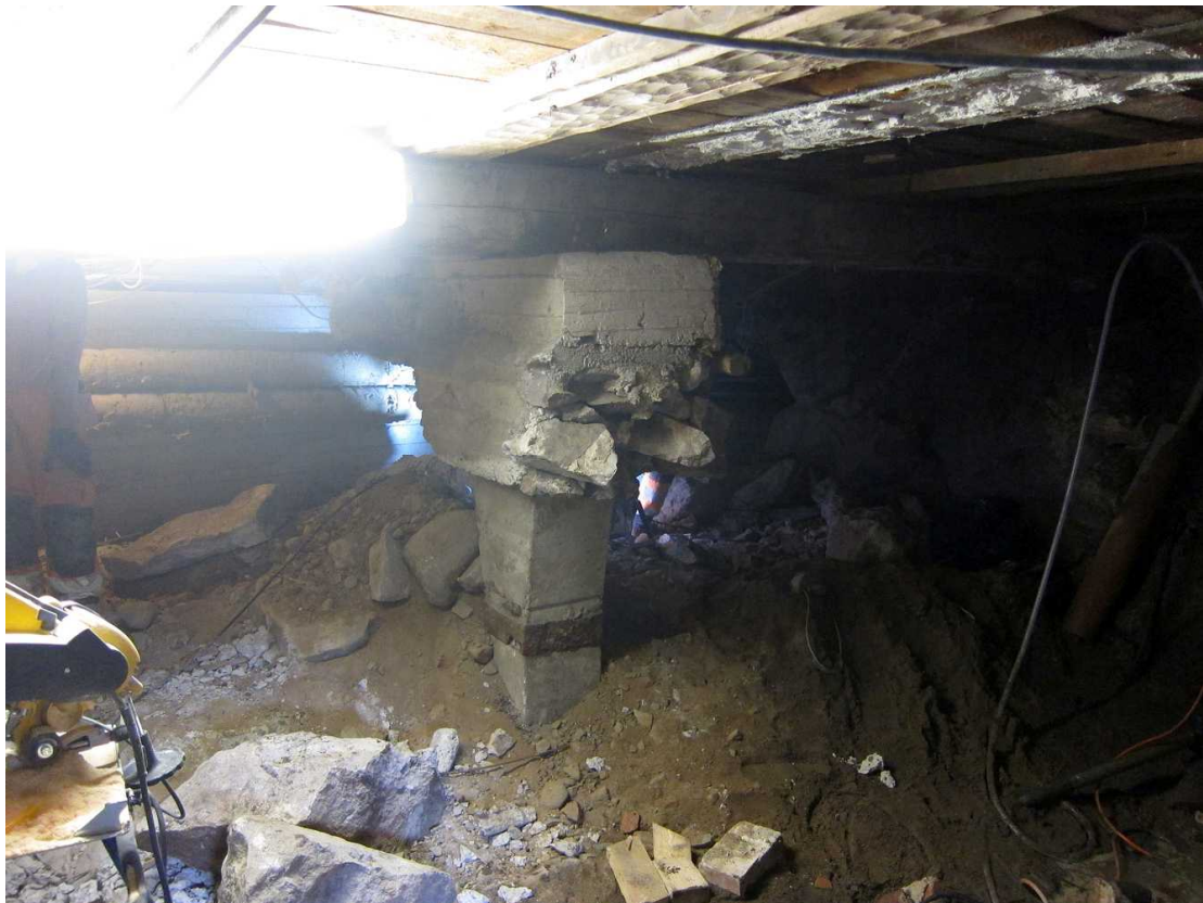
Kuva 158. Kellari 0007, tila A. Kaikkia rakenteita ja maakerroksia ollaan poistamassa megapaalun ympäriltä. Kuvaussuunta NW. 21.9.2011.
