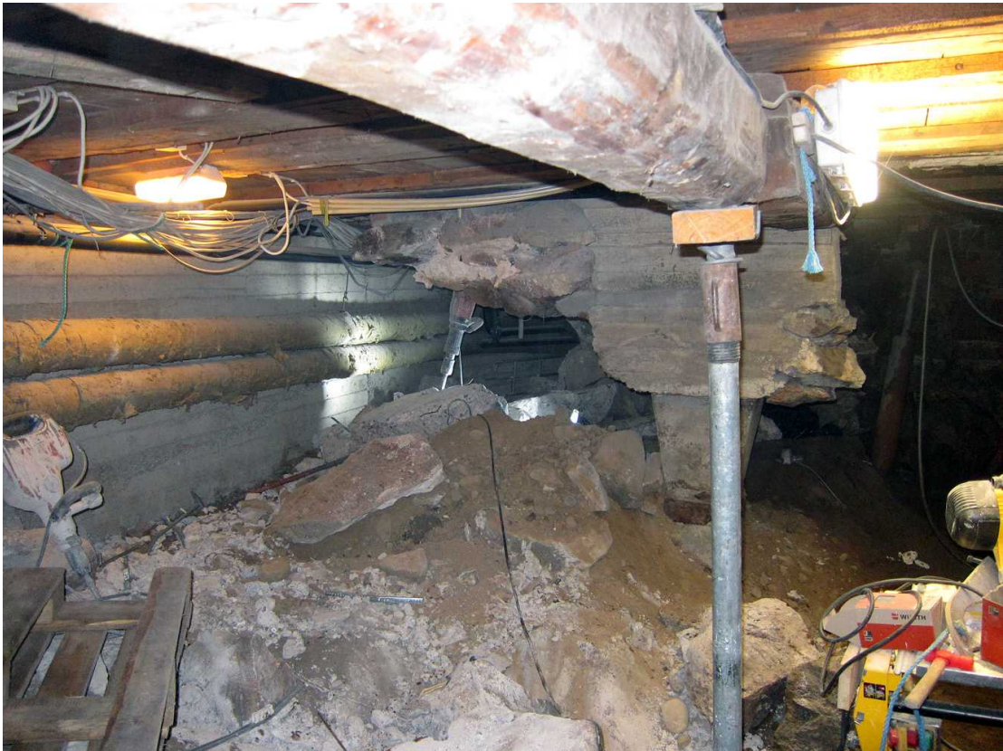
Kuva 159. Kellari 0007, tila A. Edellinen tilanne. Vasemmalla näkyvät putket ovat olleet läntisessä putkitunnelissa. Kuvaussuunta NNW. 21.9..2011.
