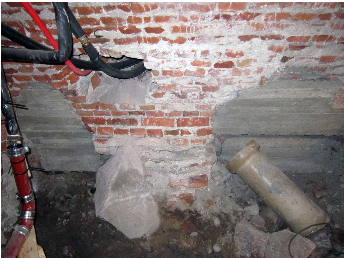
Kuva 46. Kellari 0033. Kellaritilan luoteisnurkan kahden megapaalun kohdat. Perustuskivet ja tiilikoroke on poistettu niiden kohdalta. Paalupaikkojen välissä näkyy seinässä kiinni oleva perustuskivi, joka on ollut tiilikorokkeen sisällä. Kuvaussuunta N. 30.6.2011.
