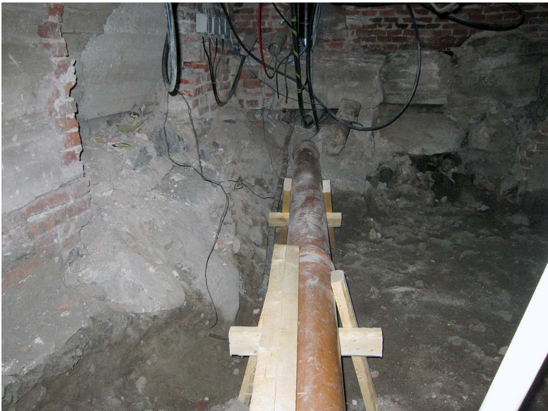
Kuva 8. Kellari 0033. Kellaritilan länsiosa tyhjentämisen jälkeen. Putki on tuettu puurakenteilla. Kuvaussuunta NNW. 18.8.2011.
