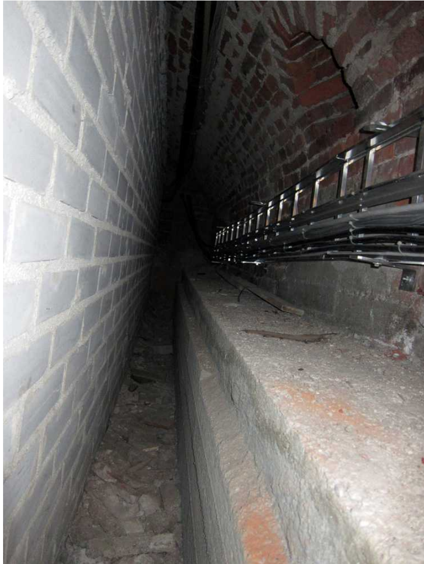
Kuva 71. Kellari 0006. Edellisen luukun kohdalta näkymä uuden ja vanhan seinän välisestä tilasta. Kuvaussuunta E. 28.6.2011.
