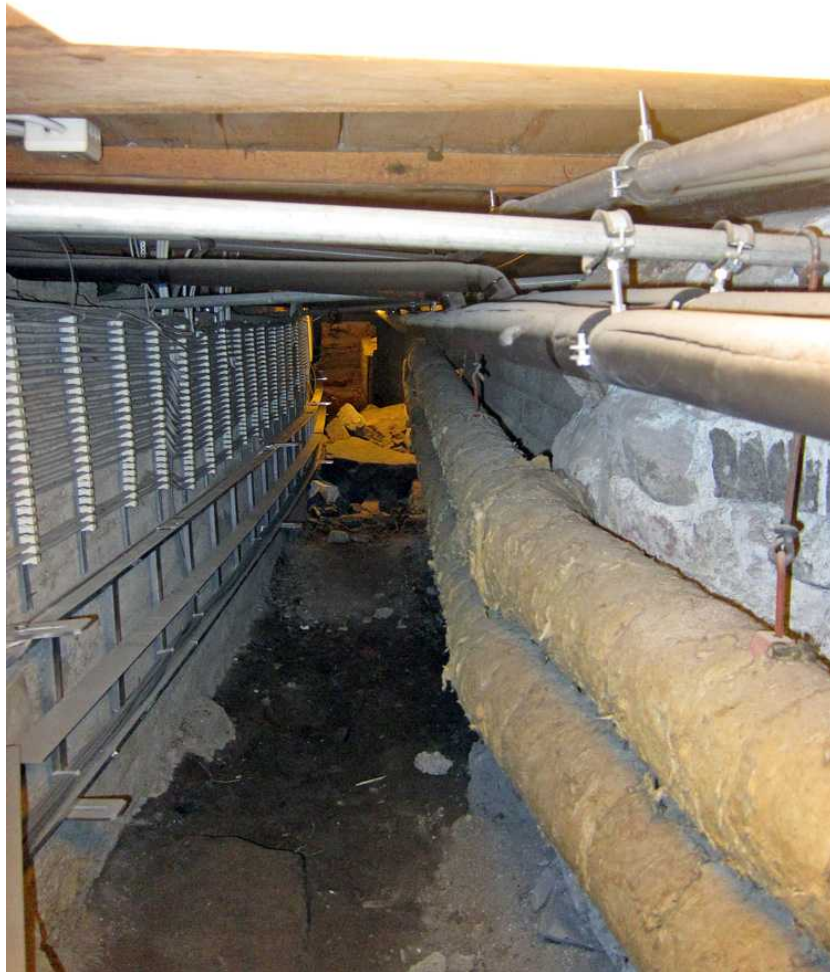
Kuva 226. Kellari 0007, läntinen putkitunneli. Putkitunnelin keskiosa B ja C kohdilla. Edessä on tilojen A ja B välisen kiviperustuksen jäännöksiä. Kuvaussuunta S. 19.8.2011.
