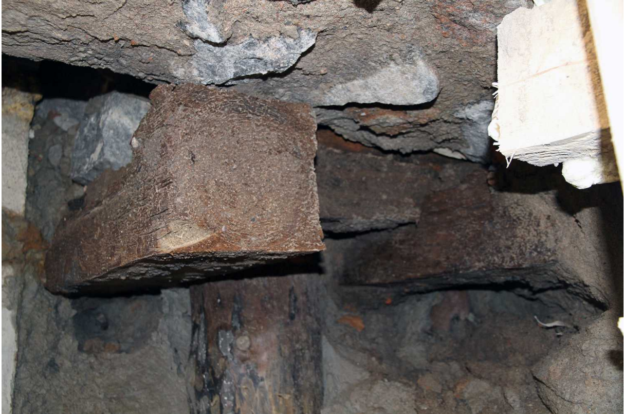
Kuva 93. Etupiha. Lähikuva puuarinasta. Kuvaussuunta NE. 4.10.2010.
