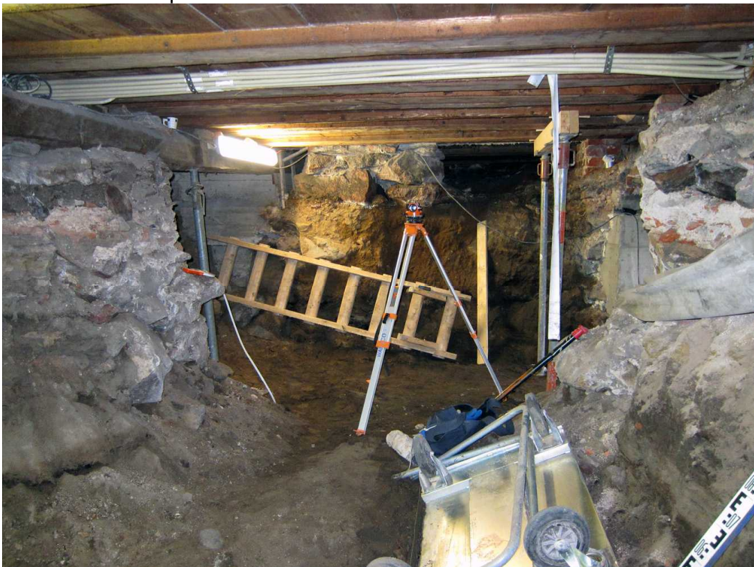
Kuva 152. Kellari 0007, tila A. Vaaituskone on tilassa A. Sen edessä molemmilla puolilla on poikittaisen kiviperustuksen jäännökset tilojen A ja B välissä. Taustalla näkyy sisäseinän kiviperustus ja vielä tyhjentämätön tilan A pohjoisin osa. Kuvaussuunta N. 26.8.2011.
