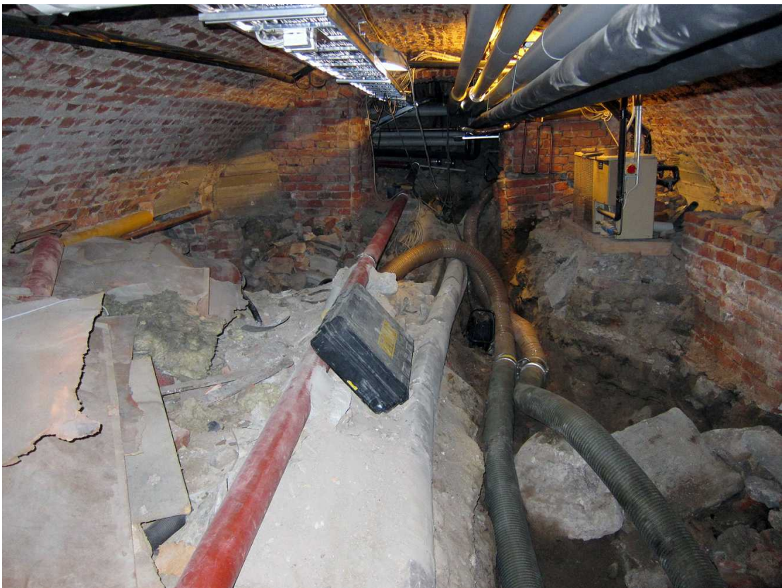
Kuva 30. Kellari 0032. Kellaritilan eteläosaa ja koilliskulmaa on tyhjennetty. Kuvaussuunta E. 28.6.2011.
