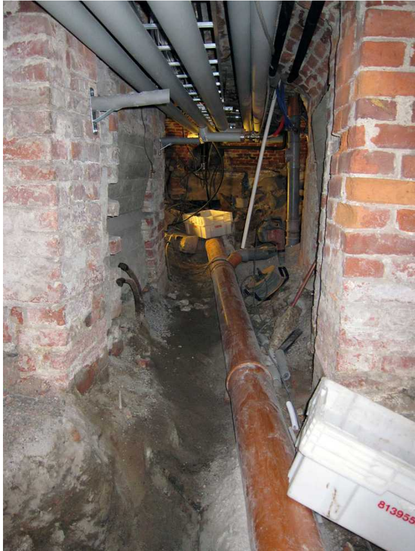
Kuva 13. Kellari 0033. Kellarien 0034 ja 0033 välinen käytävä tilan tyhjentämisen jälkeen. Kuvaussuunta N. 28.6.2011.
