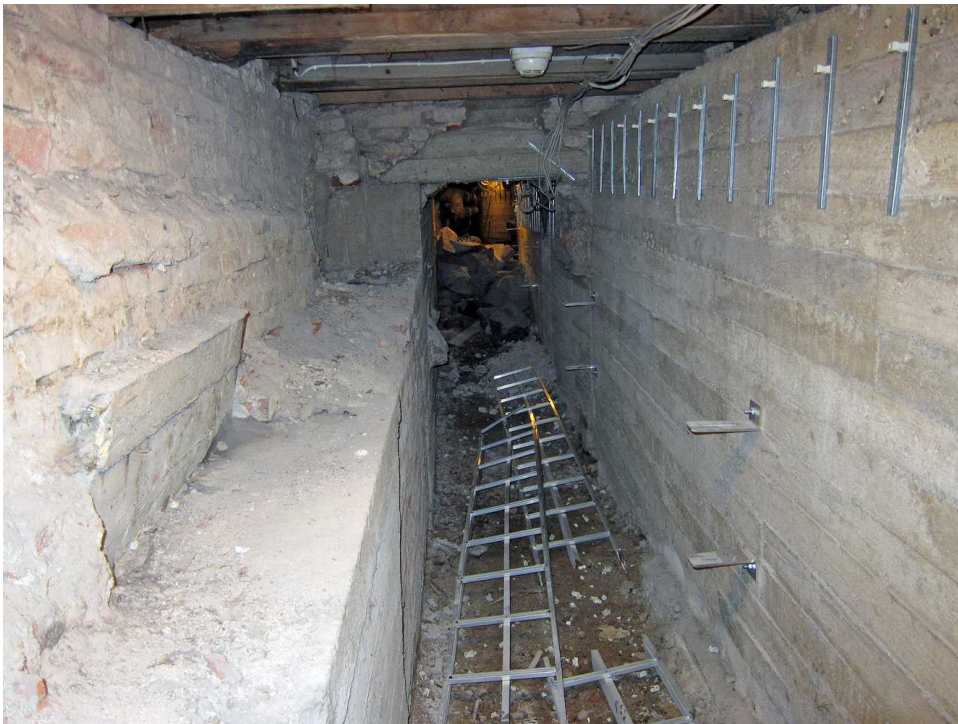
Kuva 231. Kellari 0007, läntinen putkitunneli. Putkitunnelin eteläpää tilan D kohdalla. Kuvaussuunta N. 1.9.2011.
