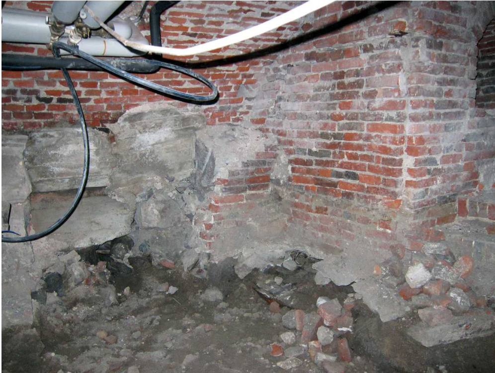
Kuva 9. Kellari 0033. Kellaritilan koilliskulma tyhjentämisen jälkeen. Tiilikorokkeen jäännökset ja sen sisällä olevat perustuskivet näkyvät kulmassa. Sen vasemmalla puolella on mega-paalun kohta. Kuvaussuunta NE. 18.8.2011.
