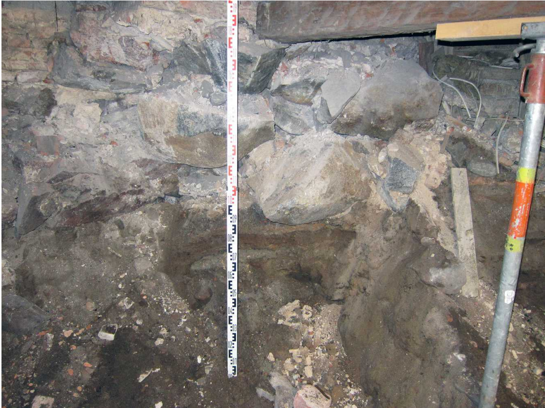
Kuva 209. Kellari 0007, tila C. Tilan keskellä oli laaja kivikasa, joka oli 1. kerroksen uuninperustus. Kuvaussuunta SW. 30.8.2011.
