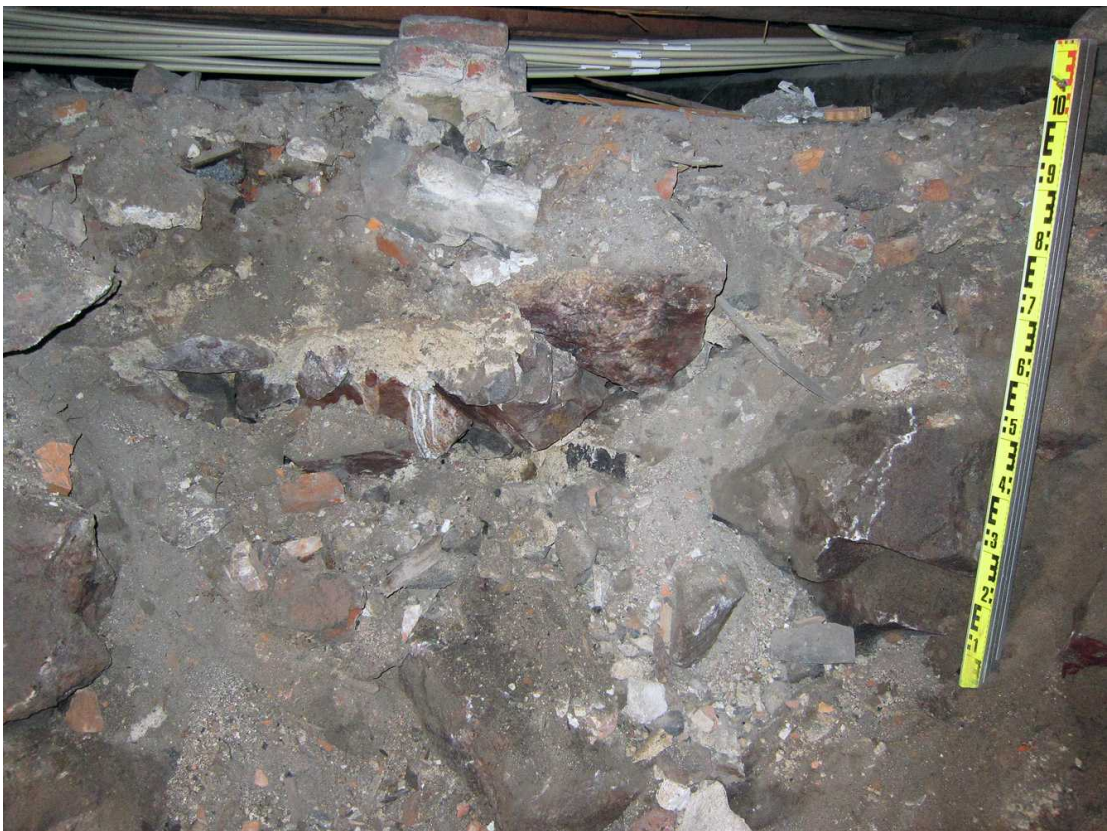
Kuva 138. Kellari 0007, tila A. Edellisen seinämäkohdan keskiosa. Poikittaisen kiviperustuksen päällä on nuoremman SSW-NNE –suuntaisen perustuksen kivi- ja tiilirakennetta. Kuvaussuunta SW. 16.8.2011.
