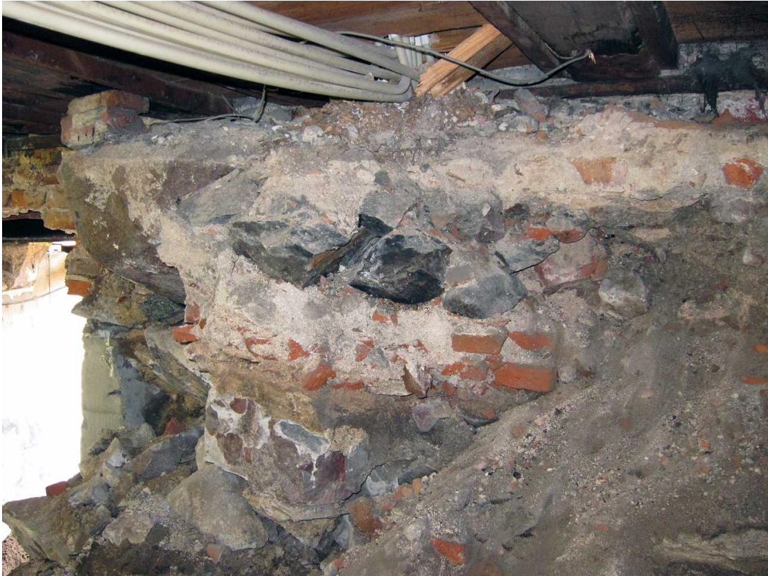
Kuva 133. Kellari 0007, tilat A-B. Aukon eteläpuolella oli tilojen A ja B välisen alkuperäisen käytöstä poistetun ja osittain puretun, 1. kerroksen seinän kiviperustuksen jäännös. Kiviperustus on rikottu tilan tyhjentämisessä kuvan kuntoon. Kuvaussuunta NE. 17.8.2011.
