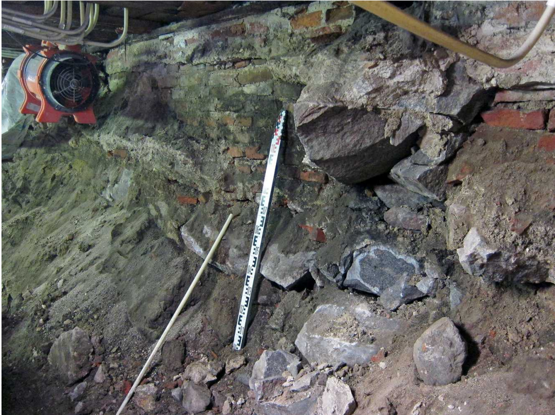
Kuva 203. Kellari 0007, tila C. Läntisen matalan siiven itäseinän perustus ja poikittaisen kiviperustuksen jäännös tilojen B ja C välissä. Kuvaussuunta NE. 30.8.2011.
