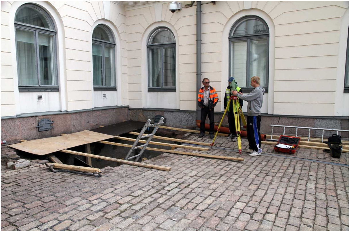
Kuva 79. Etupiha. Dokumentointikohta 9 linnan etupihan koillisnurkassa elokuussa vuonna 2010. Kuoppa kaivettiin perustusten tarkistusta ja mega -paalujen koeponnistusta varten. Kuvaussuunta NE. 27.8.2010.
