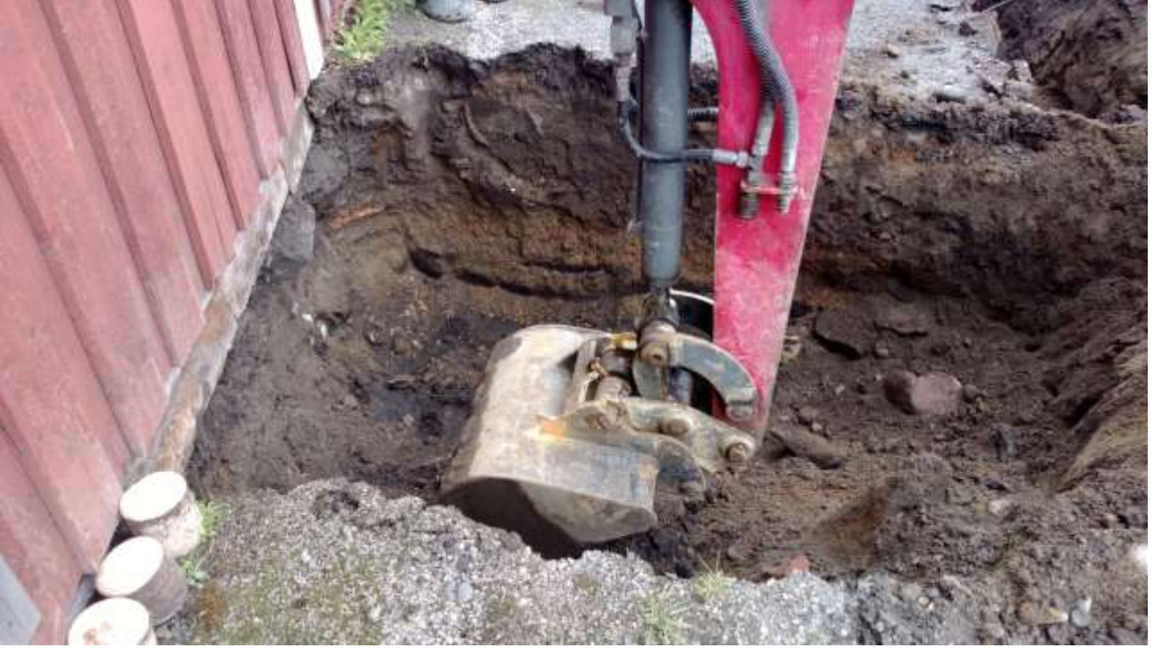
Kuva 1. Putkikaivanto pihan läntisen siiven piharakennuksen edustalla. K.Uotila 17.6.2013. S
