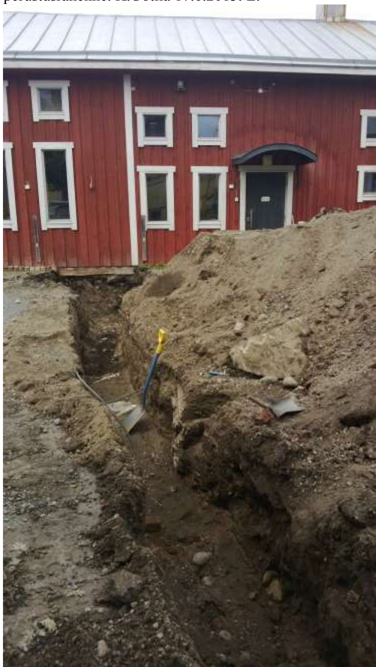
Kuva 2. Putkikaivanto pihan keskiosassa. Kuvan keskiosassa pihalla ollut betoninen perustusrakenne. K.Uotila 17.6.2013. E.
