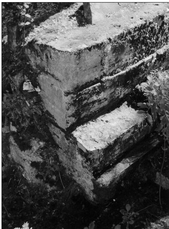
Kuva 10 Taisteluhauta kohteessa II:3.bc. Rintasuojan yläosassa on ponnistusaskelma, jolta voidaan nousta rynnäkköön haudan reunan yli. Liitteessä 8 on piirros haudan profiilista. Kuva V3:9, John Lagerstedt 2003.
