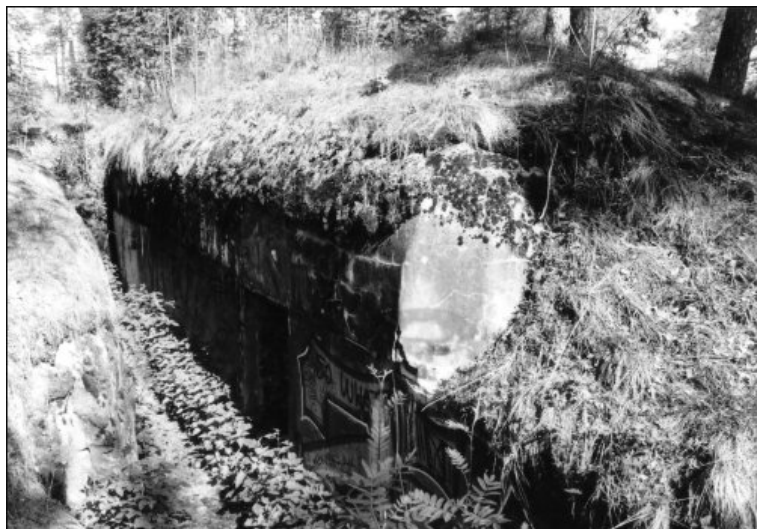
Kuva 24 Kaksiosainen ehjät suojahuone II:7.27. Kuva MV1:29, John Lagerstedt 2003.
