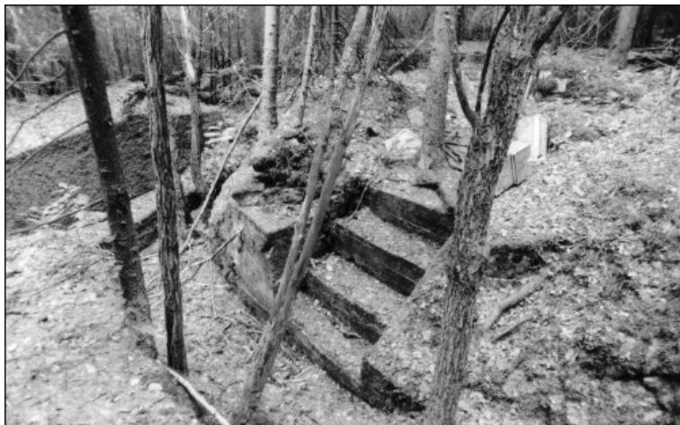
Kuva 19 Betoniset portaat rakenteessa II:1.P2. Kuva MV1:31, John Lagerstedt 2003.
