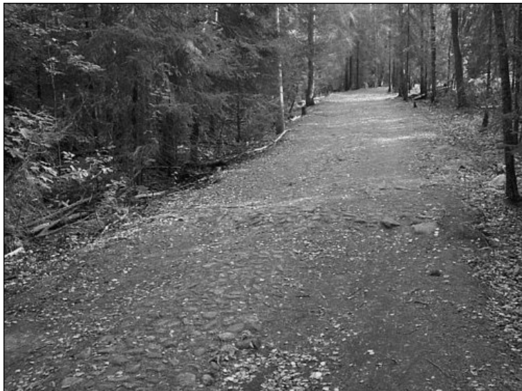
Kuva 15 Tukikohdan II läpi kulkeva mukulakivetty yhdystie II:tie.ag. Kuvan kekiosassa on tien alittavan ojan rumpu. Kuva 4812, John Lagerstedt 2003.
