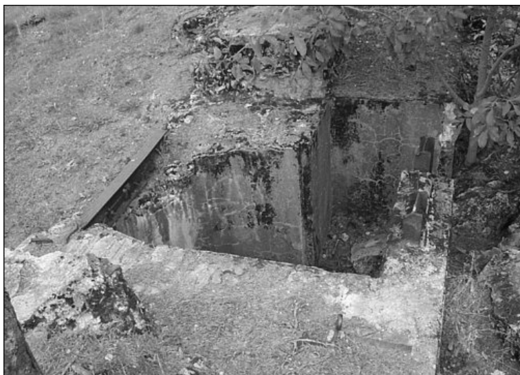
Kuva 13 Tähystysasema II:8.2. Asemaan tullaan oikealta mutkitetun sisäänkäynnin kautta. Tähystysaukko on puhkaistu vasemmalla olevaan teräspalkkiin ja varustettu luukulla. Ks. myös piirrokset asemasta ja tähystysaukosta liitteessä 8. Kuva 4640, John Lagerstedt 2003.
