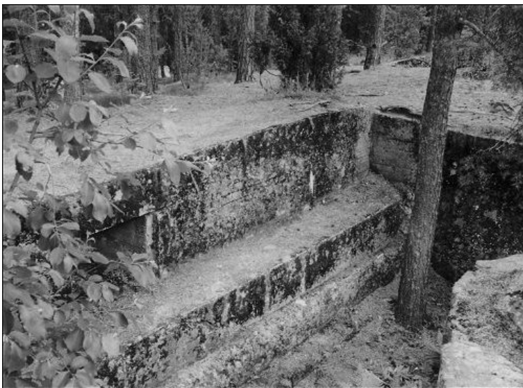
Kuva 9 Betonilla tuettu taisteluhauta II:8.de. Ampumakorokkeelle nousemista helpottaa kapea porraskelma. Vasemmalla ampumatarvikekomero, oikealla betonista valettu sivusuoja eli traverssi Kuva V2:15, John Lagerstedt 2003.
