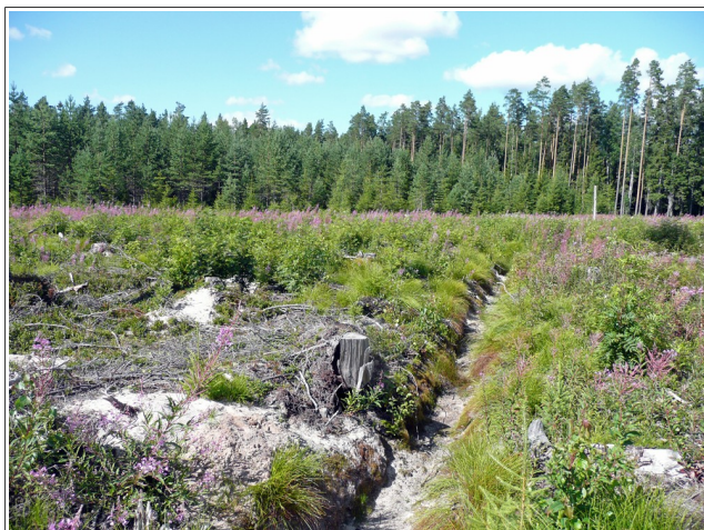
Figur 6. Platsen för vindkraftverket nr. 12. Foto från söder.
