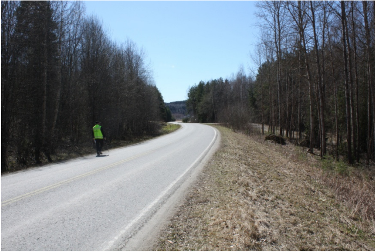
AKDG3157:7. Kevyenliikenteenväylän linjaa Hattulantien vasemmalla puolella. Kuvassa oikealla näkyvä tie vie Luolajan leiriniemiselle muinaisjäännöskohteelle. Koillisesta. Kuva Ville Rohiola, Arkeologiset kenttäpalvelut
