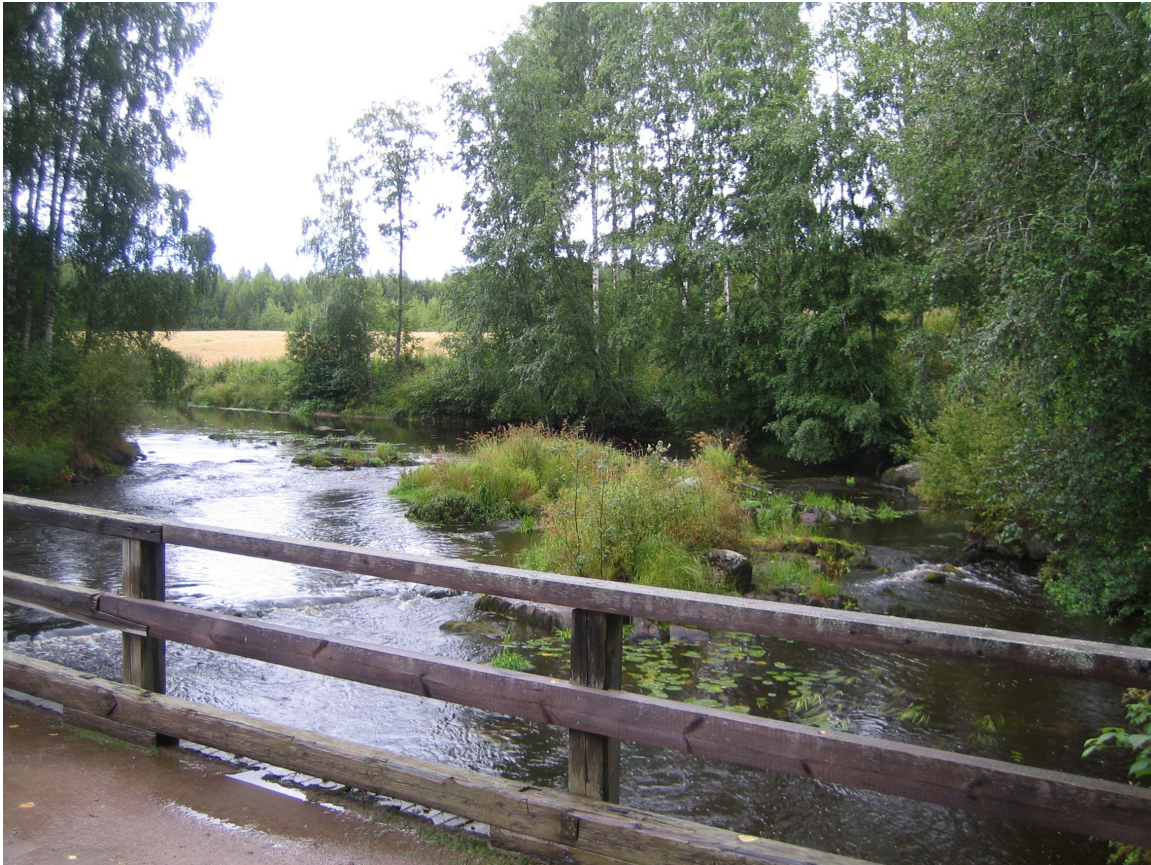
Kuva 3. Kantti Myllykoski. Kuva T. Vasko.
