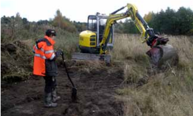
Kuva 7. Pintamaata poistettiin koneellisesti.
