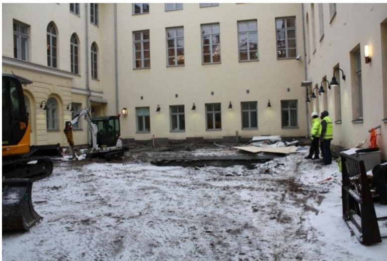
AKDG3164:2 Tutkimusalue käsitti kokonaisuudessaan Presidentinlinnan sisäpihan. Taustalla valvotaan vitriinin purkamista. Kuvaussuunta E-W. Kuva Katja Vuoristo.
