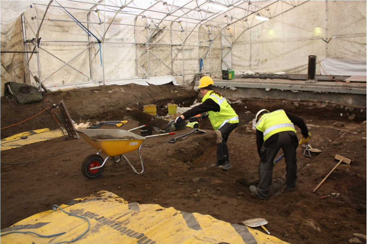
AKDG3164:30 Pihakiveystä R5 otetaan esille. Vieressä olevilla routamatoilla sulatettiin routaantunutta maata. Kuva Katja Vuoristo.
