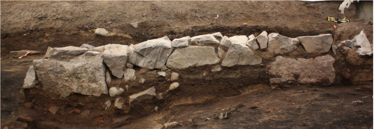
AKDG3164:29 Talonpohjan R8 vitriinin itäpuolelle jäävä kivijalka esiin kaivettuna. Kivijalka oli tehty kaivantoon, joka leikkasi pihakerroksen Y33. Etualalla näkyy palokerros Y101 ja kaivon R124 kohdalle syntynyt vajoama. Kaivo jatkui rakenteen alle. Kuvaussuunta N-S. Kuva Katja Vuoristo.
