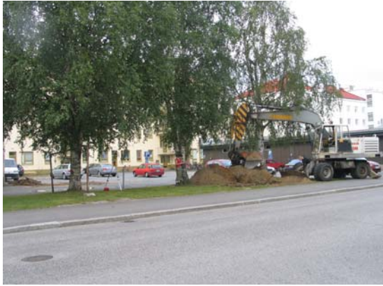
Kuva 9. Koeojaa C kaivetaan tontin I-5-15 viher-alueelle. Kuvattu länteen. Digikuva nro 29. Kuvaaja: Tiia Ikonen, MV/RHO.
