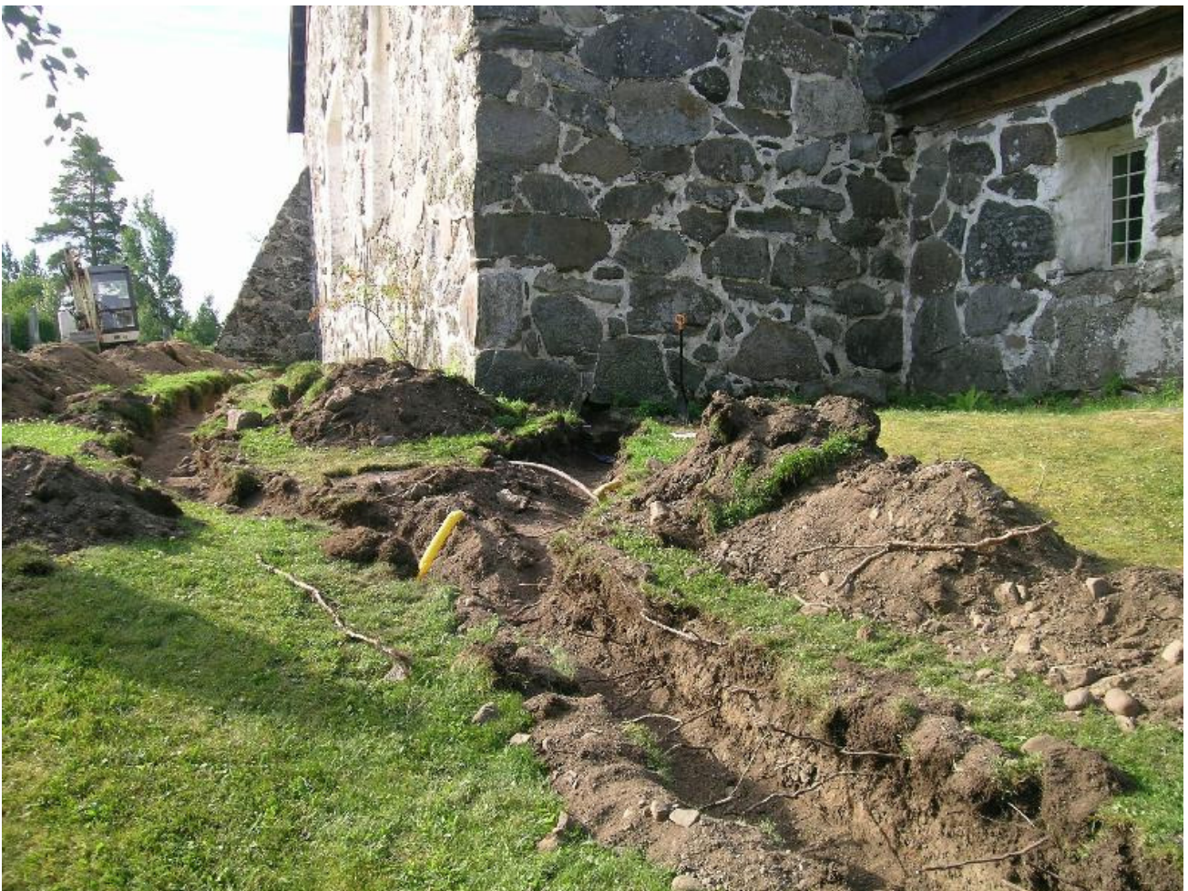
Kuva 1. Valmis kaapelikaivanto kirkon pohjoispuolella ja koilliseenustalla. Kuvaussuunta kaakko. KYY 49:5, 22.7.2010, Eveliina Salo.
