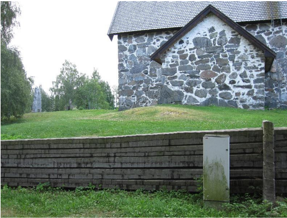
Kuva 2. Sakaristo ja sähkökaappi ennen valvonnan aloittamista. Kuvaussuunta kaakko. KY 49:3, 20.7.2010, Eveliina Salo.
