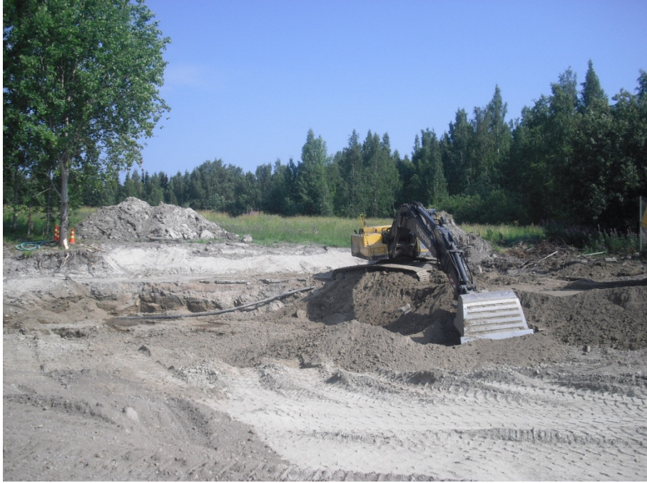
Kuva 10. Kuoppaa täytettynä. Taustalla kaksi peltokerroksesta kaivettua kasaa. Kuvaussuunta SW.
