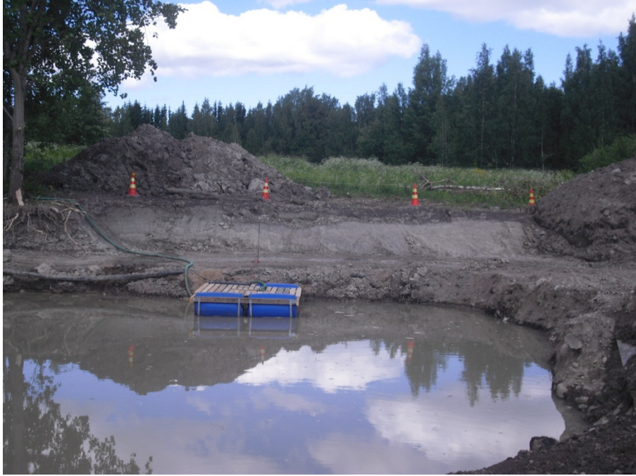
Kuva 9. Tilanne 14.6.2010, pohjaveden poisto käynnissä. Kuvaussuunta SE.
