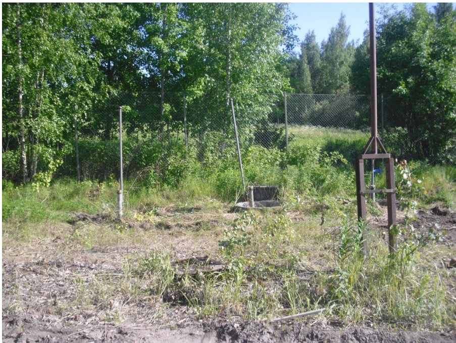
Kuva 1. Tankkauspiste ennen töiden alkua. Etualalla valopylväs, keskellä säiliöiden täyttö- ja ilmastusputket. Takana näkyy verkkoaita, jonka toisella puolella olevalla peltoalueella on Niemen kylän tontti. Kuvaussuunta S.
