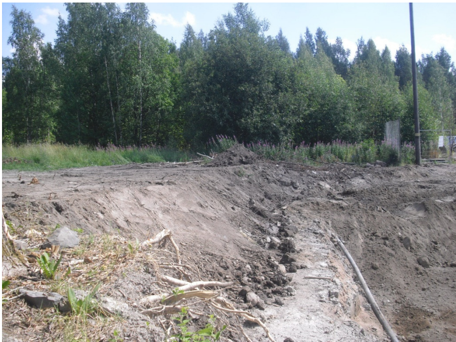
Kuva 12. Peltokerroskasat levitettyinä kaivannon reunaan. Kuvaussuunta W.
