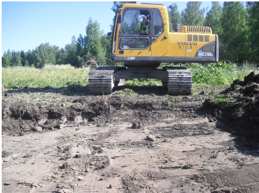
Kuva 7. Kaivannon laajennus noin puolen metrin syvyydessä. Kuvaussuunta S.
