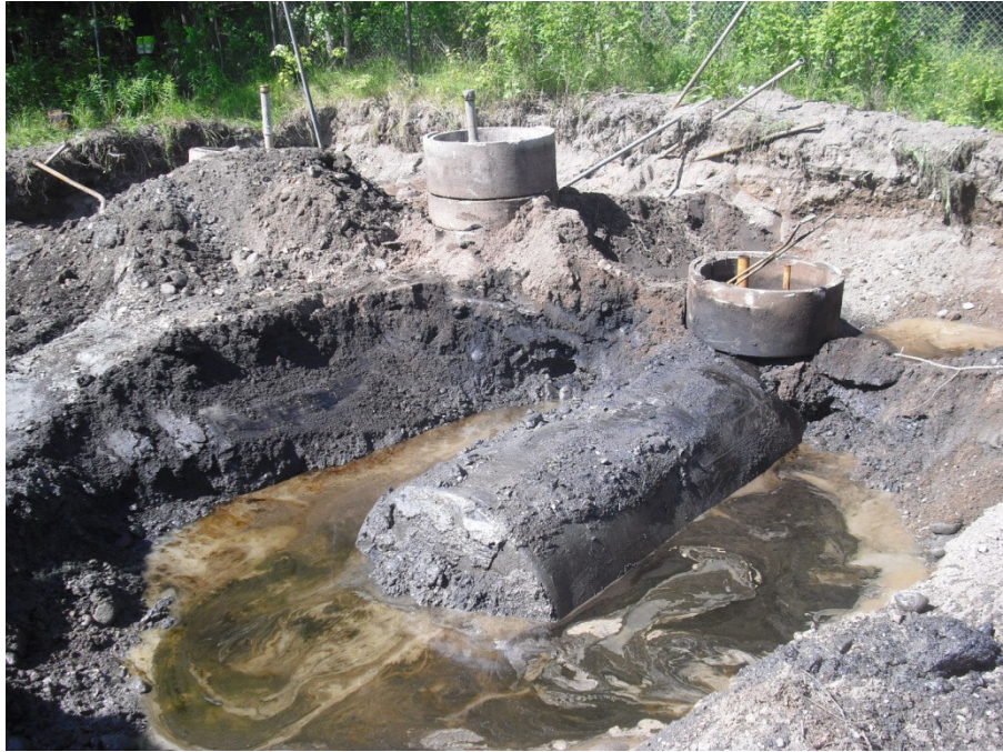
Kuva 5. Ensimmäinen polttoainesäiliö esiin kaivettuna. Kuvaussuunta SE.
