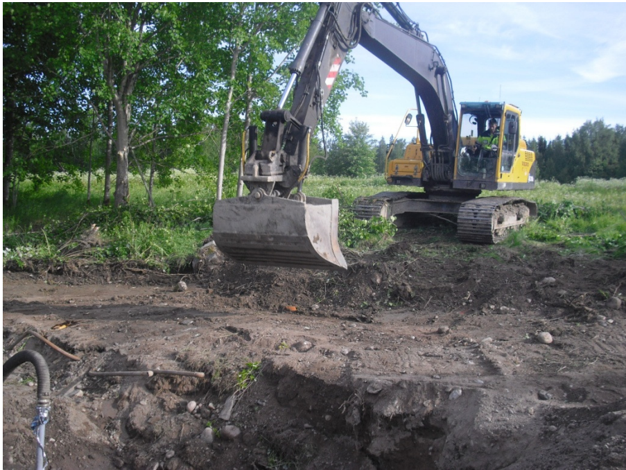
Kuva 4. Verkkoaita poistettu. Kaivinkoneen kohdalla peltoa, joka on historiallisen kylän tonttia. Kuvaussuunta SE.
