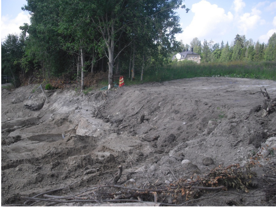
Kuva 11. Peltokerroskasat levitettyinä kaivannon reunaan. Kuvaussuunta SE.
