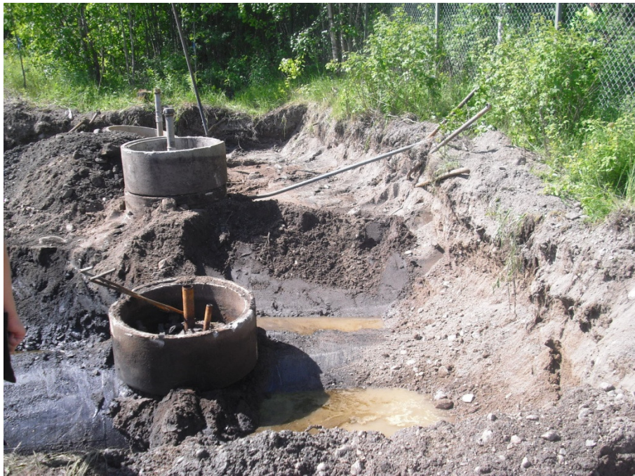
Kuva 3. Polttoainesäiliöt jatkuvat verkkoaidan alle. Kuvaussuunta ESE.
