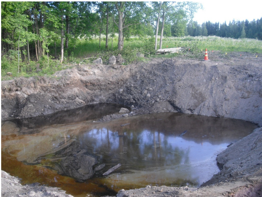
Kuva 6. Polttoainesäiliöt poistettu. Kaivannon syvyys noin kolme metriä. Kuvaussuunta SE.
