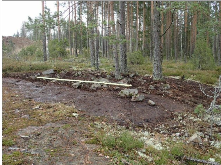
Röykkiö sammalen ja turpeen poiston jälkeen. Kuvattuna lounaasta
