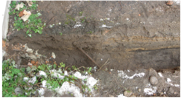
AKDG 3283:6 Kaukolämpöputken kaivannon länsipääty, kuvattu etelästä.
