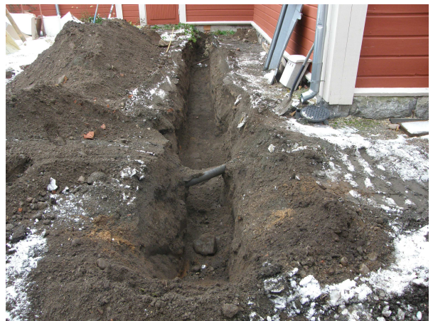
AKDG 3283:4 Kaukolämpöputken kaivannon län- siosa, kuvattu idästä.
