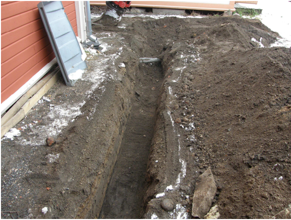
AKDG 3283:5 Kaukolämpöputken kaivannon länsiosa, kuvattu lännestä.
