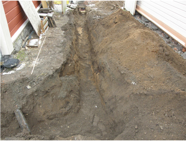
AKDG 3283:10 Kaukolämpöputken kaivannon itäosa, kuvattu etelästä.
