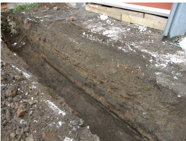
AKDG 3283:8 Säilyneitä kulttuurikerroksia kaukolämpöputkikaivannon länsiosassa, kuvattu kaakosta.
