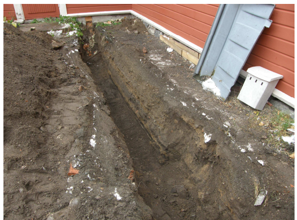
AKDG 3283:9 Kaukolämpöputken kaivannon länsiosa, kuvattu kaakosta.
