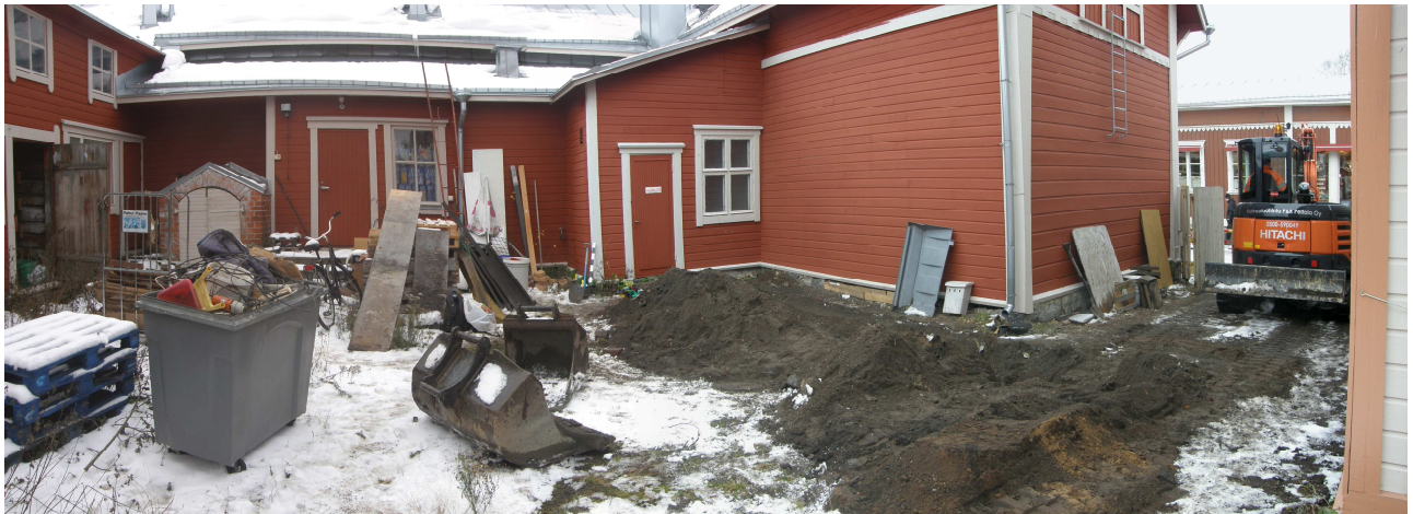
AKDG 3283:2 Tutkimusalue, kuvattu kaakosta.
