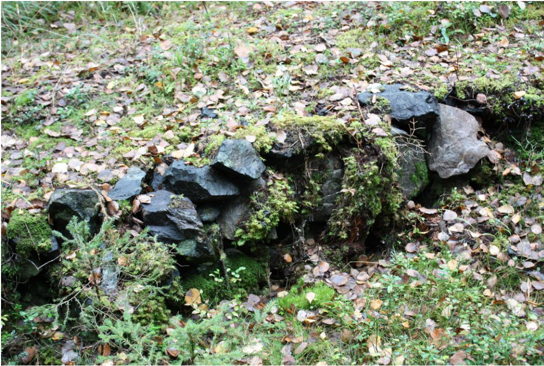
AKDG 3508:1 Lohkokivistä ladottu tienpohja, kuvattu koillisesta.
