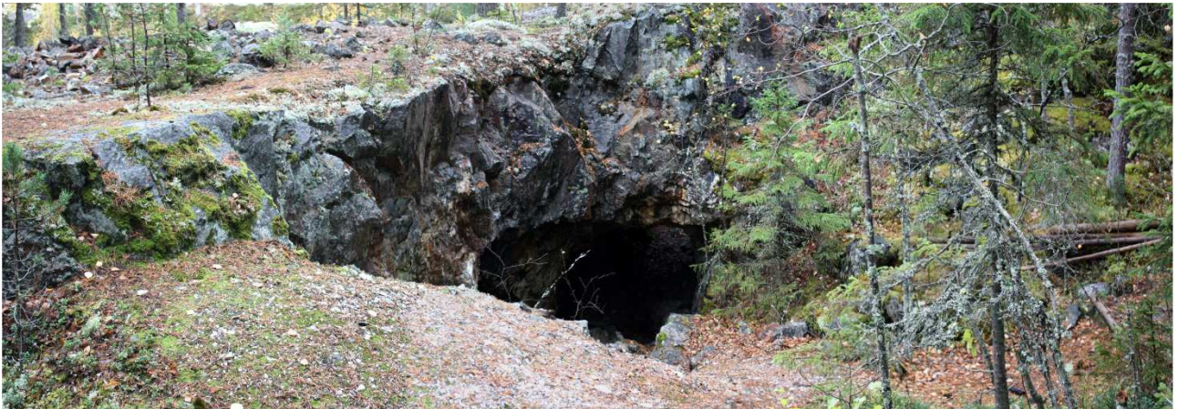
AKDG 3533:2 Näkymä kohti kuilun aukkoa. Kaivoksessa on kaksi kuilukäytävää, jotka ovat noin 1,5 x 1,5 m kokoisia. Kuvattu lounaasta.
