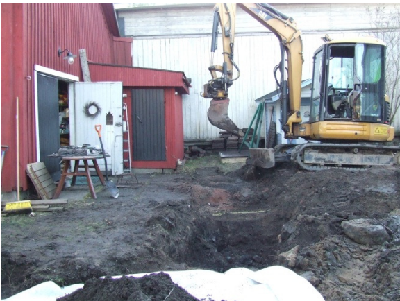
AKDG. 3593:7 Kaivanto C. Pohjoisesta.
