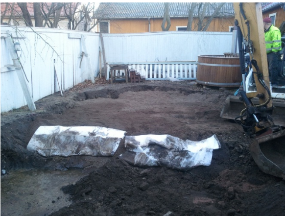
AKDG. 3593:13 Kaivanto B peitettynä sepelillä. Länestä.
