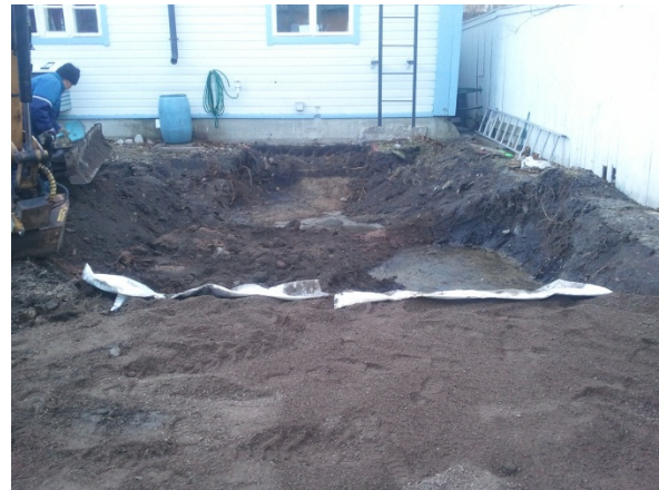
AKDG. 3593:12 Kaivanto A valvonnan päättyessä. Idästä.
