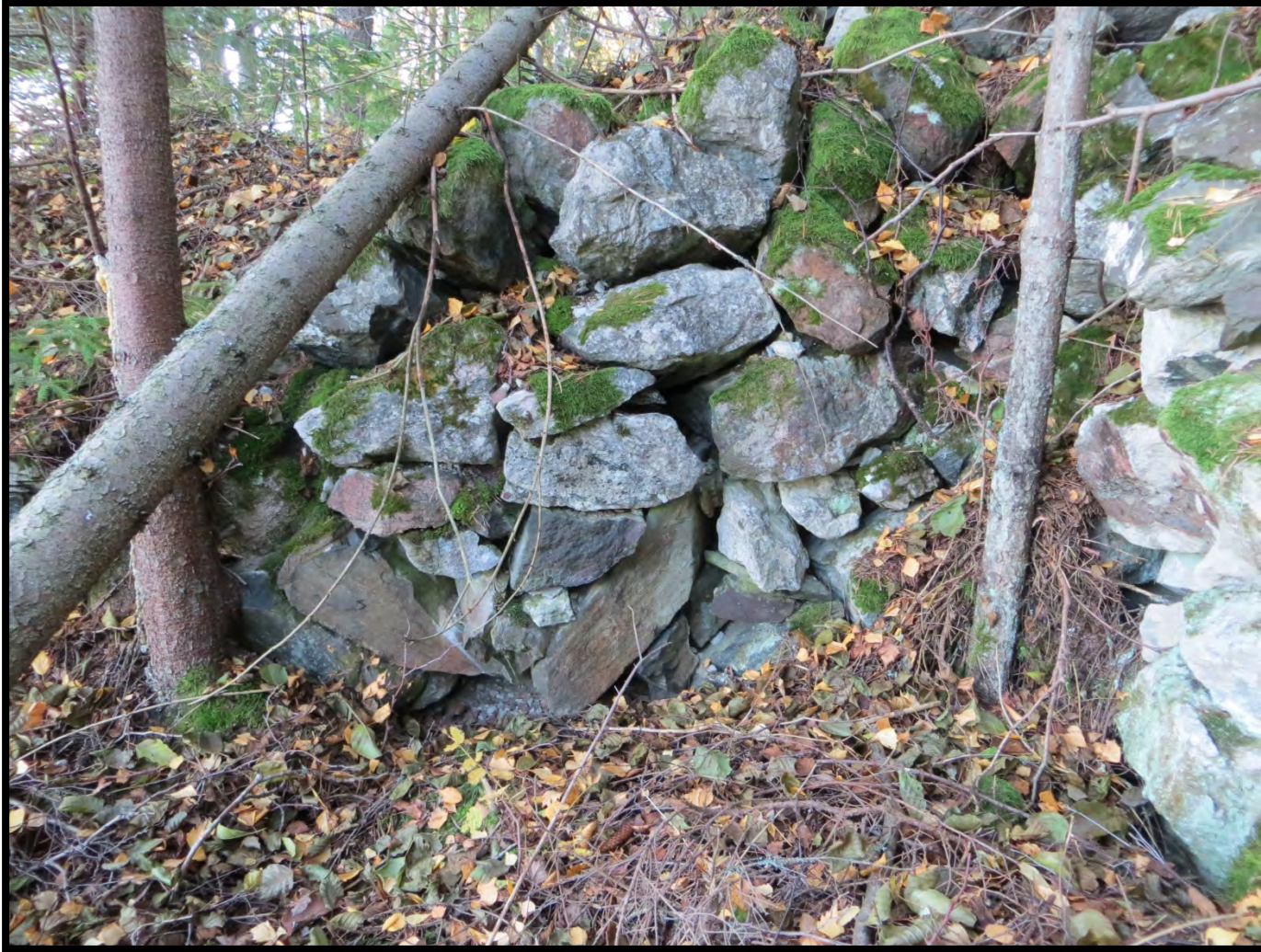
Kuva 17. Kalkudden II, rakenne 1:n ja rinteän välinen kivetty nurkkaus ja ulkopuolella näkyvä suuaukko (alhaalla) lännestä. DT2013:62:071.
