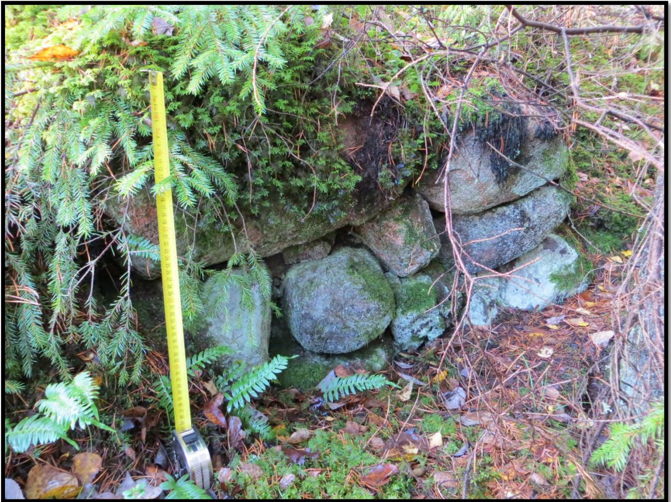
Kuva 56. Byängen, rakenteen (maatalouskalkinpolttouuni?) eteläisen sivuseinämän kivilatomusta. DT2013_62_256
