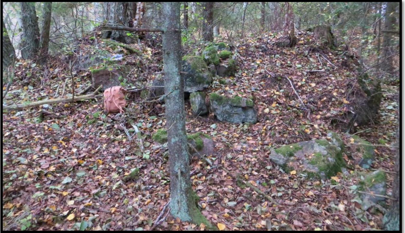
Kuva 22. Näset II, kalkkiuuni (rakenne1) kaakosta. Reppu on suuaukon kohdalla. DT2013_62_107
