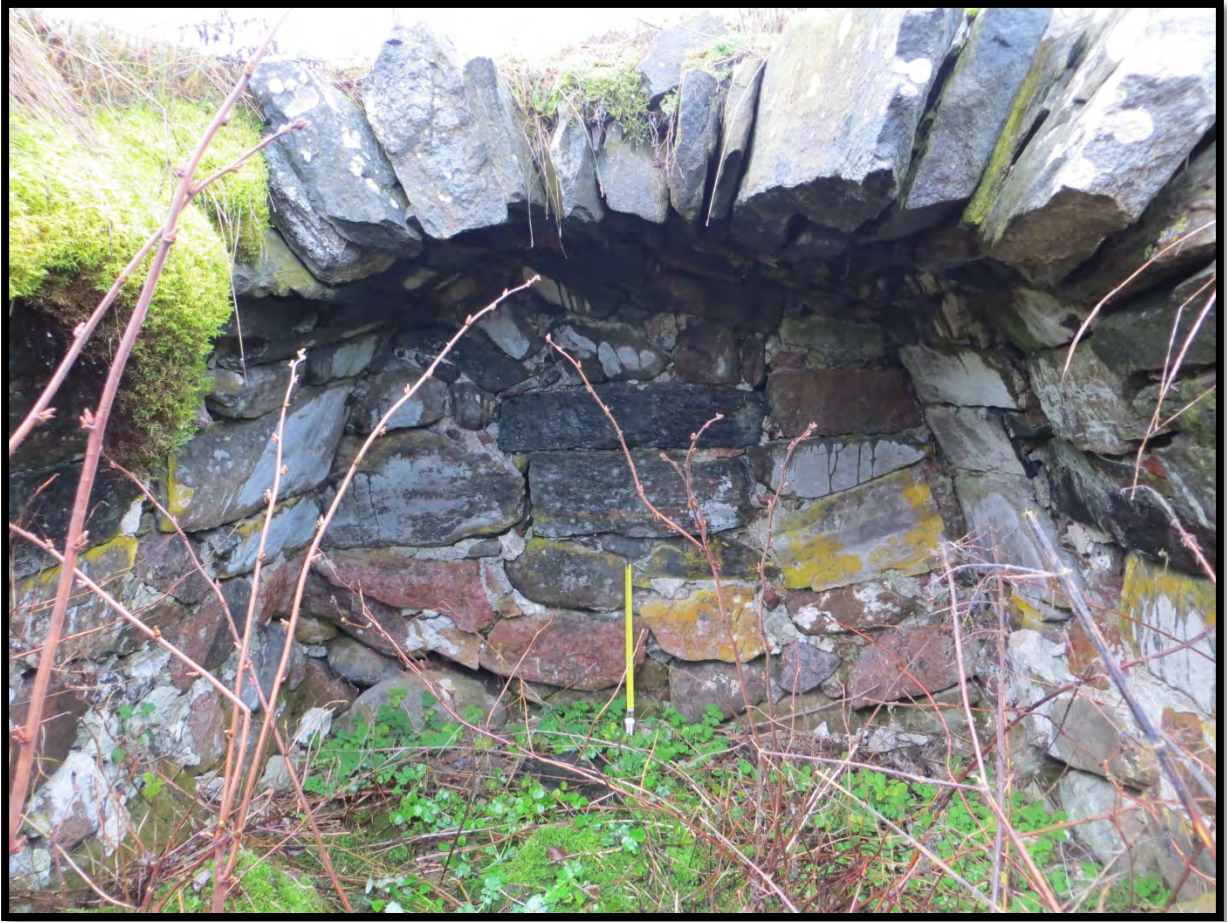
Kuva 86 Sydänperä, Östergårdin tila, holvatun kivikellarin (rakenne 2) peräseinä. DT2013_62_330
