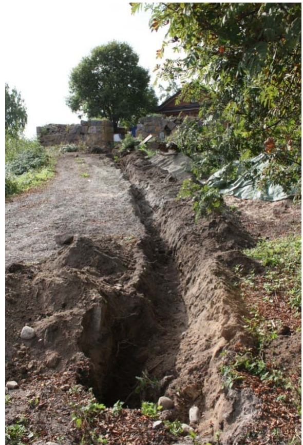
Kuva 6. Koeojan 7 pohjoispääty ja etualalla koekuoppa KK5 pohjoisesta kuvattuna. Kuva Eeva Pettäy.
