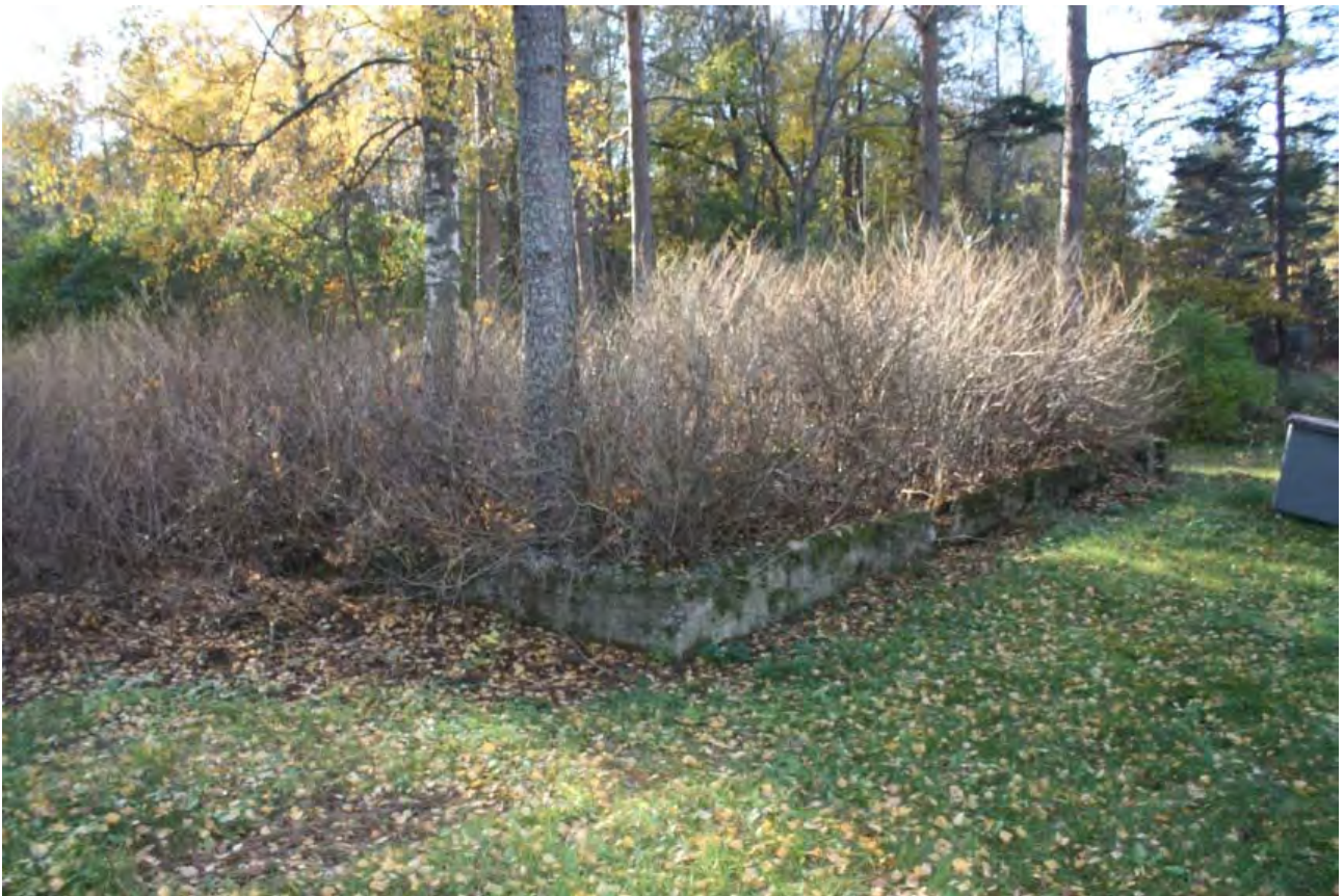
AKDG 3604:2. Viherlahti 5. Betoninen talon sokkeli, koillisesta. Kuvaaja: Petro Pesonen.
