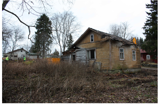
AKDG 3281:2 Tutkimusalue ja purettavana oleva talo, kuvattu kaakosta.
