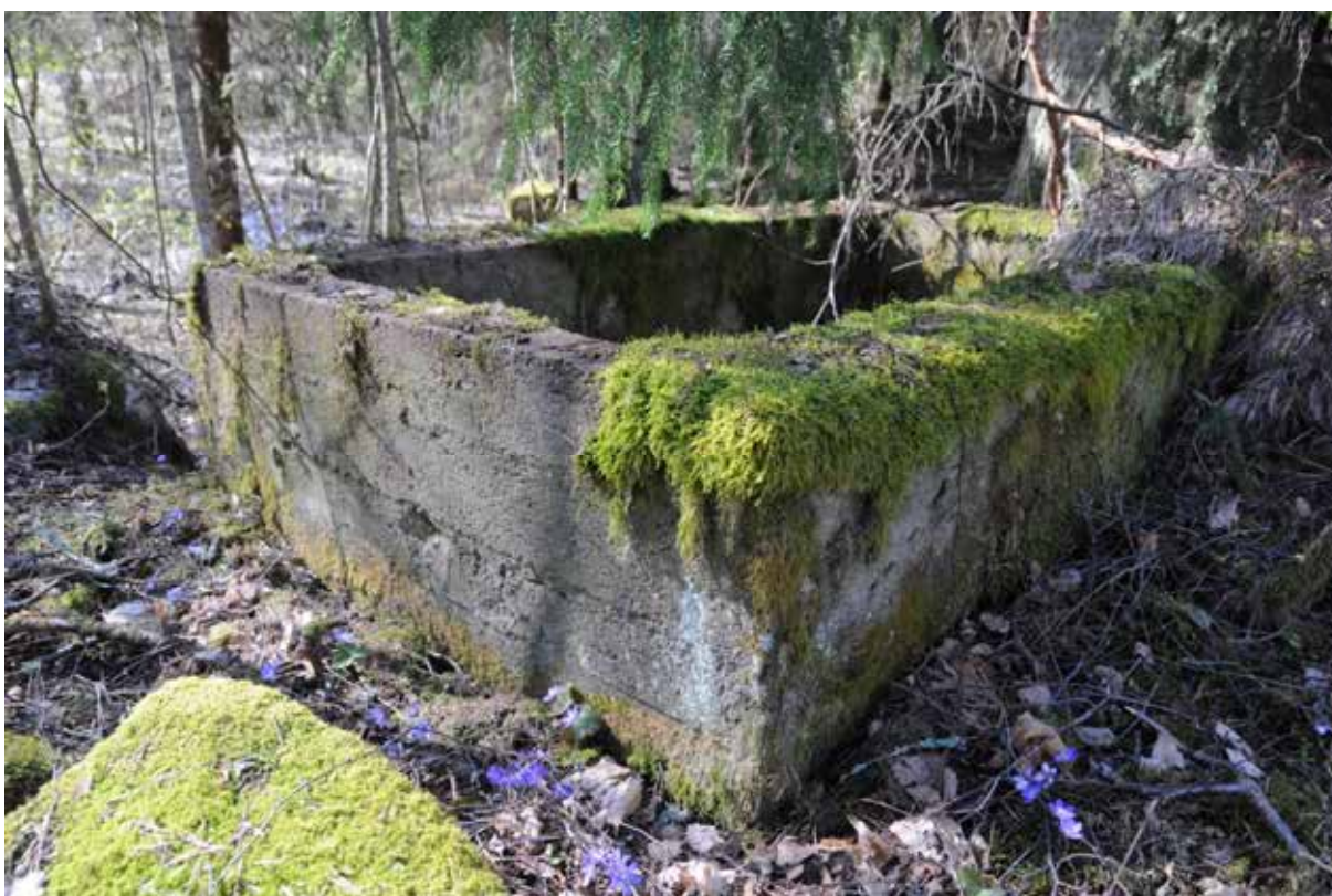
Kuva 108. Lähikuva mahdollisesta kaivosta tai altaasta (rakenne 9). Kuvaussuunta: NW-SE. Kuvaaja: Noora Savunen.
