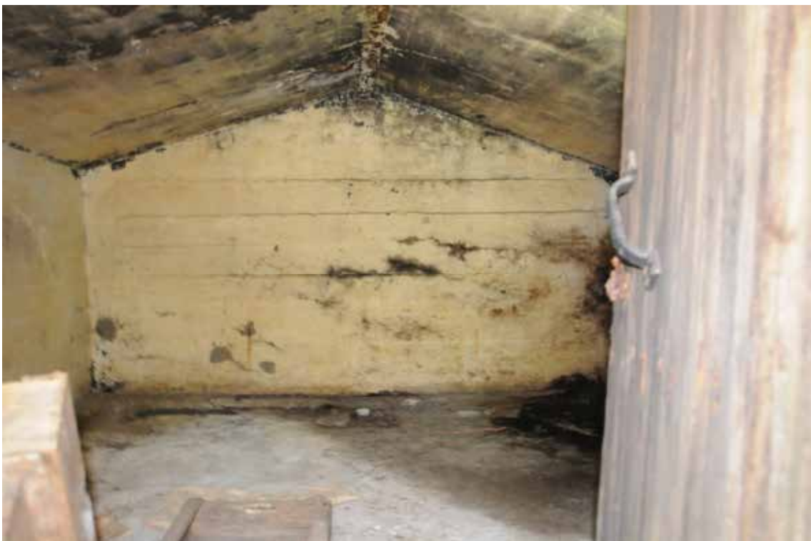
Kuva 113. Yleiskuva kellarin sisätiloista. Kuvaussuunta: S-N. Kuvaaja: Tuire Autio.
