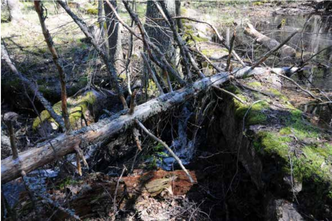
Kuva 116. Lähikuva padosta. Kuvaussuunta: S-N. Kuvaaja: Tuire Autio.
