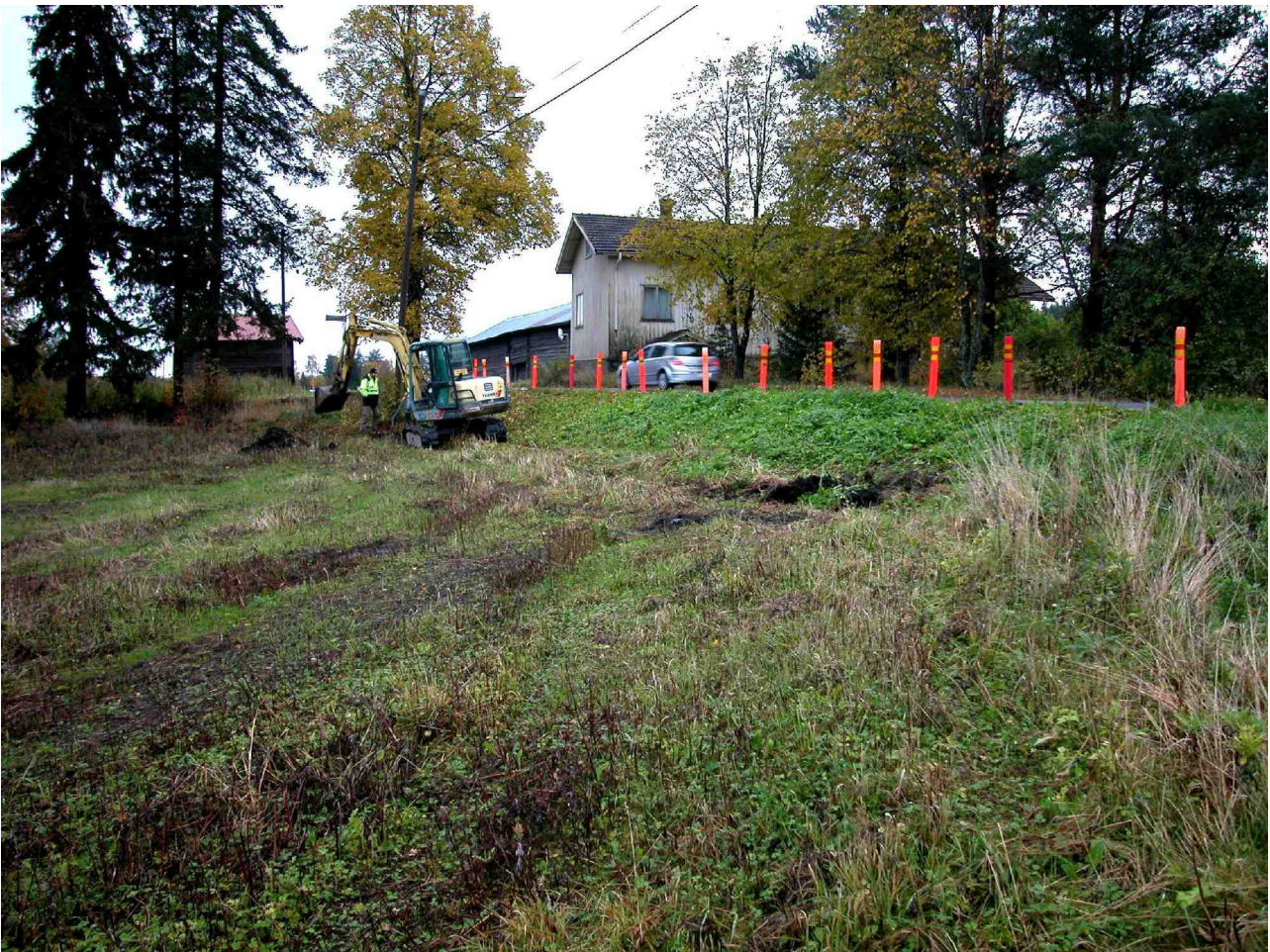
Kuva 3. Tursiannotkon itärinne ja Sapalan rinnepelto koilliseen päin katsottuna. Kaivausalueen B-osaa avataan koneellisesti Anian rantatien varteen. Taustalla Kaipilan autio tilakeskus Anian rantatien toisella puolella ja harmaa Kaipilan aitta kuvan vasemmassa yläkulmassa. Kierikantie kääntyy Anian rantatieltä länsilounaaseen kuvassa näkyvän kaivinkoneen ja Kaipilan aitan välistä. Kuvaaja: Sami Raninen. KYY 109:005.
