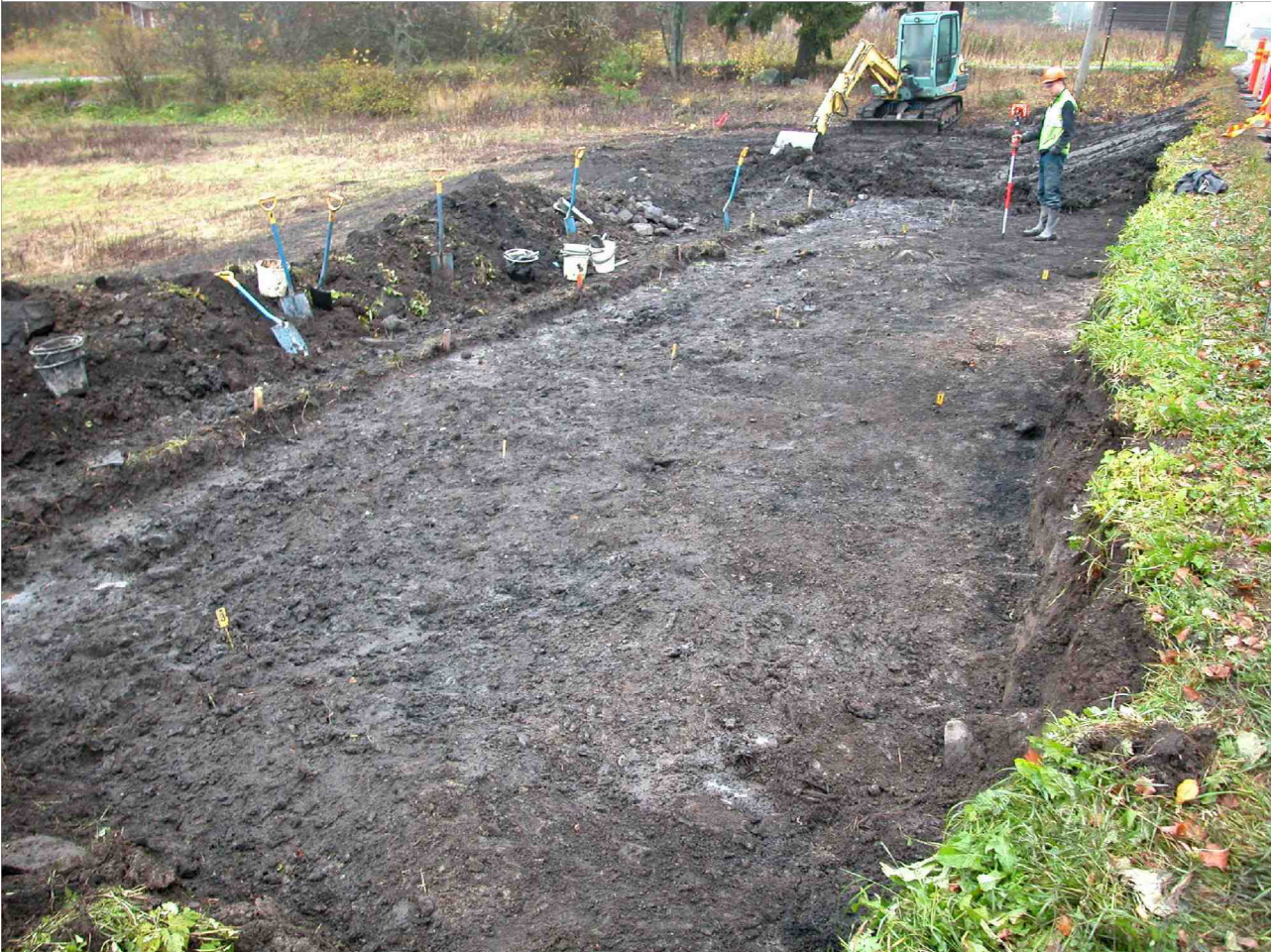
Kuva 8. A-alueen 1. dokumentointitasoa vaaitaan. Suurinta osaa alueesta peittävä mustanharmaa savimaa on yksikköä Y1, jonka päällä on vielä jonkin verran tieluiskan täytemaata. Pintamaata (tieluiska ja pellon muokkauskerros) on poistettu leveämmällä kaistaleella kuin mitä loppujen lopuksi kaivettiin (vert. kuva 9). B-alue A-alueen koillispuolella on jo kaivettu pohjaan ja täytetty. Taustalla kulkee Kierikantie. Kuvattu koilliseen. Kuvaaja: Sami Raninen. KYY 109 :074.
