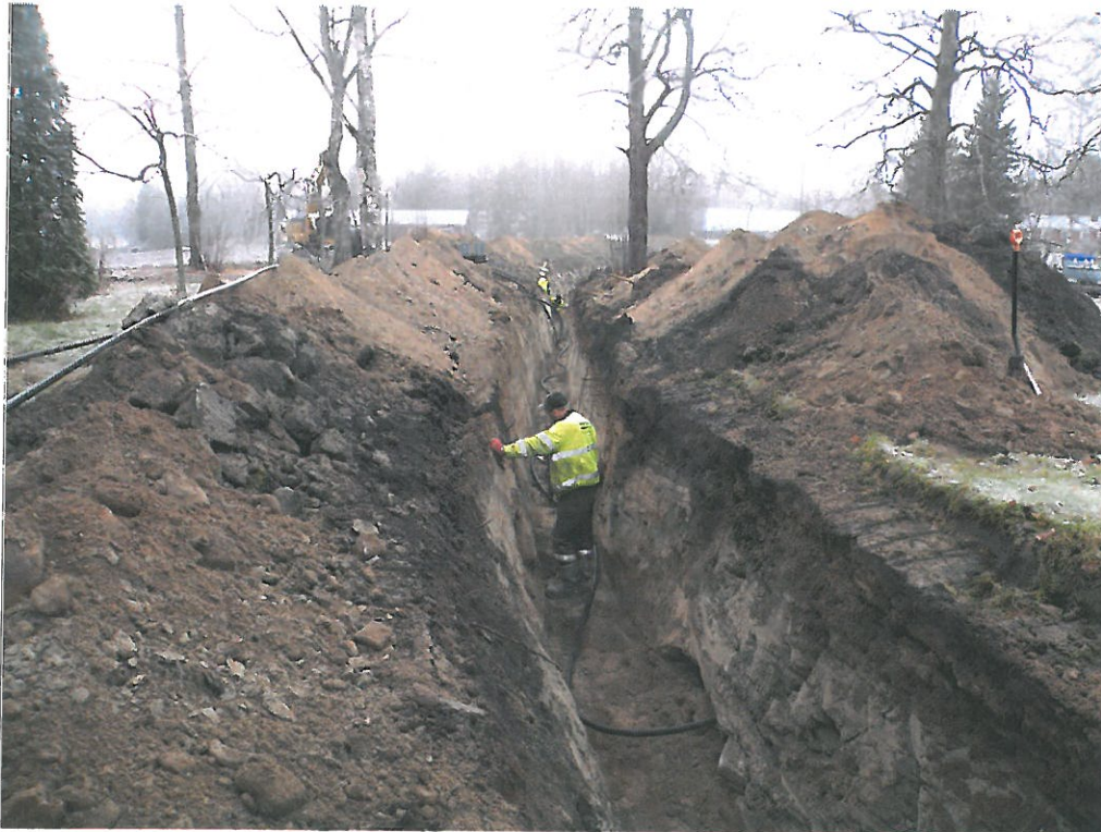
Kuva 4. Vesihuoltolinjaa asennetaan Ikaalisten Vatulan kylänpaikalla Näkän talon lounaispuolella. KYY 27: 5 (Kalle Luoto. PMM/KYY).
