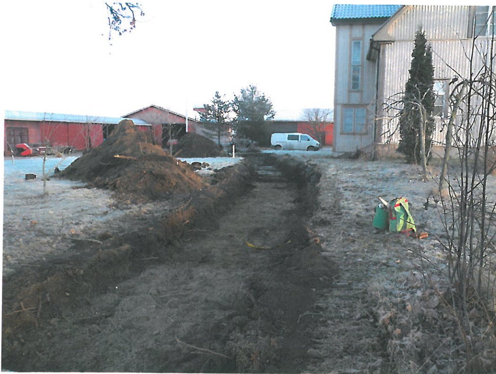
Kuva 2. Vesihuoltolinjaa kaivetaan Ikaalisten Vatulan kylänpaikalla Näkän talon pihapiirissä. Puutarhamulta poistettu. KY 27:2 (Kalle Luoto. PMM/KYY).
