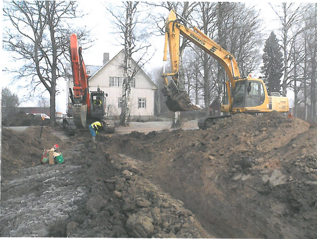
Kuva 3. Vesihuoltolinjaa kaivetaan Ikaalisten Vatulan kylänpaikalla Näkän talon lounaispuolella. KYY 27: 4 (Kalle Luoto. PMM/KYY).
