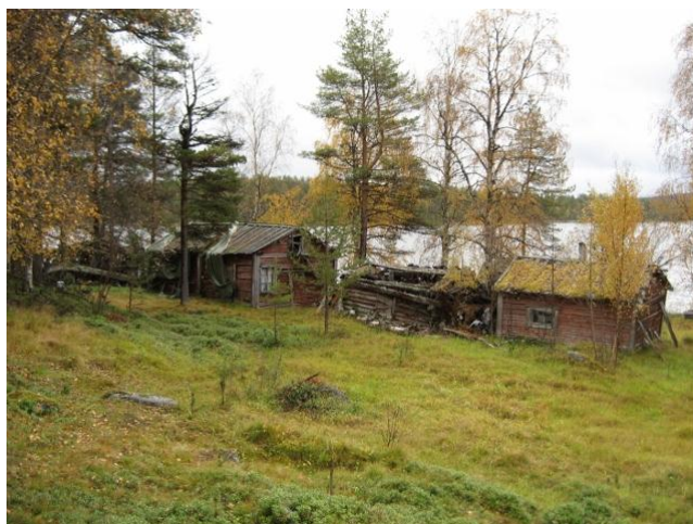
Kuva 038 Tullâjâvri, Yleiskuva vanhoista rakennuksista 1, 2 ja 3, kuvattu luoteesta.
