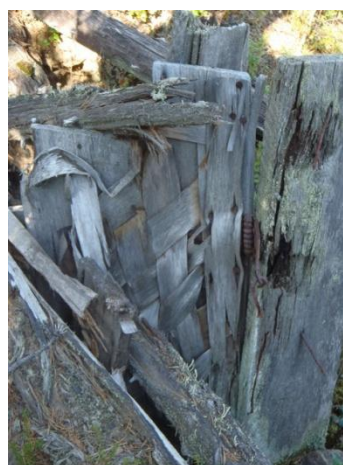
Korsu 7 ovi on päällystetty päreristikolla.
