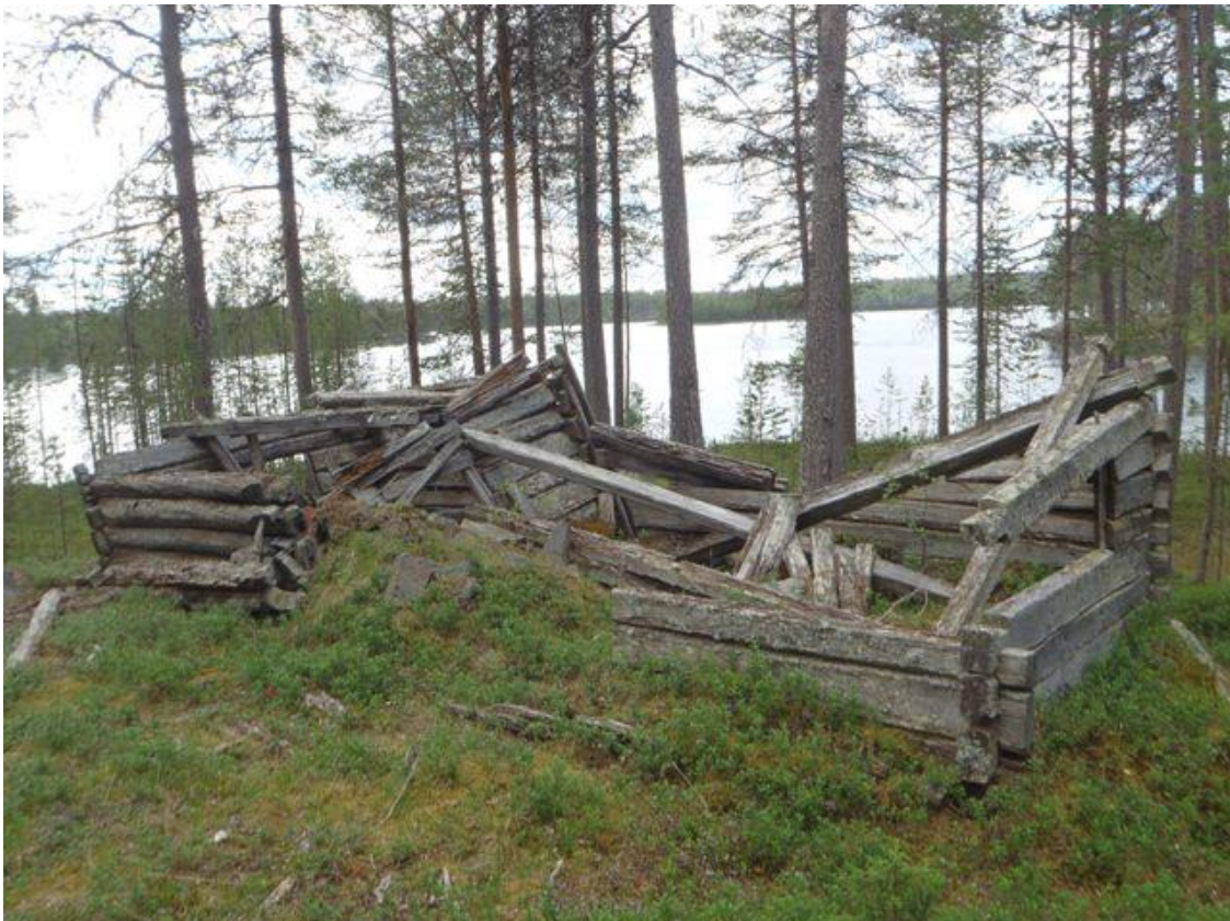
Rakennus on lähellä Keskimöjärven rantaa, kuvaussuunta etelään.
