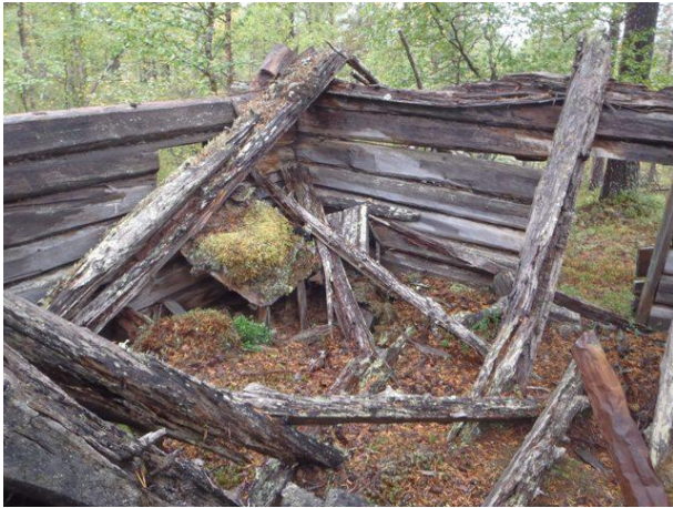
Kämppä 1 sisältä, kuvattu lounaaseen.
