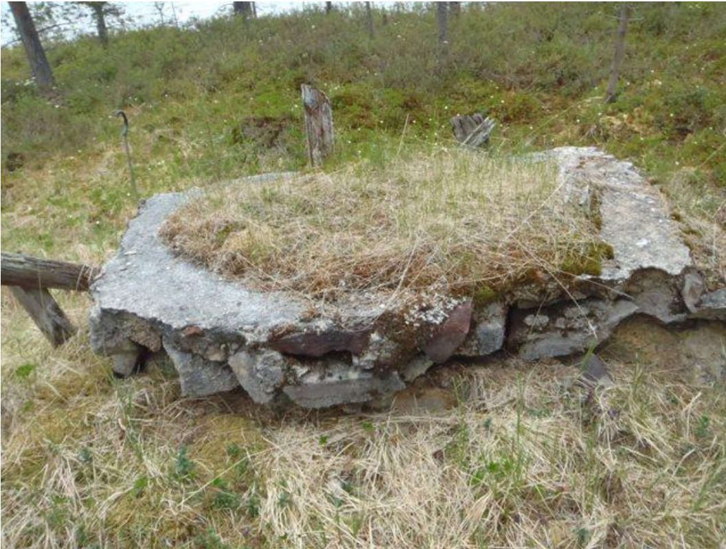
Lieden betonilaatta on valettu paikalla. Kuvattu pohjoiseen.
