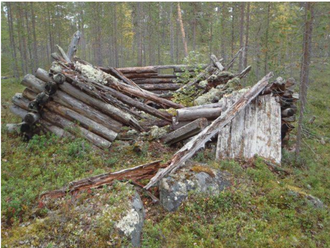
Sauna on varsin hyvin säilynyt, kuvattu koilliseen.
