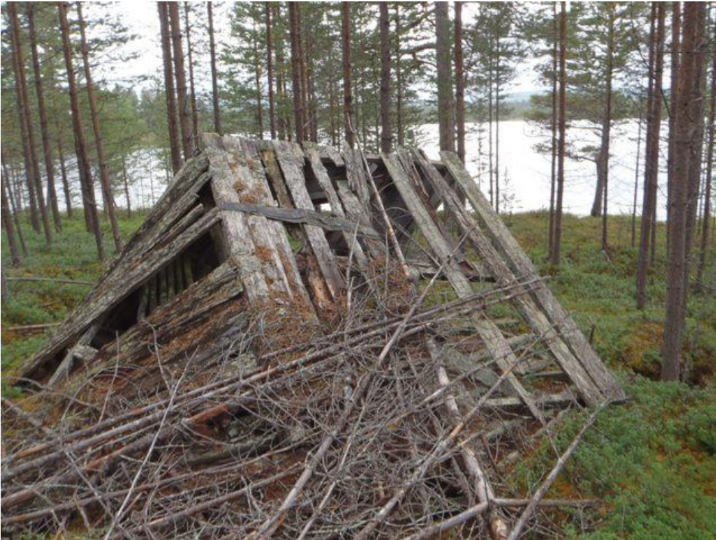
Rakennelma 2 on osittain sortunut, kuvattu lounaaseen.
