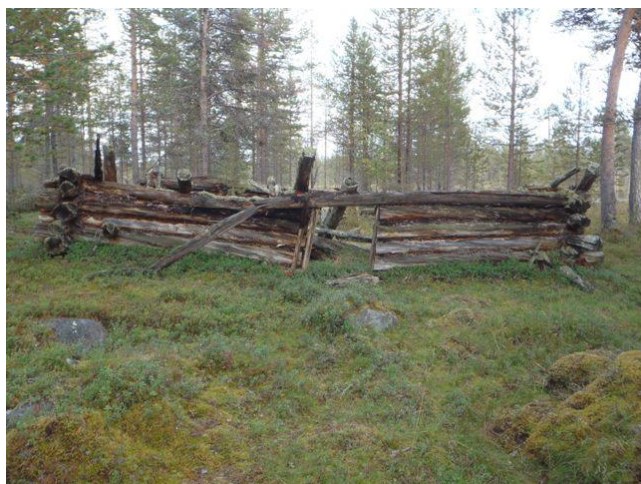
Yleiskuva kämpästä, kuvattu koilliseen.
