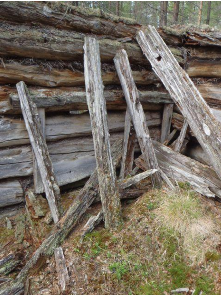
Kämpän seinässä on nukkumalaverin tukipuita, edessä muutamia kattopuita.
