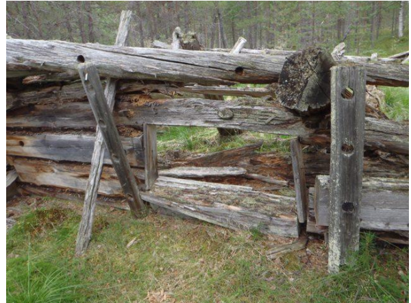
Pääkämpän väliseinän ikkuna on tuettu puutapein kiinnitetyillä puilla.
