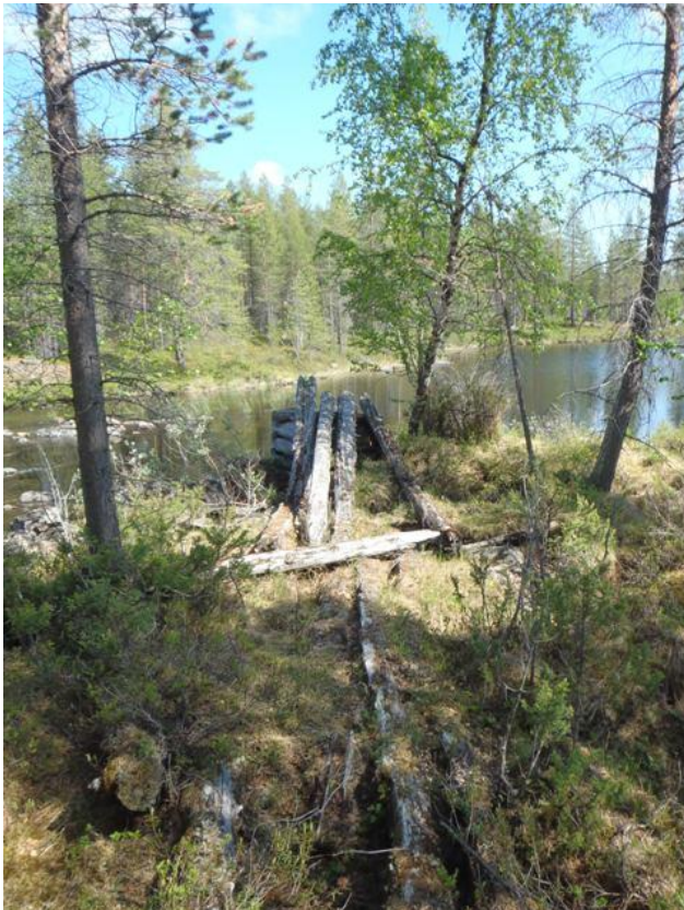
Siltarakenne kuvattuna itään.
