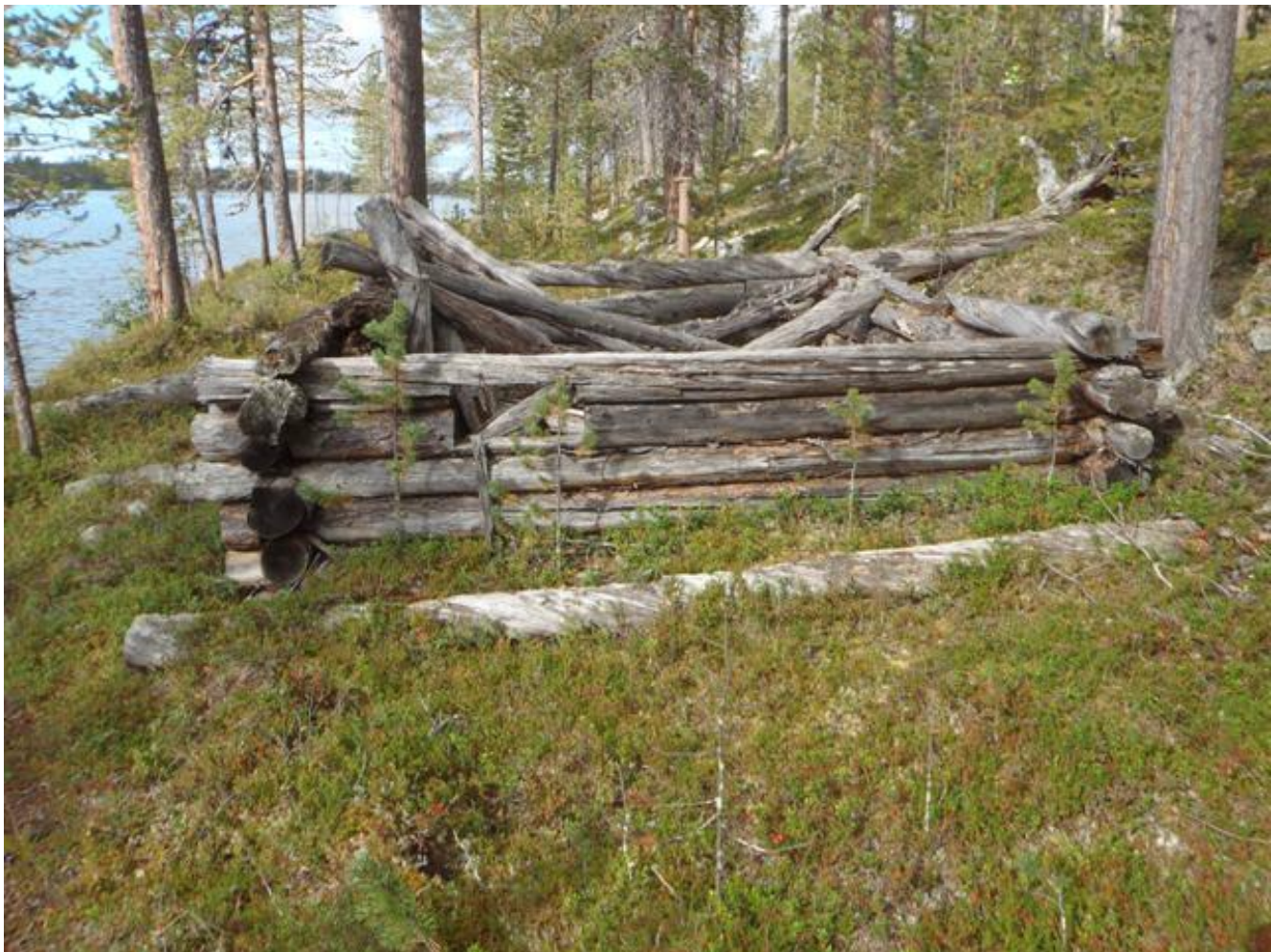
Yleiskuva kämpästä, kuvaussuunta luoteeseen.
