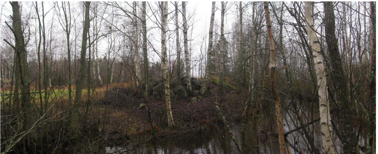
Kuva 6. Valkeakoski Korentinoja, sillan maatuen jäännökset Korentinojan länsipuolella vastarannalta kuvattuna. Kohti NW. 14.11.2012, Kerkko Nordqvist.
