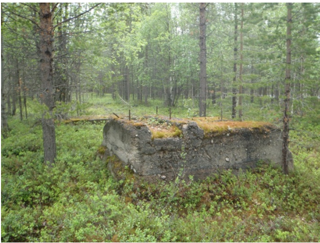
Betonivalut 1 kuvattuna itään.
