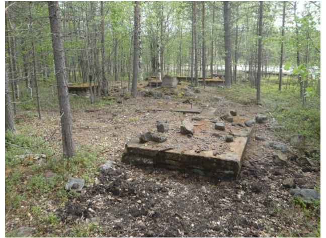
Rannassa sijaitsevan rakennuksen betoniperustusta kuvattuna kaakkoon.
