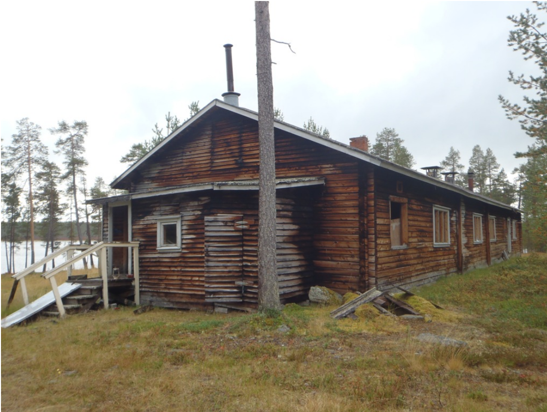
Pääkämpän itäpääty ja pohjoisseinä kuvattuna länsiluoteeseen.
