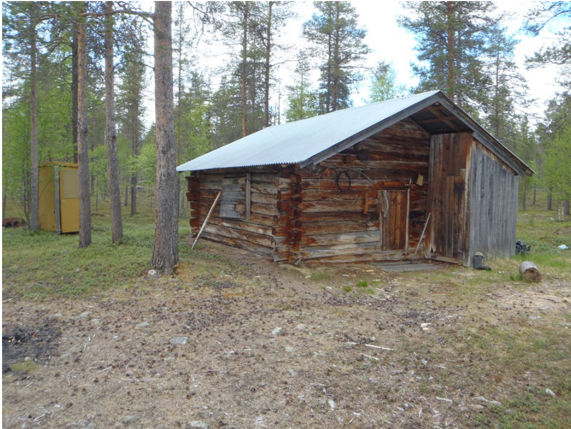
Porokämpän etuovi ja ulkokäymälä kuvattuna pohjoisluoteeseen.
