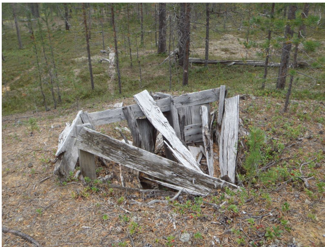
Kellarin jäännös hiekkamaassa. Kuva otettu luoteeseen.
