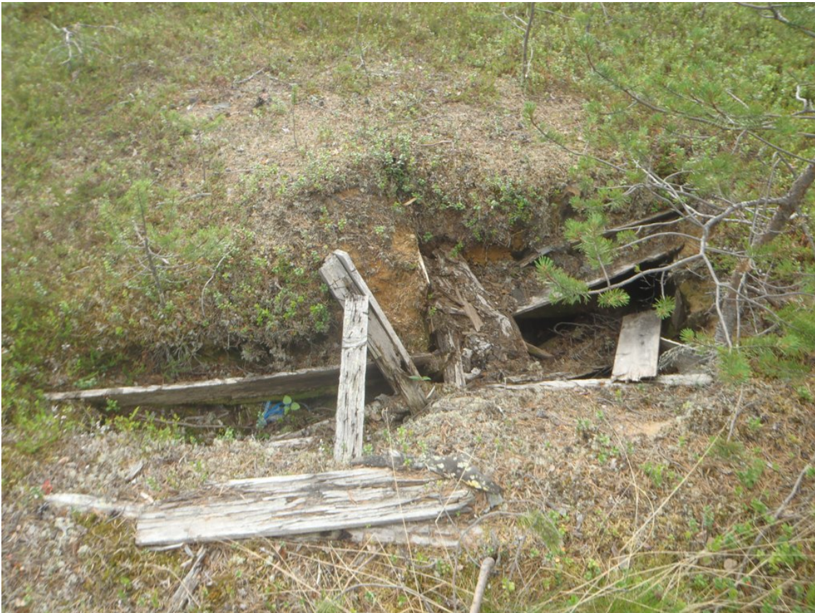
Maahan kaivetun ja laudoilla tuetun kalakellarin jäänteet. Kuvaussuunta on länteen.
